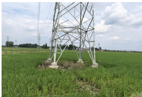
3、邓寿安支线 N5 塔位现状
