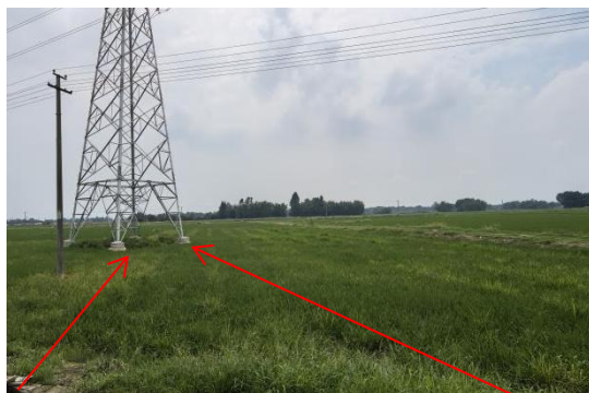
13、庄园—解林 N18 塔位施工道路现状
