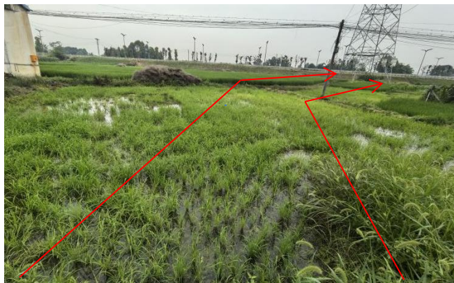
15、苏场—邛崃 N41 塔位施工道路现状
