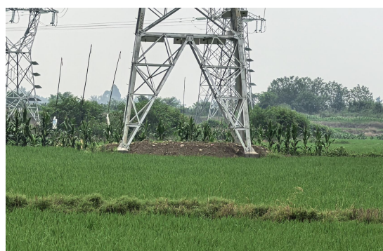
苏场—邛崃 N19 塔位现状（基面植被未恢复）
