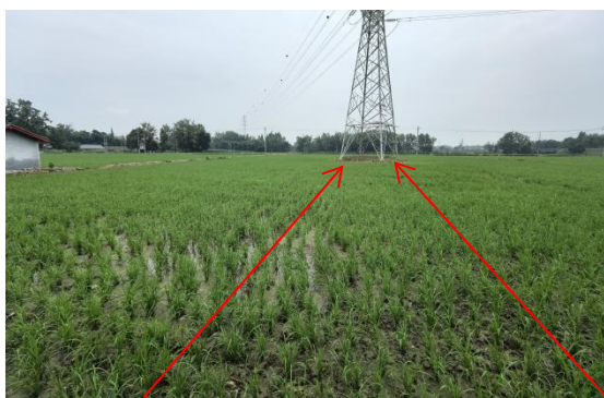
16、苏场—福田 N26 塔位施工道路现状
