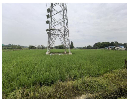
19、苏场—邛崃 N34 塔位现状
