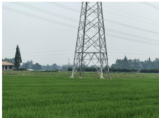
2、高埂—赵塔 N5 塔位现状
