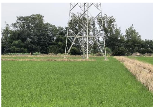
6、邓寿安支线 N16 塔位现状
