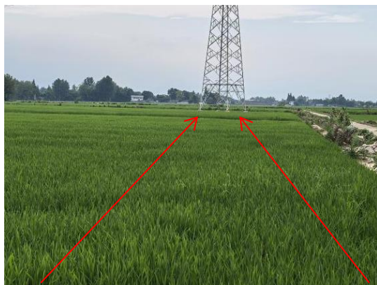
8、邓寿安支线 N25 塔位施工道路现状
