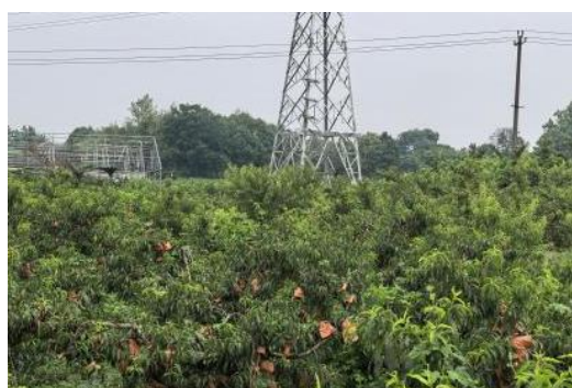
10、苏场—邛崃 N20 塔位现状
