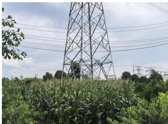
1、高埂—赵塔 N2 塔位现状
