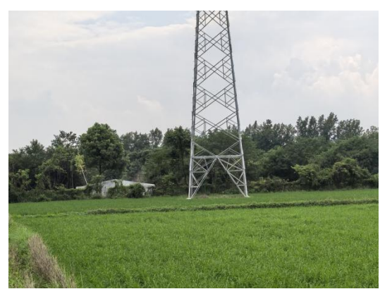
6、庄园—解林 N36 塔位现状
