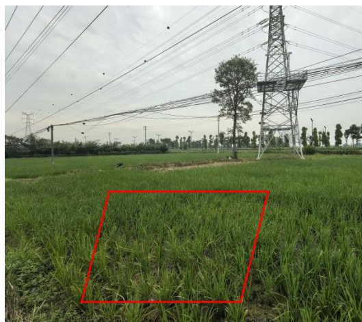
21、苏场—邛崃 N42 塔位牵张场现状
