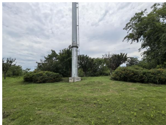
3、高埂—赵塔 N36 塔位现状
