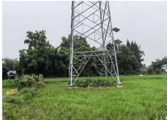
8、苏场—福田 N24 塔位现状
