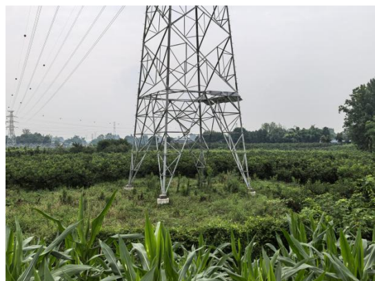
18、苏场—邛崃 N21 塔位现状
