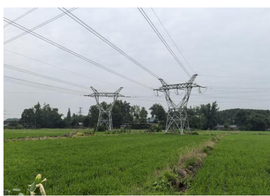
15、苏场—福田 N42 塔位现状
