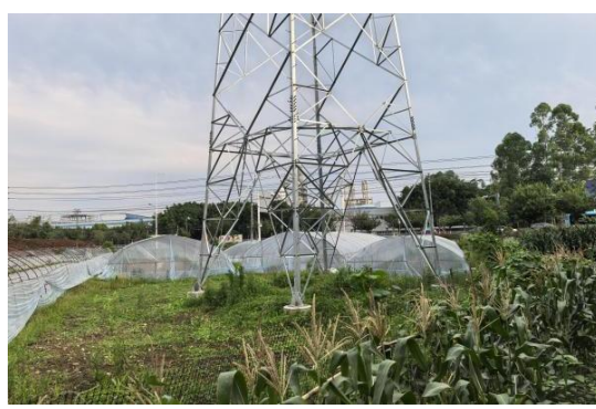
4、邓寿安支线 N45 塔位现状
