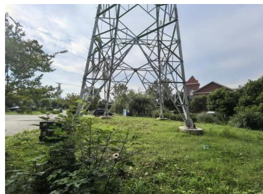
7、邓寿安支线 N46 塔位现状
