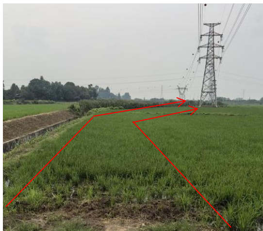
20、苏场—邛崃 N19 塔位施工道路现状
