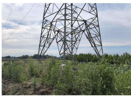
2、高埂—赵塔 N15 塔位现状
