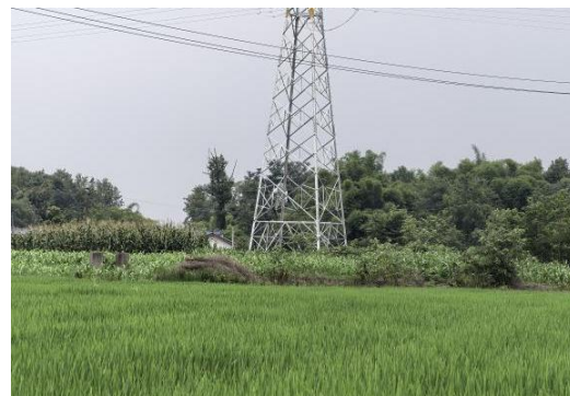
11、庄园—解林 N12 塔位现状
