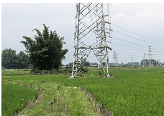
14、苏场—福田 N3 塔位现状
