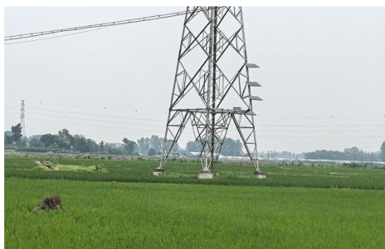
9、苏场—邛崃 N7 塔位现状
