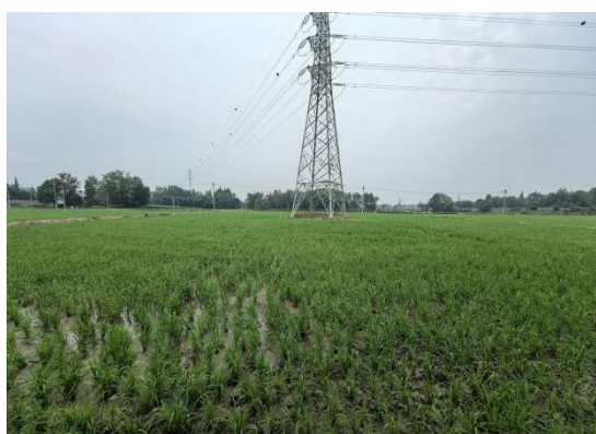
苏场—福田 N26 塔位牵张场现状（已复耕）
