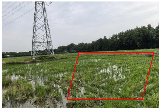
18、庄园—解林 N37 塔位牵张场现状
