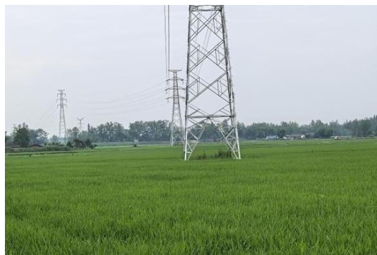
10、庄园—解林 N3 塔位现状
