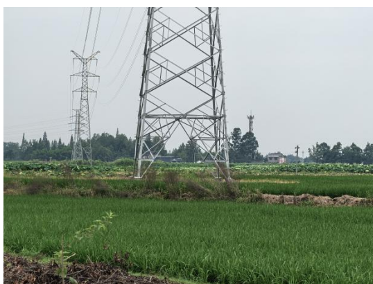
5、庄园—解林 N8 塔位现状
