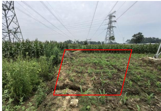
17、苏场—福田 N43 塔位牵张场现状
