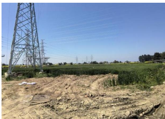
邓寿安支线 N2 塔位牵张场裸露
