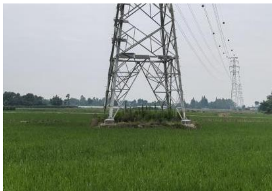
7、苏场—福田 N6 塔位现状
