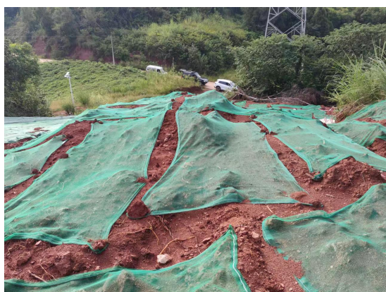
图5-3 N62雨水冲刷严重，平整不到位 图5-4 N65塔基及施工道路存在侵蚀沟
