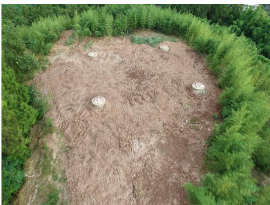
图8-6 塔基区完成土地整治
