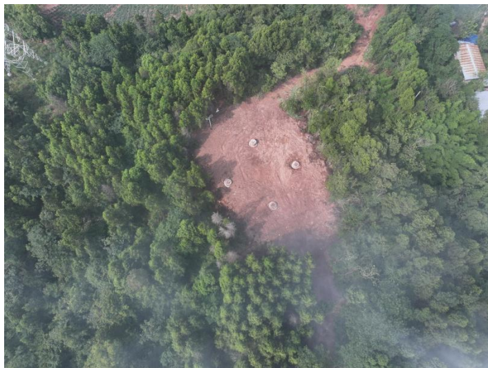
图3-4 塔基区无人机航拍
