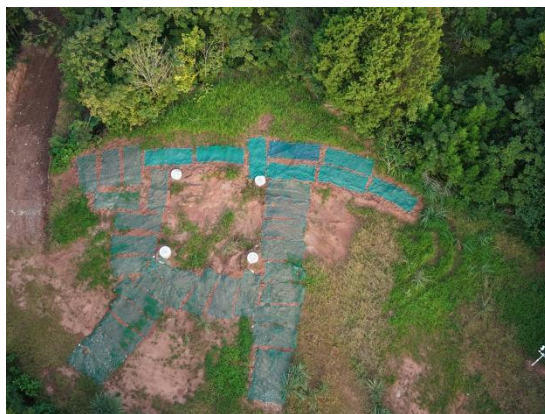
图8-2 塔基区施工完成后进行场地整治
