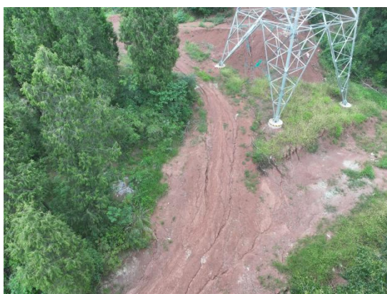
图5-3 N62雨水冲刷严重，平整不到位 图5-4 N65塔基及施工道路存在侵蚀沟
