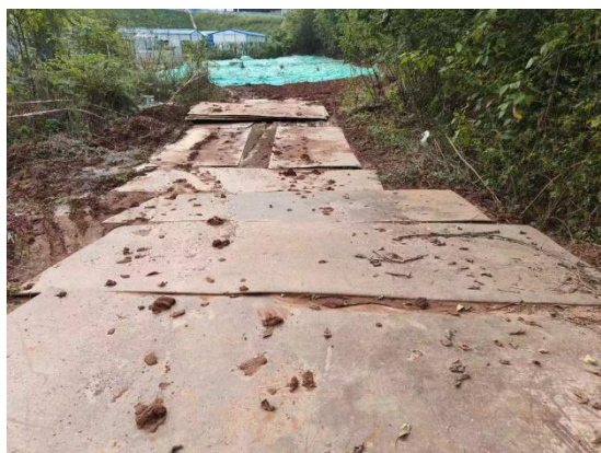
图8-3 塔基区采用钢板铺设
