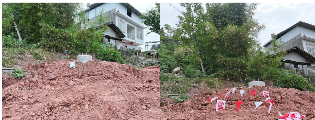
图 3-1、图 3-2 对塔基区布设测针，定期对测针进行监测
