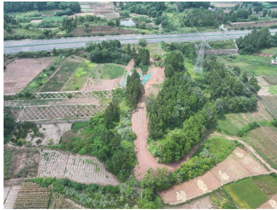
N67 塔基及施工道路存在侵蚀沟
