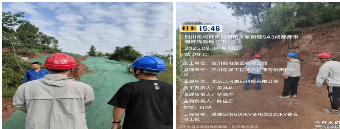
图3-6、图3-7 会同施工人员对现场进行检查
