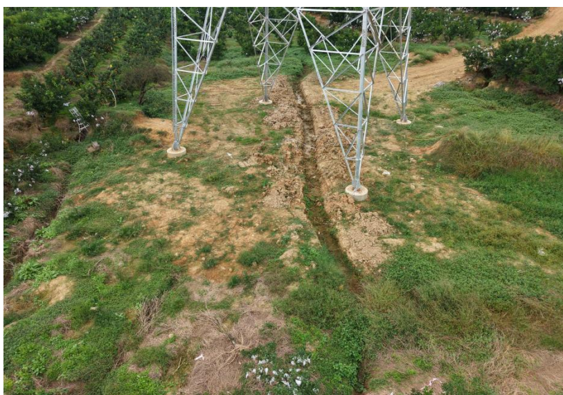
图3-3 塔基区无人机航拍
