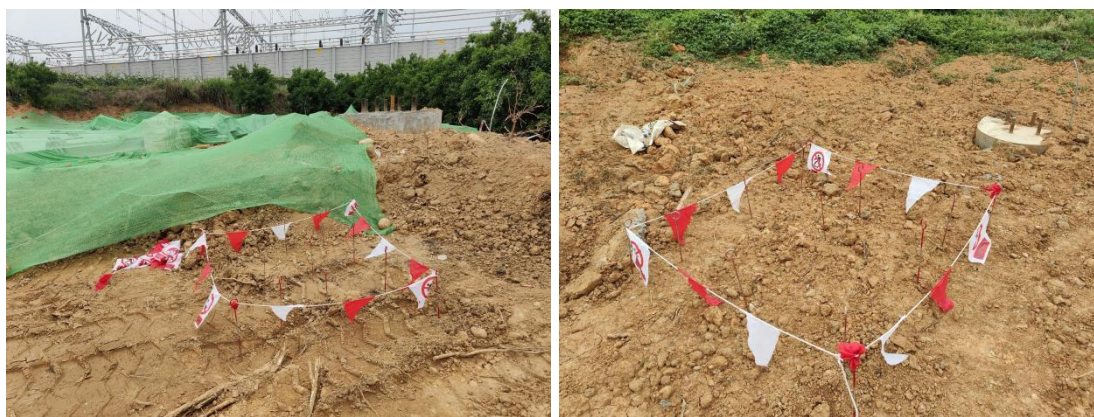
图3-4、图3-5 对塔基区布设监测点位
