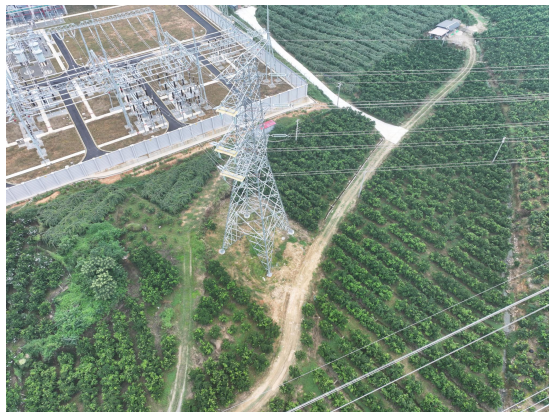
图5-1 NA1破坏原有排水沟未恢复
