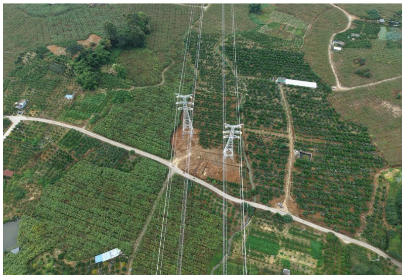
图3-2 塔基区无人机航拍
