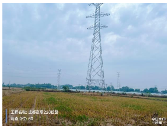
G60 塔位及施工道路
