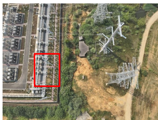
兴梦变电站间隔扩建区域
