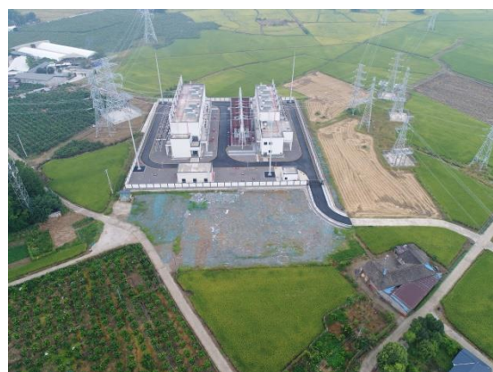
变电站主体工程区全景
