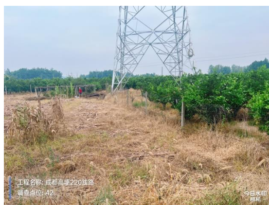
G42 塔位及施工道路
