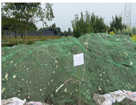
图8-2塔基区表土剥离及保护措施
