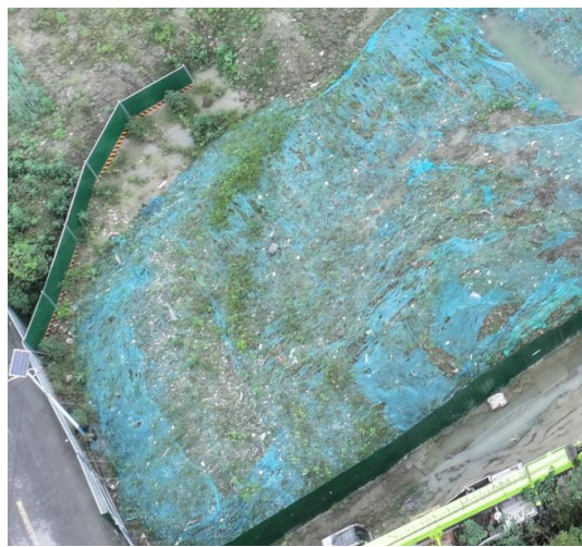
图8-4 变电站区临时堆土密目网苫盖
