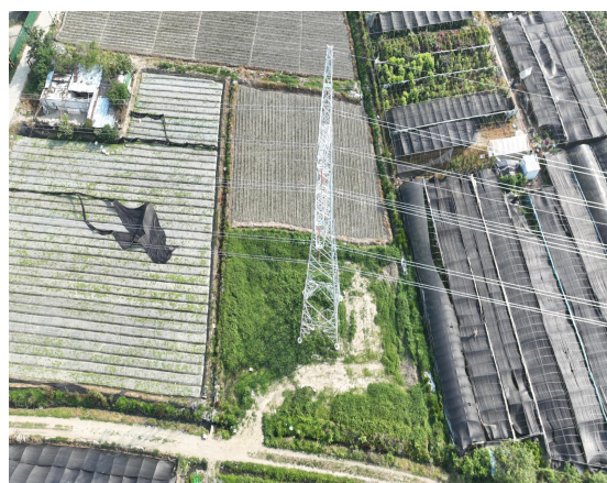
图8-5 架线塔基区已恢复植被
