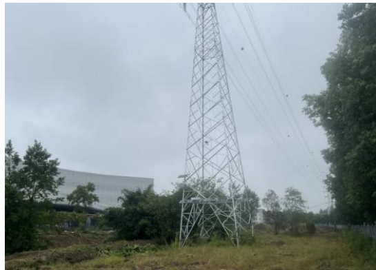
29、苏场—邛崃 N48 塔位现状
