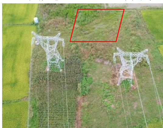
25、苏场—福田 N43 塔位牵张场现状
