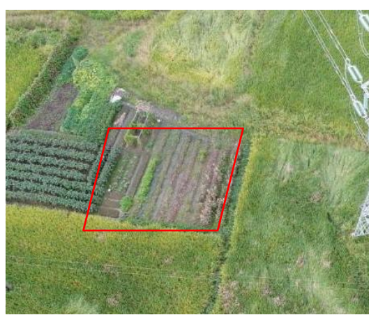
22、苏场—福田 N12 塔位牵张场现状
