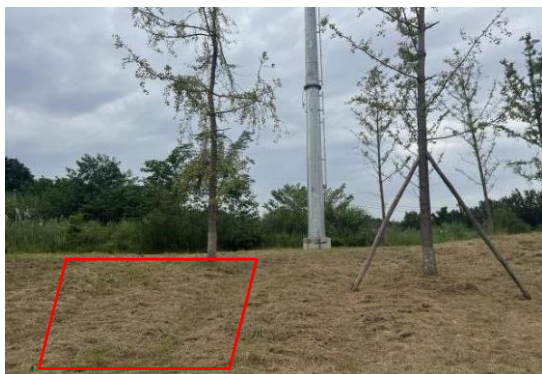
19、高埂—赵塔 N35 塔位牵张场现状
