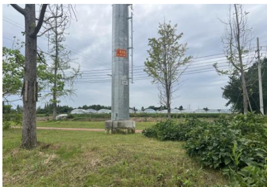
4、高埂—赵塔 N25 塔位现状
