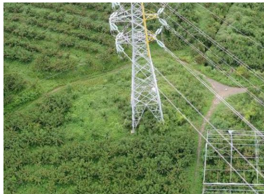
10、苏场—邛崃 N20 塔位现状
