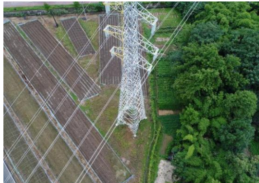
4、邓寿安支线 N45 塔位现状
