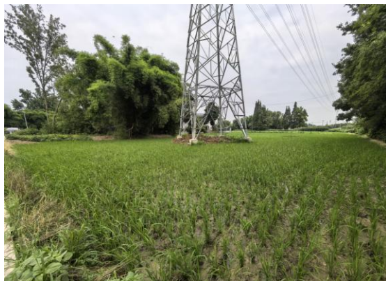
庄园—解林 N29 塔位基面裸露
