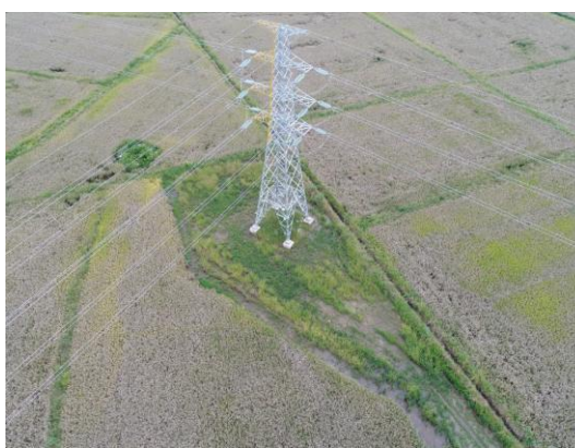
17、庄园—解林 N38 塔位现状
