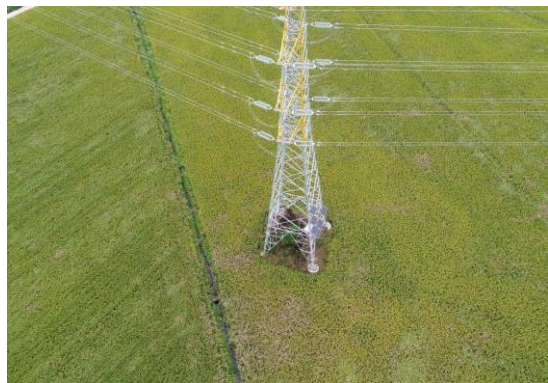
7、苏场—福田 N6 塔位现状
