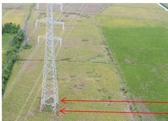
18、庄园—解林 N36 塔位施工道路现状
