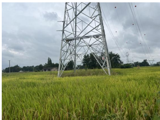
22、苏场—福田 N35 塔位现状
