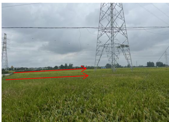
17、苏场—邛崃 N5 塔位施工道路现状
