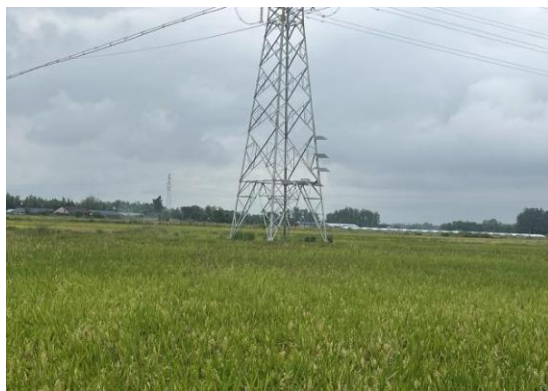
9、苏场—邛崃 N7 塔位现状
