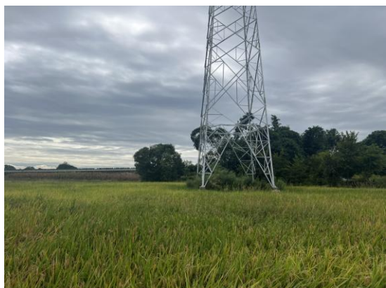
16、庄园—解林 N24 塔位现状
