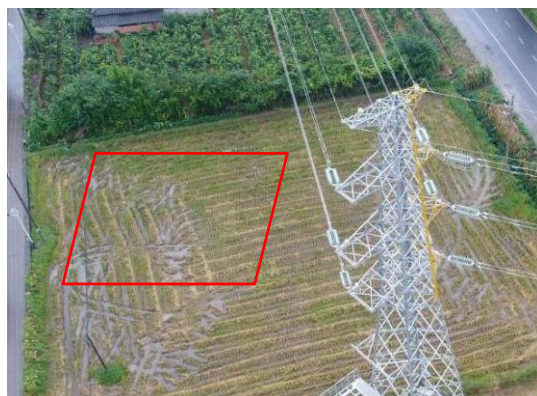
31、苏场—邛崃 N42 塔位牵张场现状
