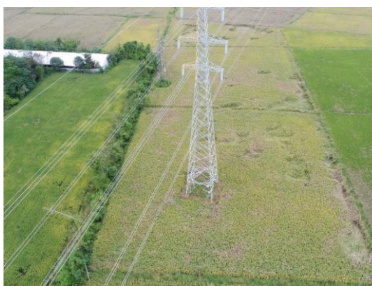
6、庄园—解林 N36 塔位现状
