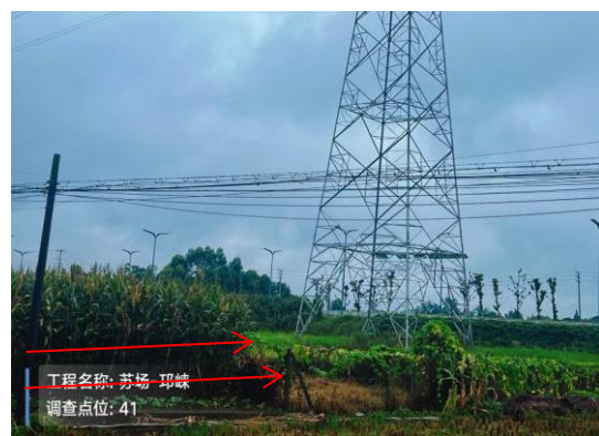
18、苏场—邛崃 N41 塔位施工道路现状
