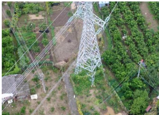
1、高埂—赵塔 N2 塔位现状
