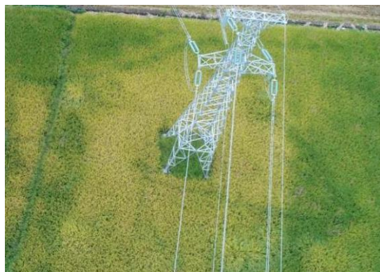
2、高埂—赵塔 N5 塔位现状
