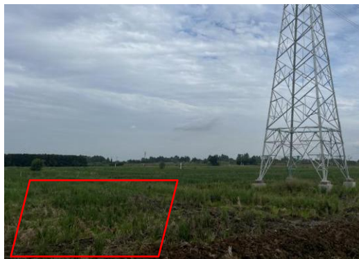
20、邓寿安支线 N32 塔位牵张场现状
