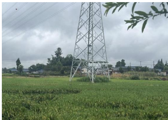
28、苏场—邛崃 N36 塔位现状
