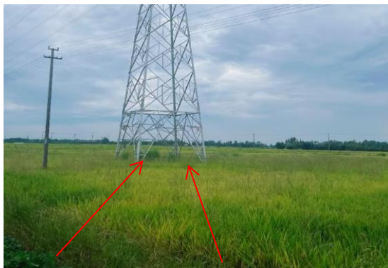
15、庄园—解林 N18 塔位施工道路现状
