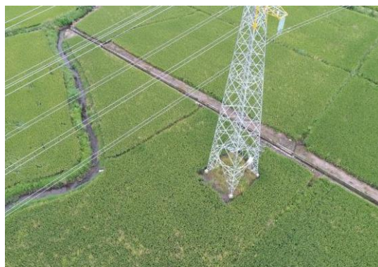
21、苏场—福田 N18 塔位现状
