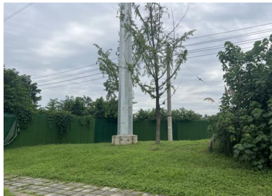
5、高埂—赵塔 N45 塔位现状
