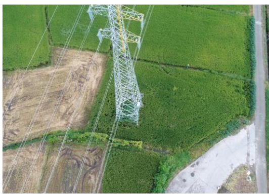
8、苏场—福田 N24 塔位现状
