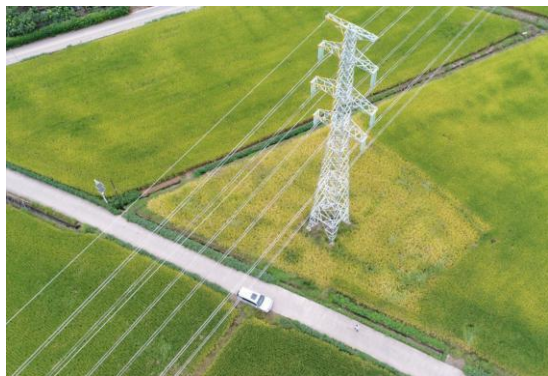
3、邓寿安支线 N5 塔位现状
