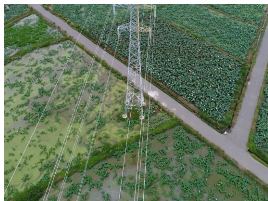
10、邓寿安支线 N37 塔位现状
