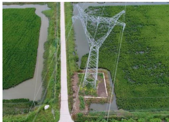
2、高埂—赵塔 N15 塔位现状
