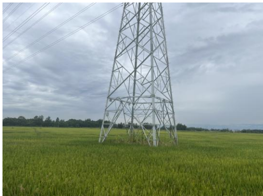
15、庄园—解林 N14 塔位现状
