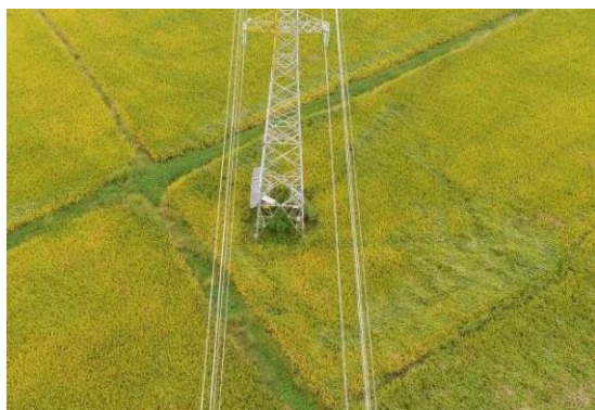
20、苏场—福田 N5 塔位现状
