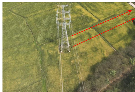
14、邓寿安支线 N15 塔位施工道路现状
