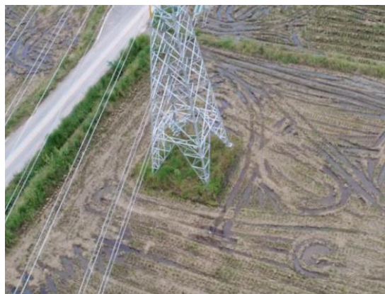
8、邓寿安支线 N8 塔位现状
