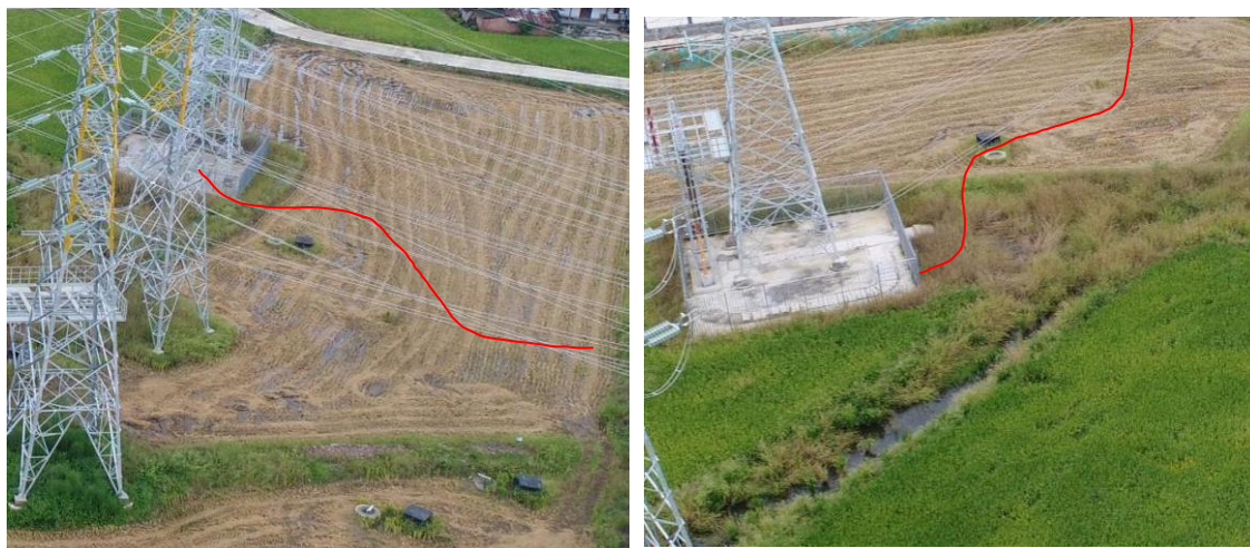
24、电缆施工区现状 (高埂—赵塔 110kV 线路工程电缆段)
