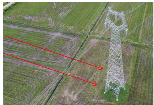
12、高埂—赵塔 N11 塔位施工道路现状
