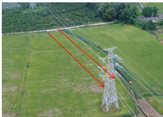
30、苏场—邛崃 N19 塔位施工道路现状
