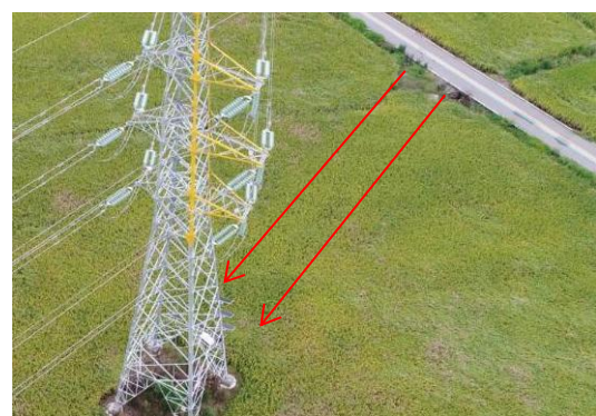
16、苏场—福田 N6 塔位施工道路现状
