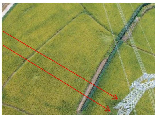
6、高埂—赵塔 N3 塔位施工道路现状
