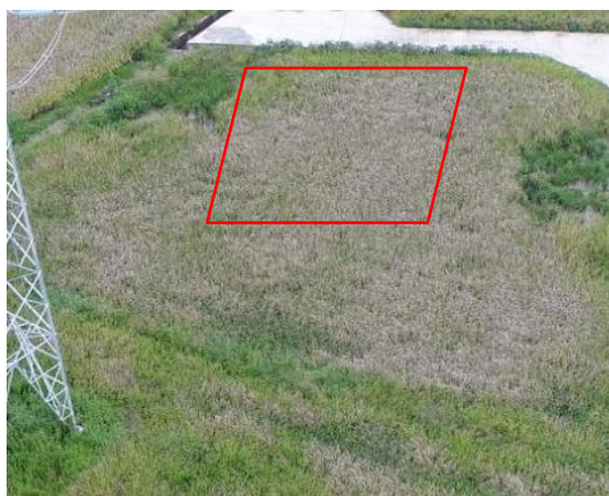
21、庄园—解林 N37 塔位牵张场现状
