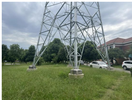
11、邓寿安支线 N47 塔位现状
