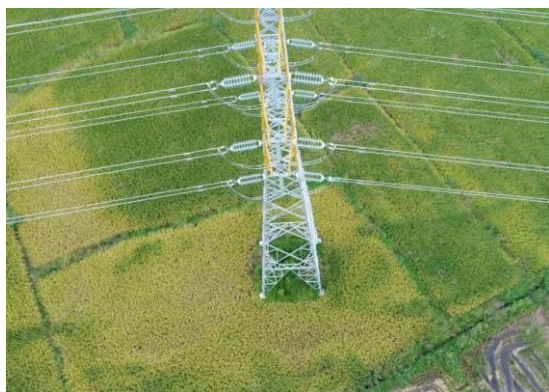
14、庄园—解林 N4 塔位现状
