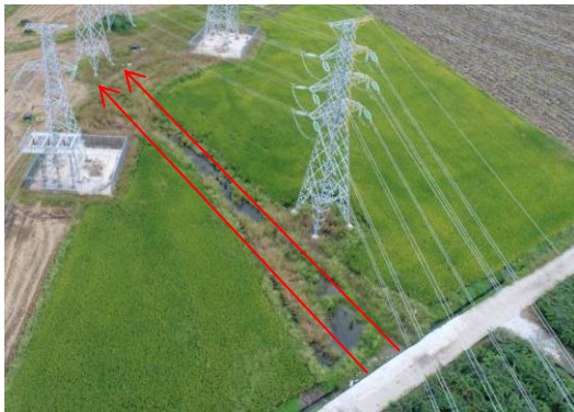
13、邓寿安支线 N1 塔位施工道路现状
