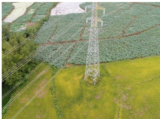
5、庄园—解林 N8 塔位现状
