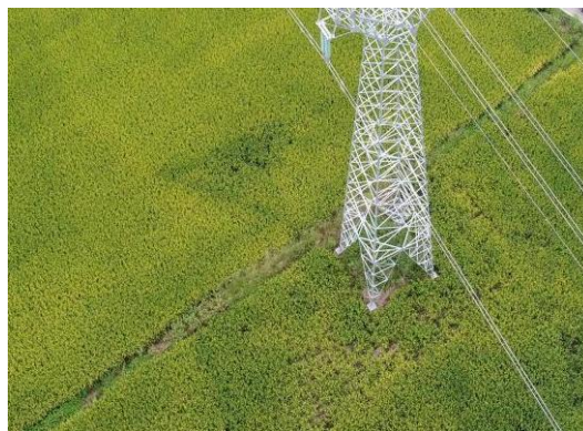
3、高埂—赵塔 N10 塔位现状
