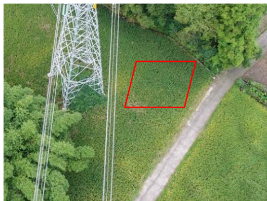
19、庄园—解林 N29 塔位牵张场现状
