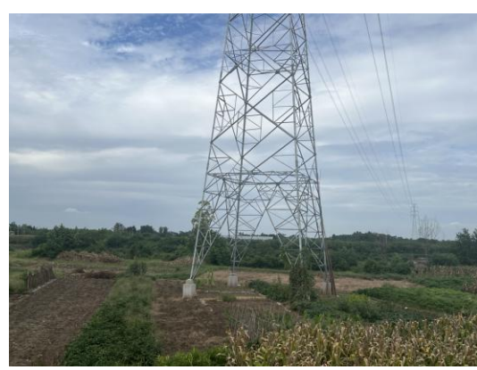
9、邓寿安支线 N20 塔位现状
