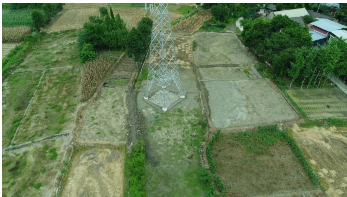
N13 塔基永久占地区域植被恢复差
