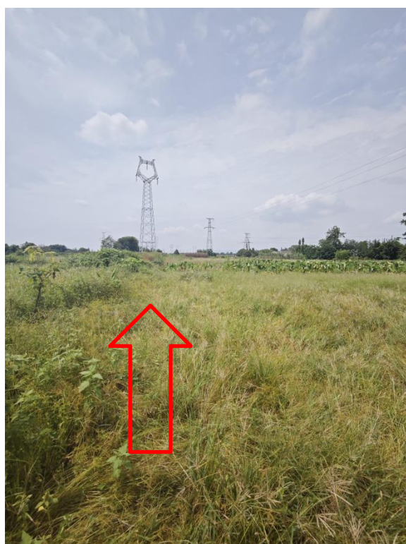
N25 施工道路
