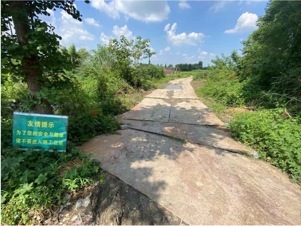
N10 施工道路铺设钢板
