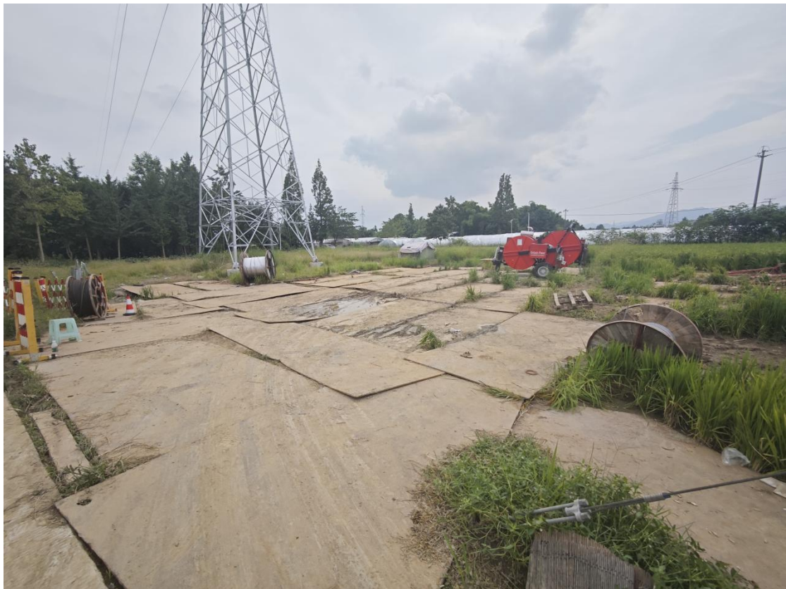
N59 牵张场铺设钢板
