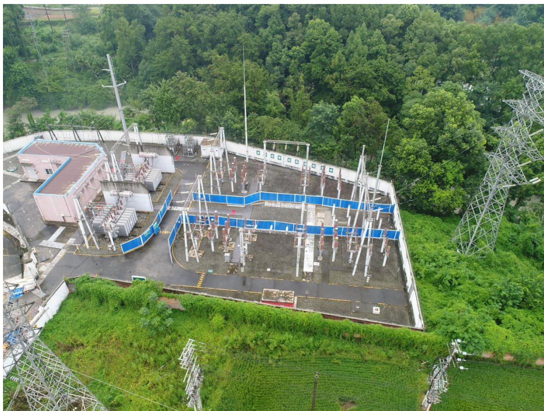
官仓 110kV 变电站回龙 110kV 间隔扩建断路器基础监测点
