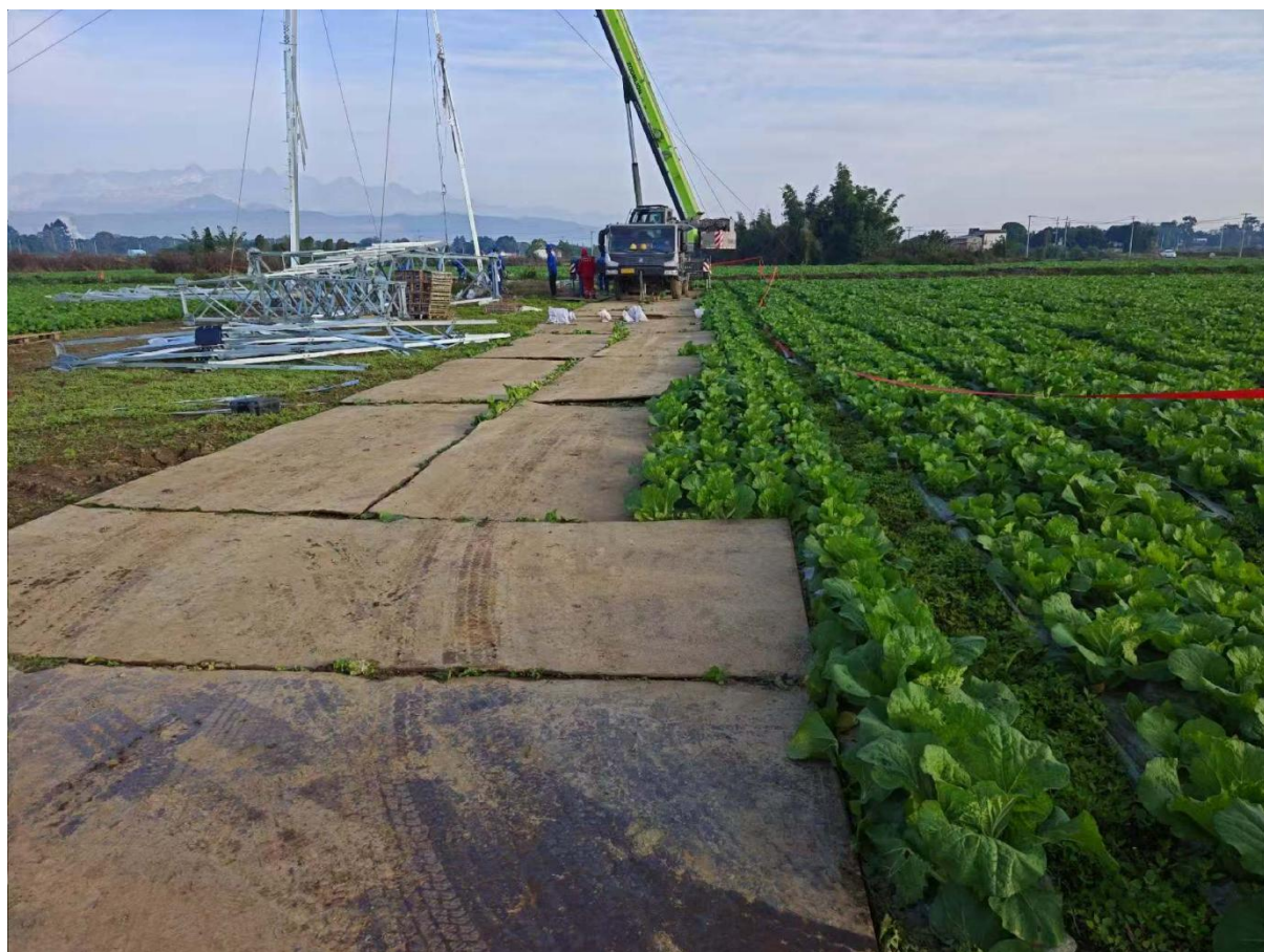
N21 施工道路铺设钢板
