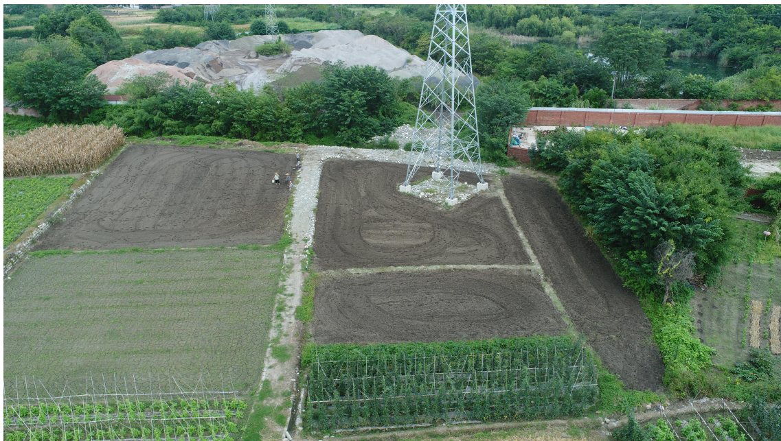
N14 塔基永久占地区域植被恢复差
