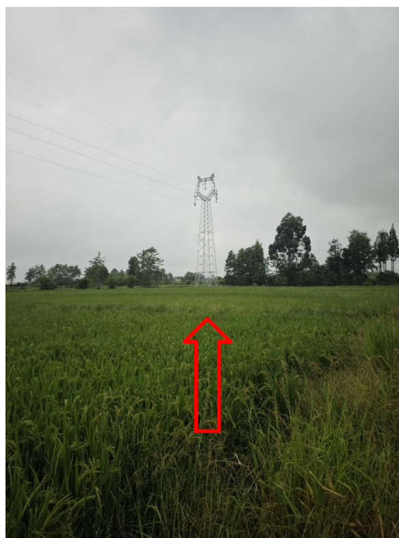
N66 施工道路
