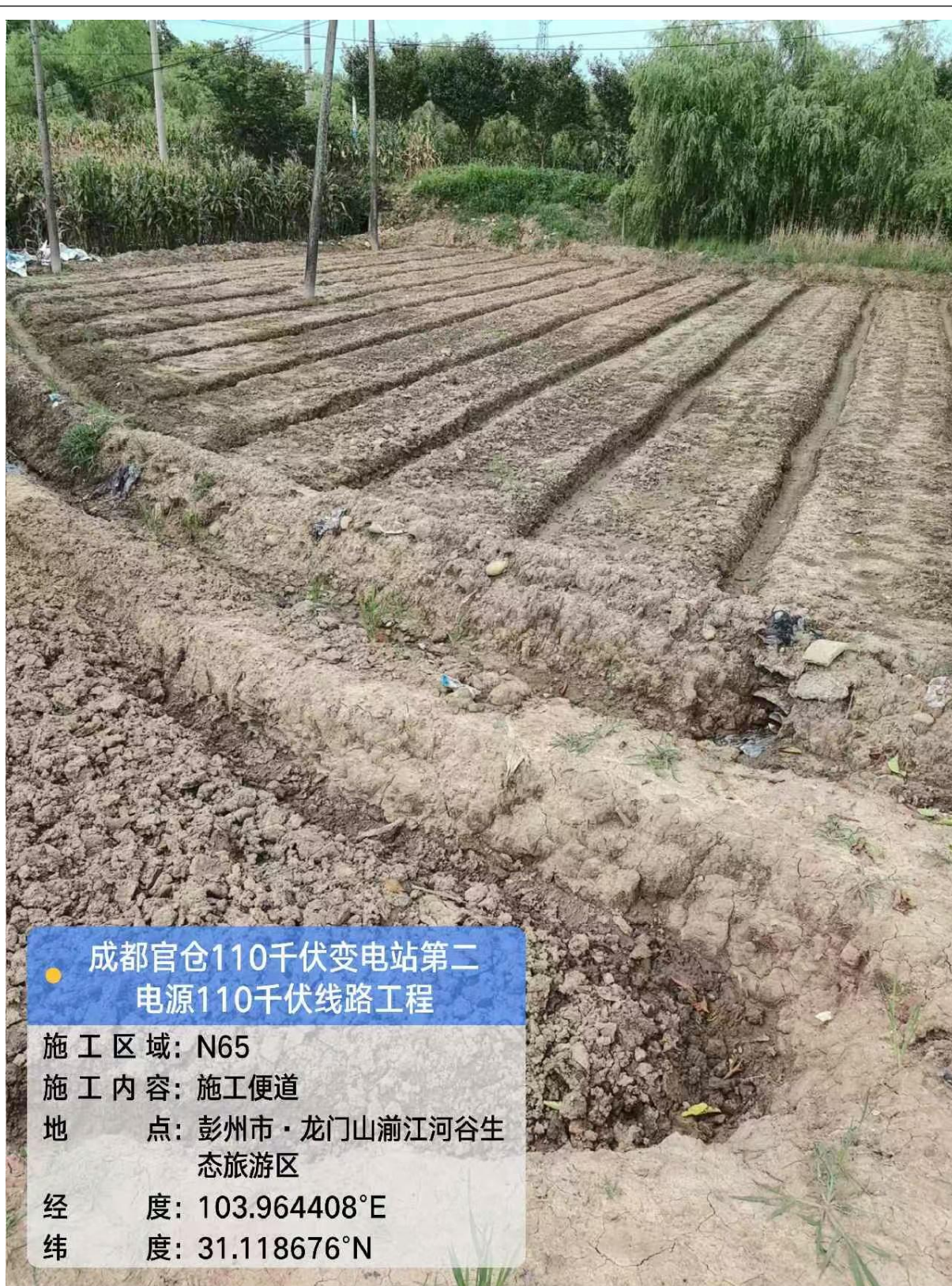
N65 施工道路
