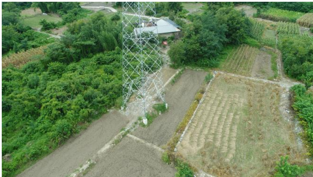
N18 塔基永久占地区域植被恢复差
