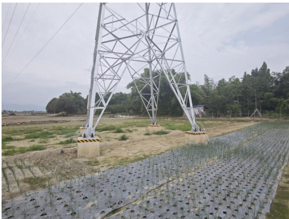
N47 塔基永久占地区域植被恢复差
