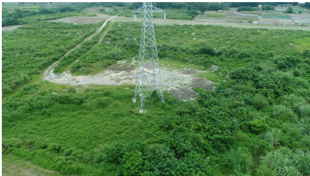
N19 土石方未摊平
