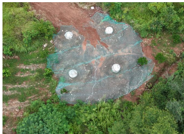
N15 临时遮盖
