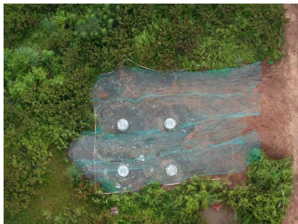
N17 临时遮盖
