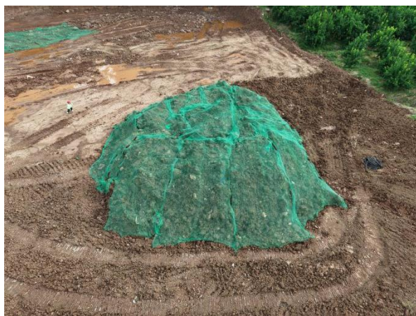
变电站表土剥离
