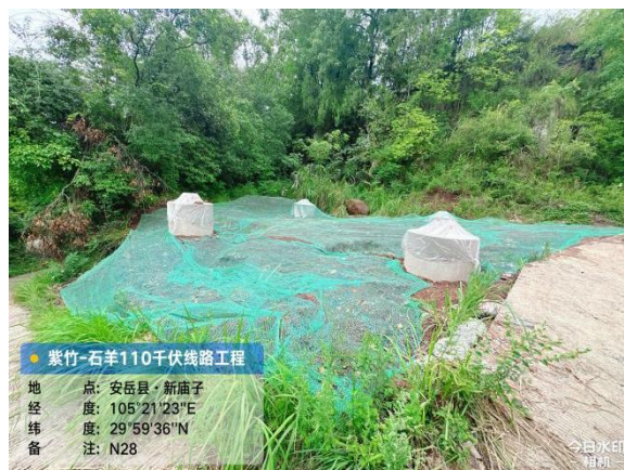
N28 临时遮盖
