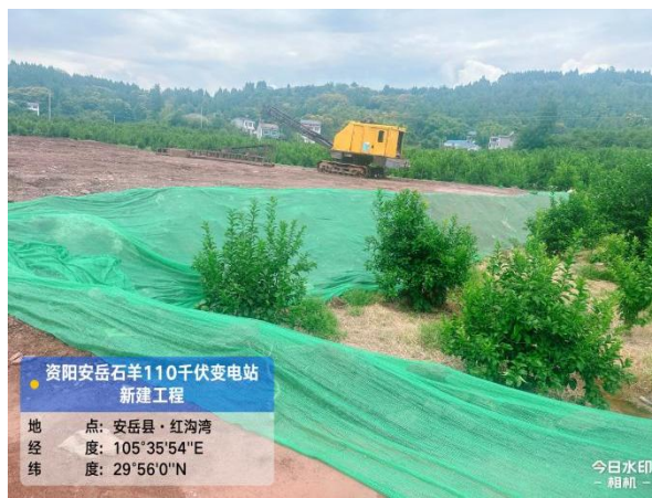
变电站临时遮盖
