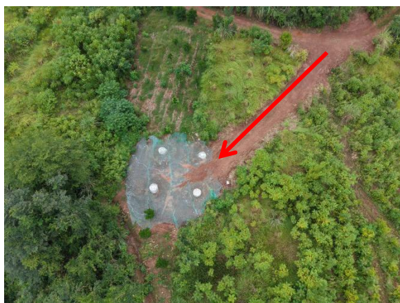
N15 新修汽运道路
