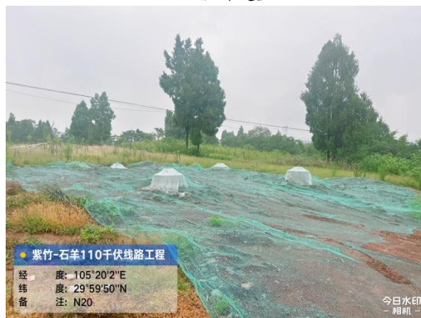
N20 临时遮盖
