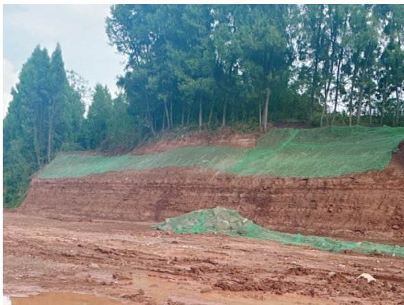
变电站临时遮盖
