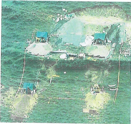
NB37 塔位防雨布铺垫、基础开挖堆土坡脚挡泥 板挡护
