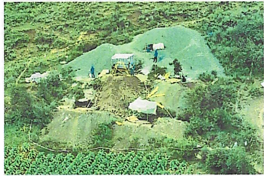
NB75 塔位上方防雨布铺垫、遮盖
