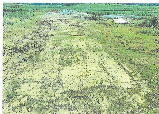
NB2 塔位施工便道-前期铺设钢板, 拆除后绿化
