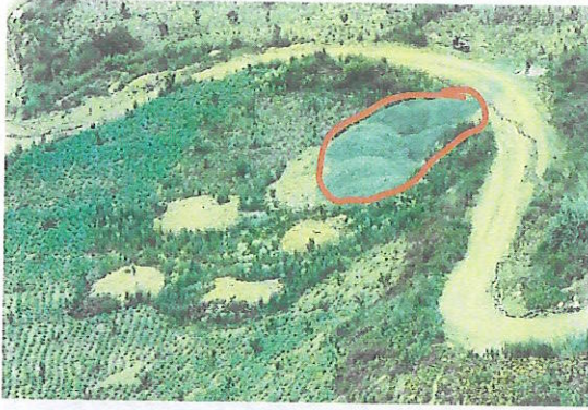
NB77 塔位上方水泥碎石堆放场地采用防雨布 铺垫
