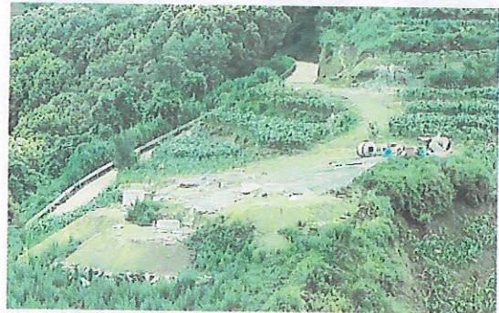
NA116 塔位上方防雨布铺垫、部分堆土坡脚挡 泥板挡护
