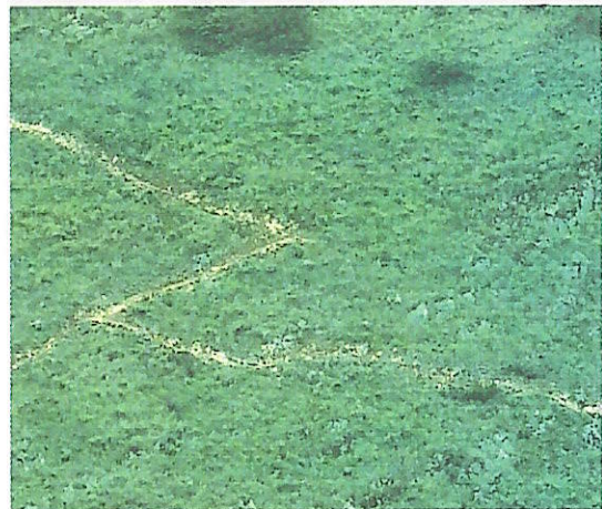
NA69 塔位施工便道-畜力道路-马帮运输-豆粕路段局部挖填平整
