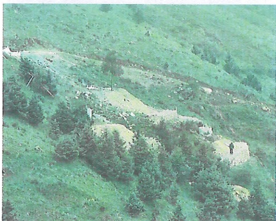
NB38 塔位上方防雨布铺垫、下方浆砌石挡土墙
