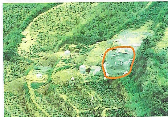
NA123 塔位上方堆料区防雨布铺垫、遮盖
