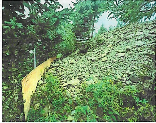
NA35 塔位堆土坡脚挡泥板挡护
