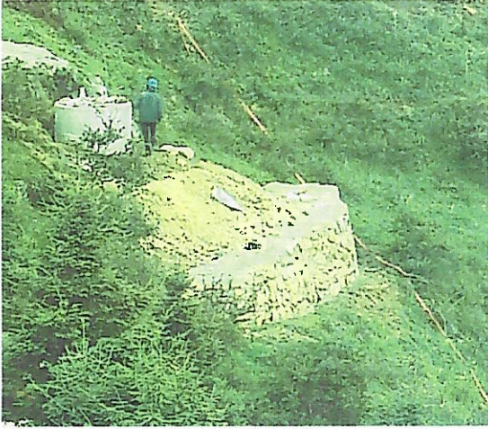
NB38 塔位下方浆砌石挡土墙
