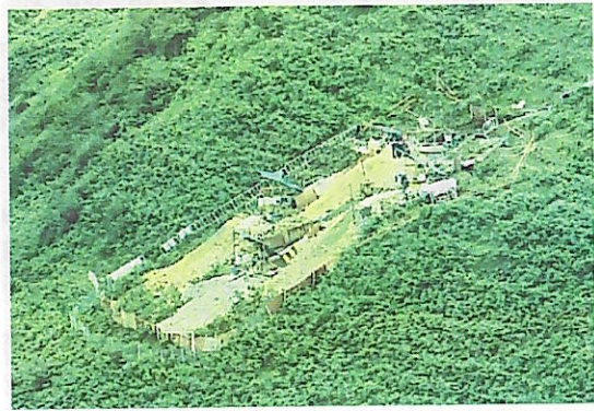
NA17 塔位防雨布铺垫、部分堆土坡脚挡泥板挡护
