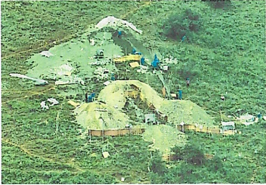
NA69 塔位上方堆料区防雨布铺垫、堆土坡脚挡泥板挡护
