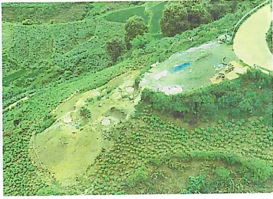
NB121 塔位上方堆料区防雨布铺垫、土袋挡护
