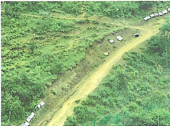
NA69 塔位施工便道-汽运道路
