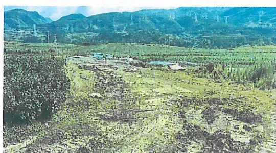
NA2 塔位基面已整平
