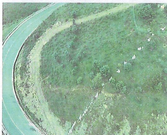
NA35 塔位施工便道-畜力道路-马帮运输-豆粕路段局部挖填平整
