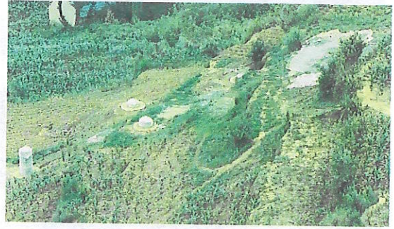
NB127 塔位上方堆料区防雨布铺垫、遮盖
