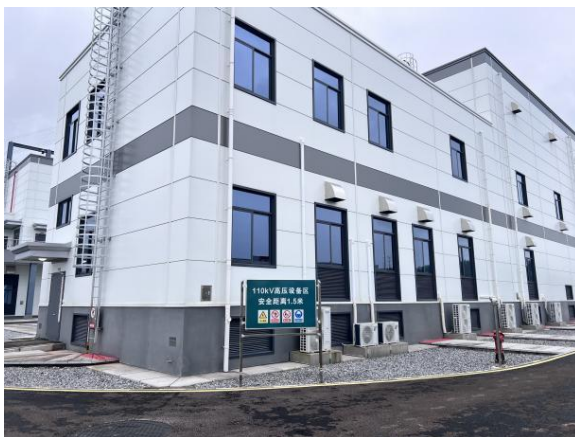
站内 110kV 高压设备现状
