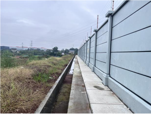
站外临时场地及排水沟现状
