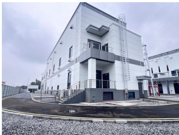
站内 220kV 高压设备现状
