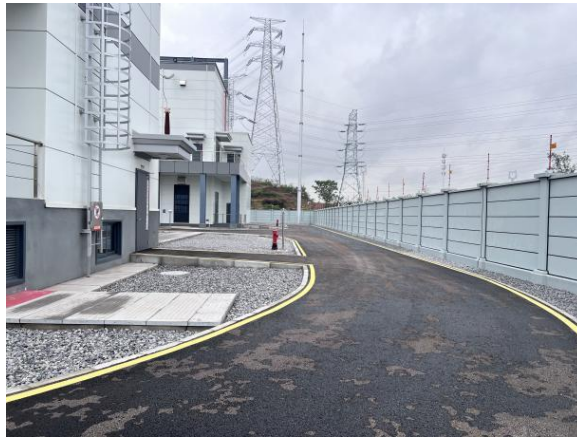
站内硬化道路现状
