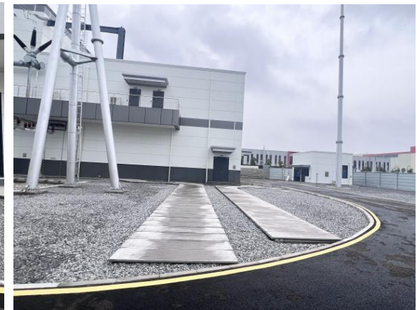
站内碎石现状
