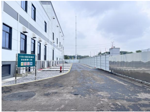
站内道路现状
