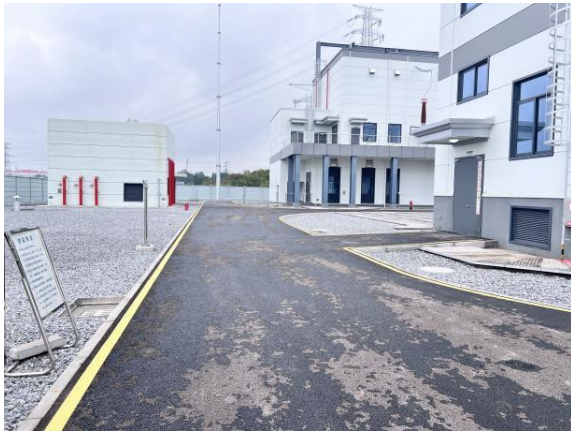
站内道路现状
