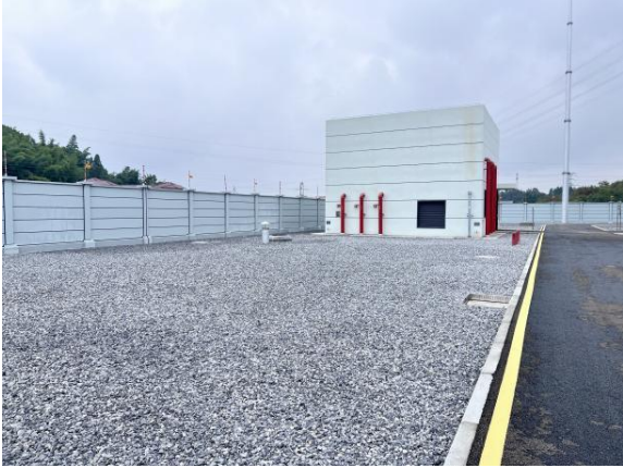
站内碎石现状
