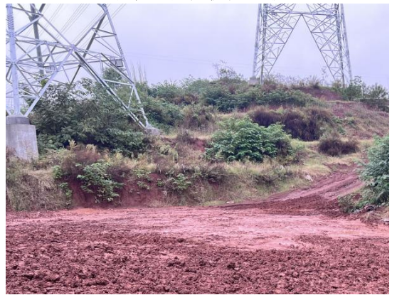
66号塔基牵张场恢复现状
