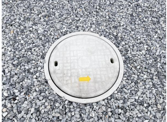
排水系统现状
