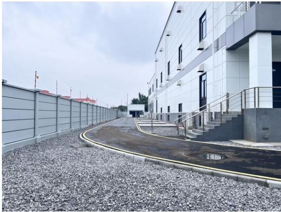
站内硬化道路现状
