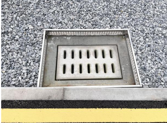
排水系统现状
