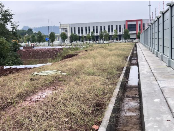
站外临时场地及排水沟现状
