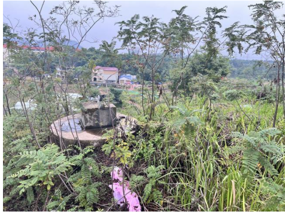
拆除塔基植被恢复现状
