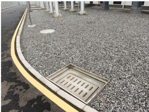
排水系统现状
