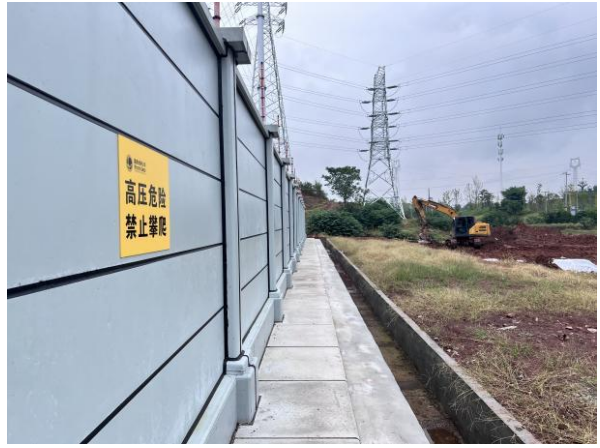
站外临时场地及排水沟现状
