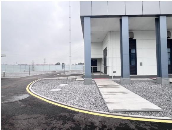
站内碎石现状
