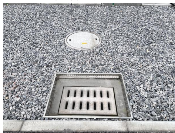
排水系统现状
