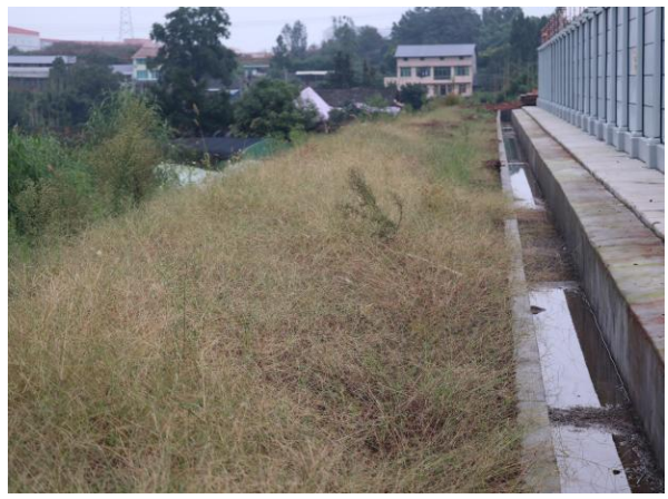
站外临时场地及排水沟现状
