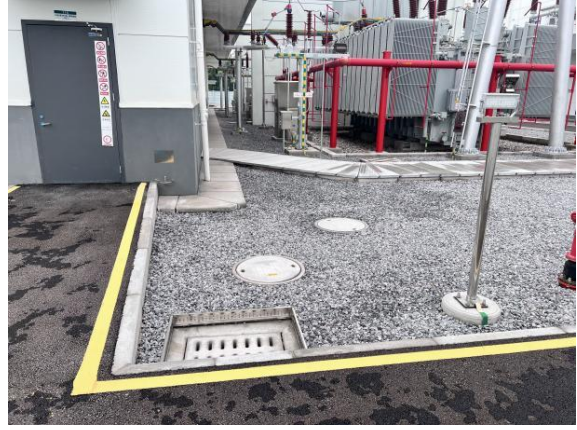
站内碎石现状
