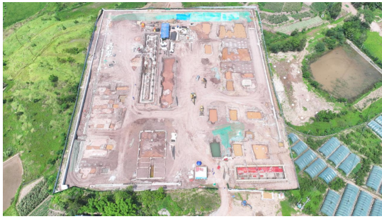
朗池 220kV 变电站
