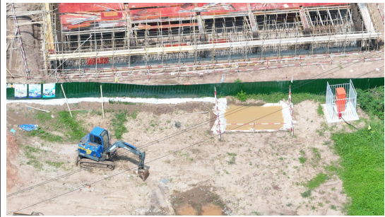
站外临时排水沟及沉沙池
