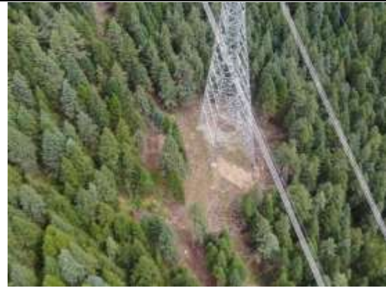
4N239 塔基植被恢复 (2025.8)
