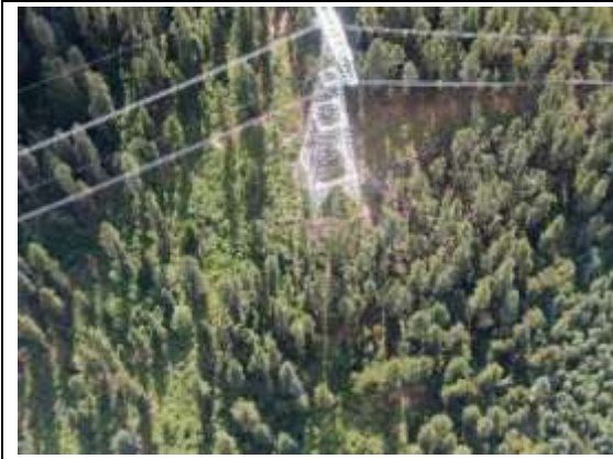
4N232 塔基植被恢复 (2025.8)
