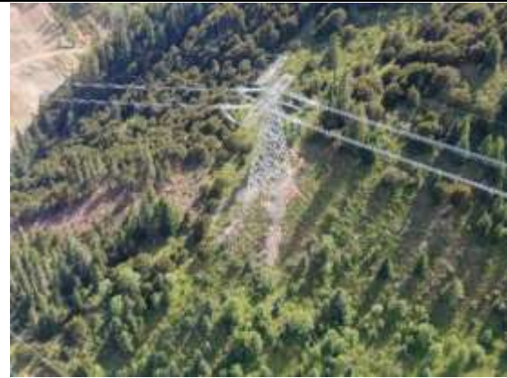
4N246 塔基植被恢复 (2025.8)
