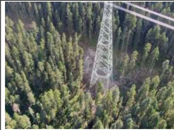
4N245 塔基植被恢复 (2025.8)
