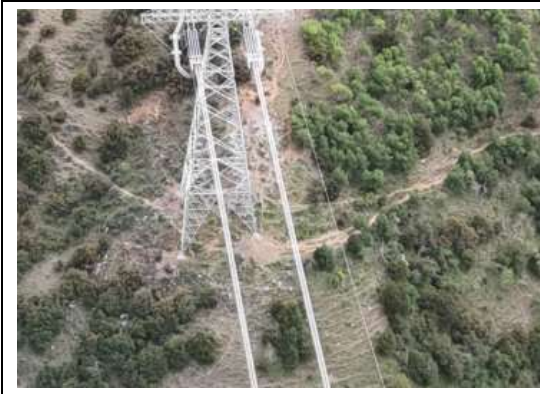
川 3 标 4N045 塔基区迹地恢复 (2025.8)
