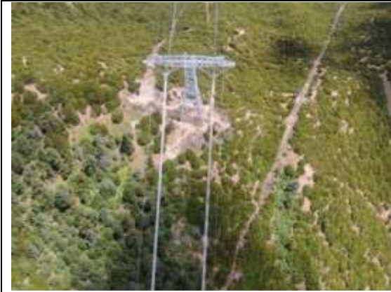
N102 塔基植被恢复 (2025.8)
