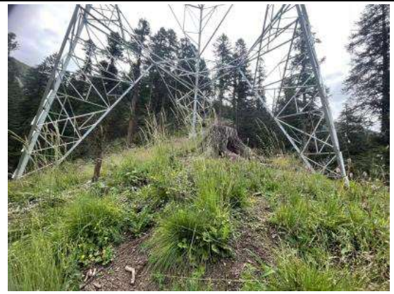
N104 塔基植被恢复 (2025.8)
