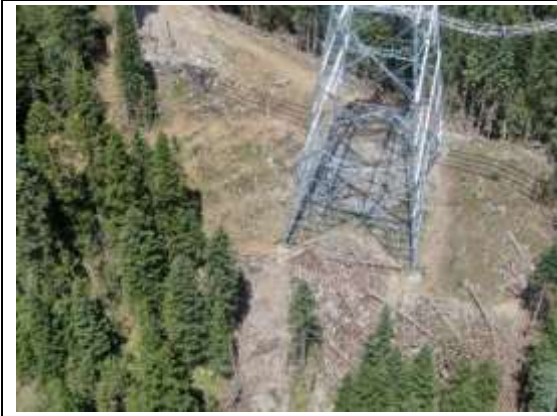
N112 塔基植被恢复 (2025.8)
