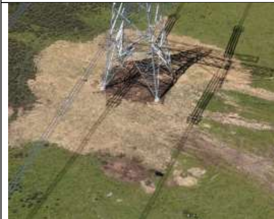
川 6 标 N0326 塔基区迹地恢复 (2025.8)
