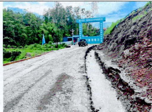
扩建进站道路 (内侧新建排水沟)
