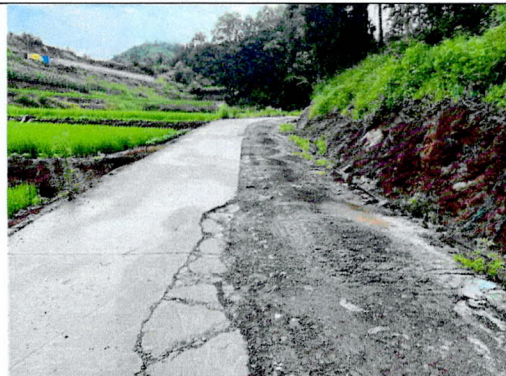
扩建进站道路 (无排水沟)
