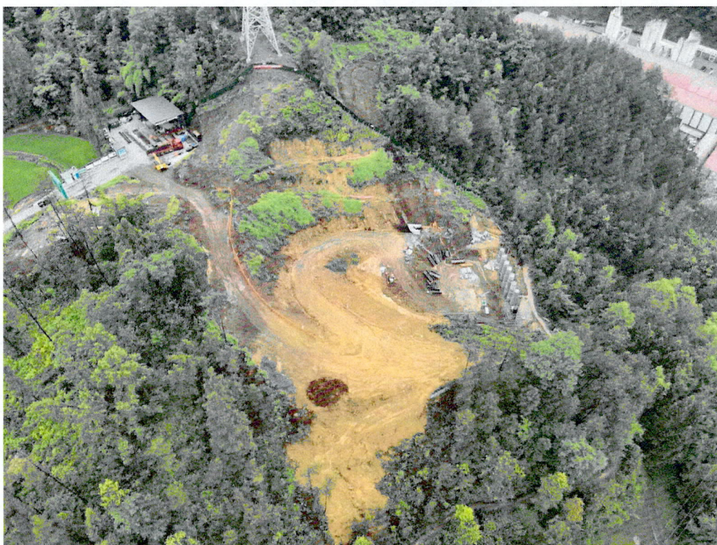
变电站站区裸露地表采取临时遮盖
