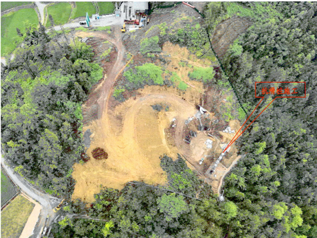
变电工程建设现状（2025年6月底）
