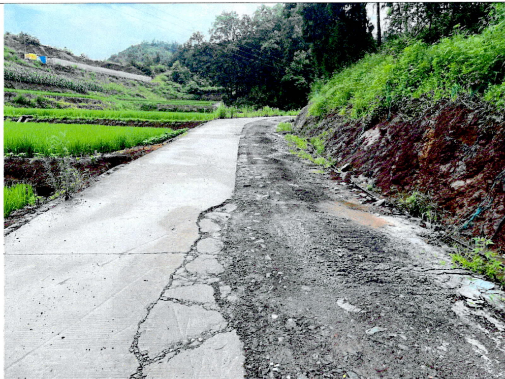
扩建进站道路边坡
