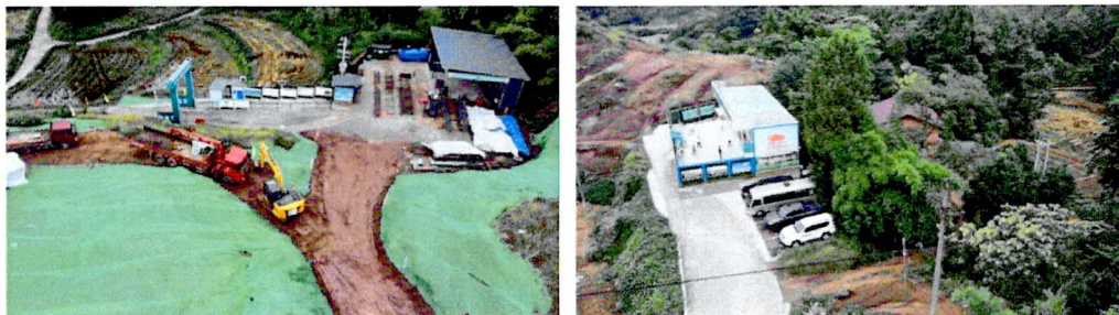
2025 年 3 季度末施工生产生活设施区扰动情况
