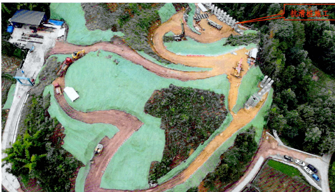
变电工程建设现状（2025年9月底）
