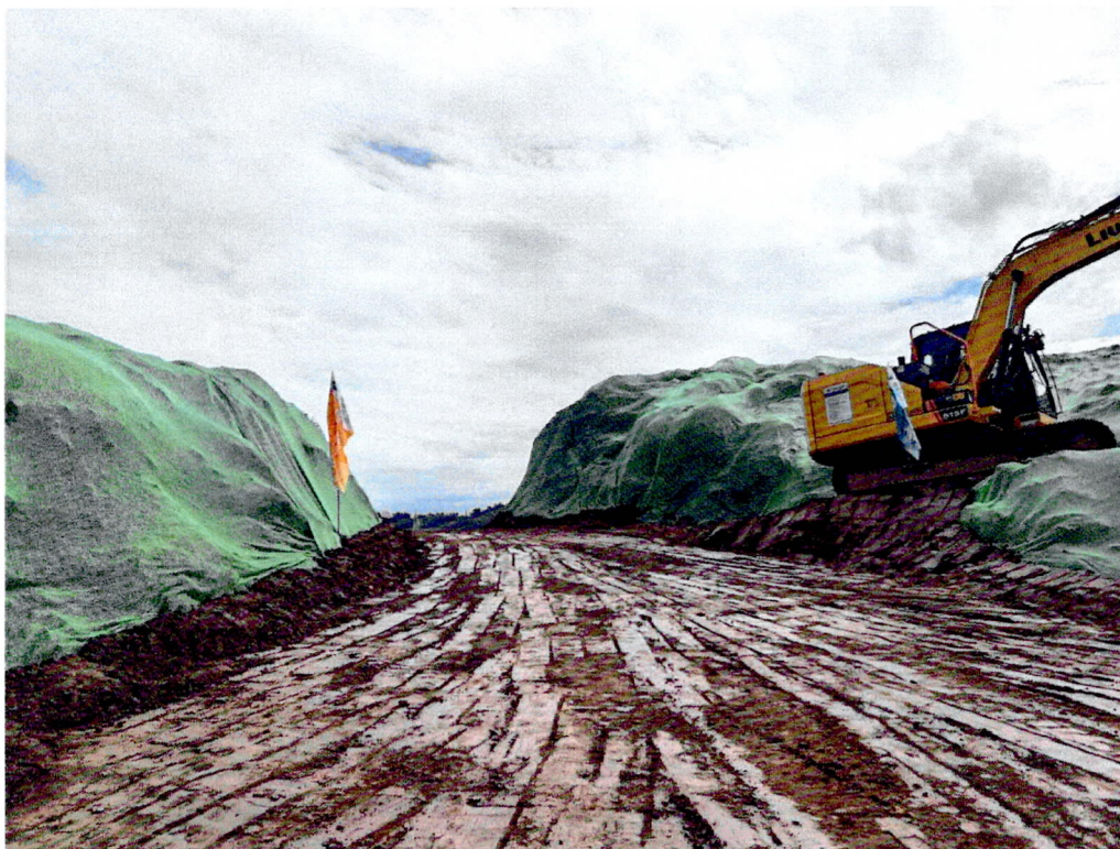
临时堆放表土照片
