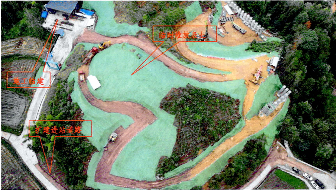
进站道路及施工临建现状（2025 年 9 月底）
