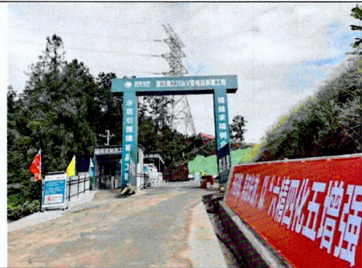
扩建进站道路 (内侧新建排水沟)
