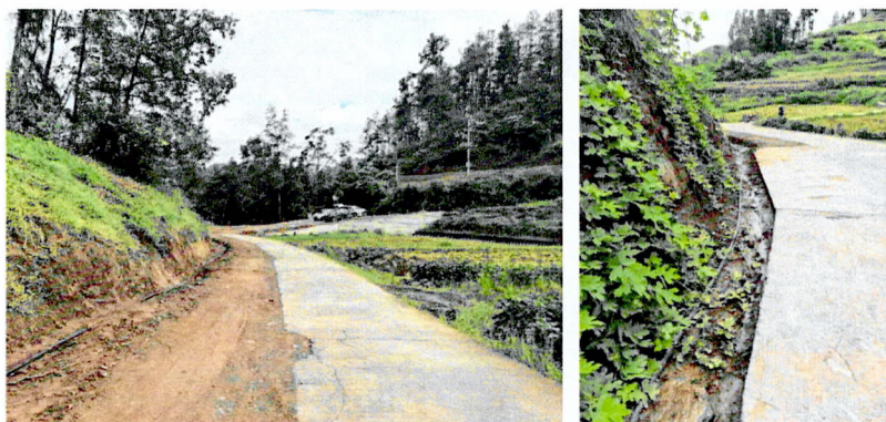
整改后：扩建进站道路修建临时排水沟
