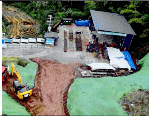
变电站外施工场地
