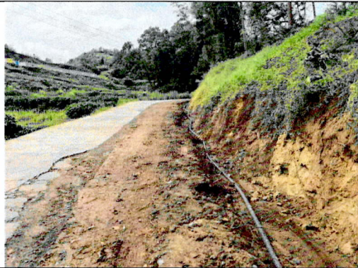
扩建进站道路 (临时排水沟)
