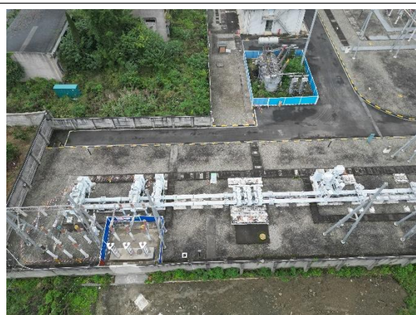
间隔完善工程区工程区碎石铺设
