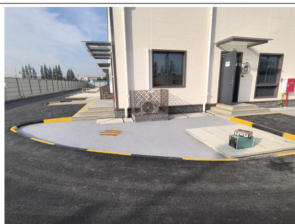
变电站主体工程区透水混凝土地坪
