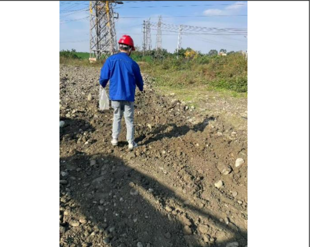
电缆施工区临时占地撒播草籽
