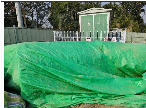
施工电源占地区防雨布遮盖
