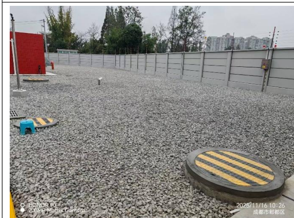
变电站主体工程区碎石铺设
