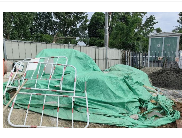
施工电源占地区防雨布隔离
