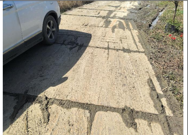
施工道路占地区铺设钢板
