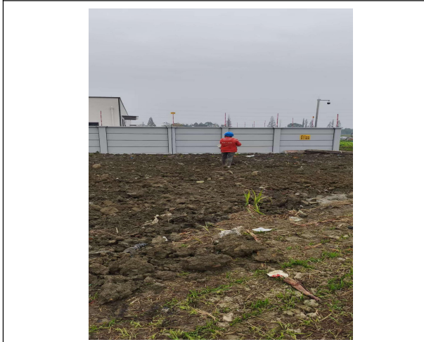
变电站主体工程区临时占地撒播草籽
