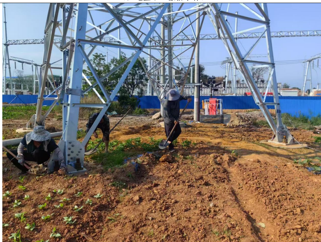
塔基及其施工场地区 (土地整治)
