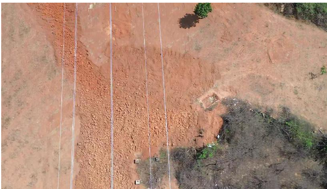
牵张场土地整治恢复现状 1
