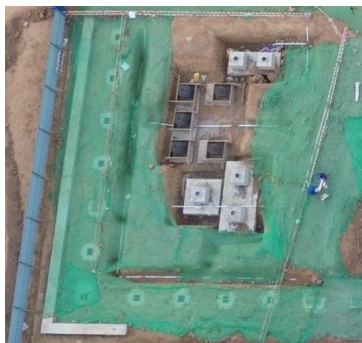
变电站间隔扩建工程区密目网遮盖(经 久 110kV 变电站)
