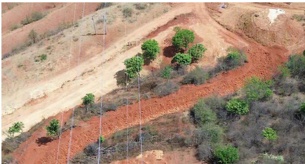
施工道路区土地整治 1
