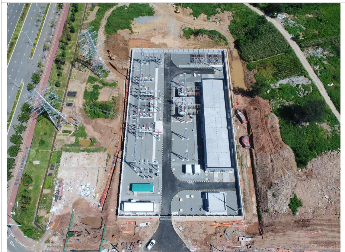
经久二 110 千伏新建变电站
