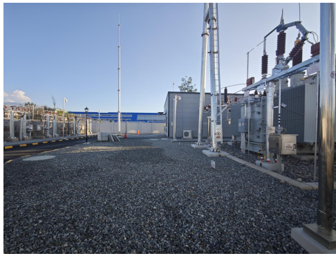
变电站主体工程区铺设碎石 (经久二 110kV 变电站)
