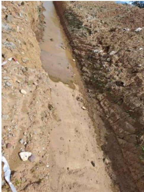
变电站主体工程区施工期临时排水沟 (经久二 110kV 变电站)
