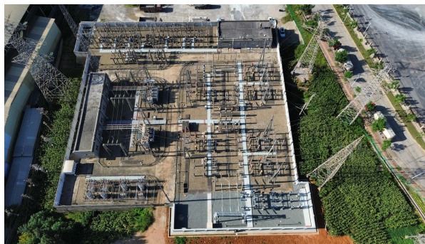
变电站间隔扩建工程区站内碎石铺设(经久 110kV 变电站)
