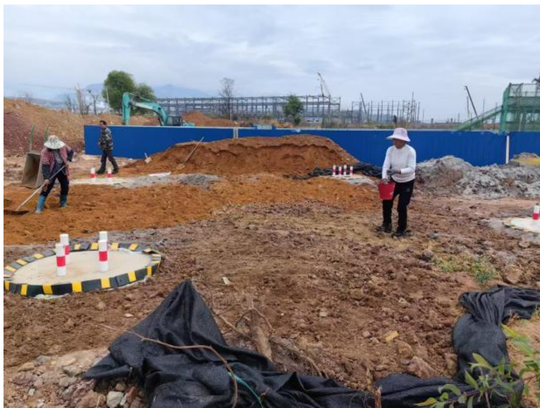
塔基及其施工场地区 (土地整治、撒播草籽)
