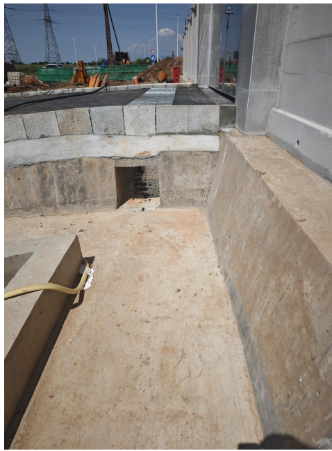
变电站主体工程区站外排水沟 (经久二 110kV 变电站)
