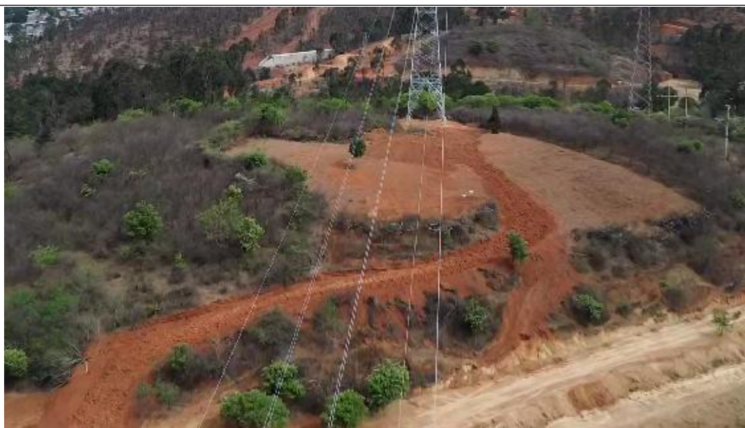
施工道路区土地整治 2
