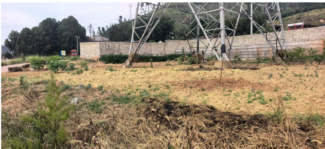
牵张场土地整治恢复现状 2
