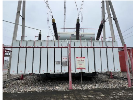
图 2 乐德 220kV 变电站主变压器 (2#)
