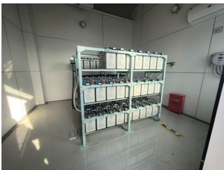
犀浦二 110kV 变电站蓄电池室 犀浦二 110kV 变电站蓄电池室内的蓄电池
