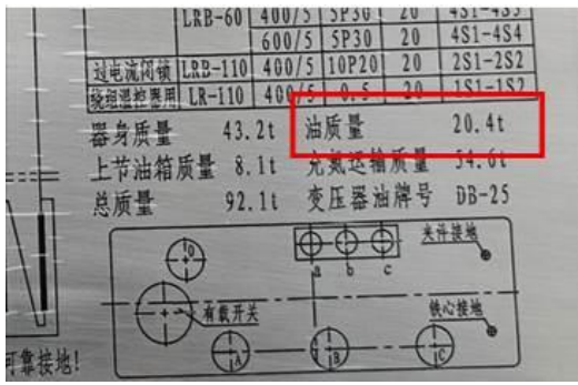
犀浦二 110kV 变电站 1、2#主变绝缘油质量 犀浦二 110kV 变电站新建的事故油池
