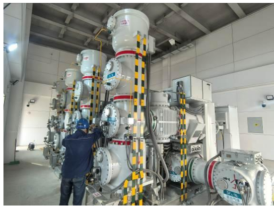
110kV 配电装置
