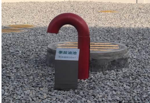
犀浦二 110kV 变电站 1、2#主变绝缘油质量 犀浦二 110kV 变电站新建的事故油池
