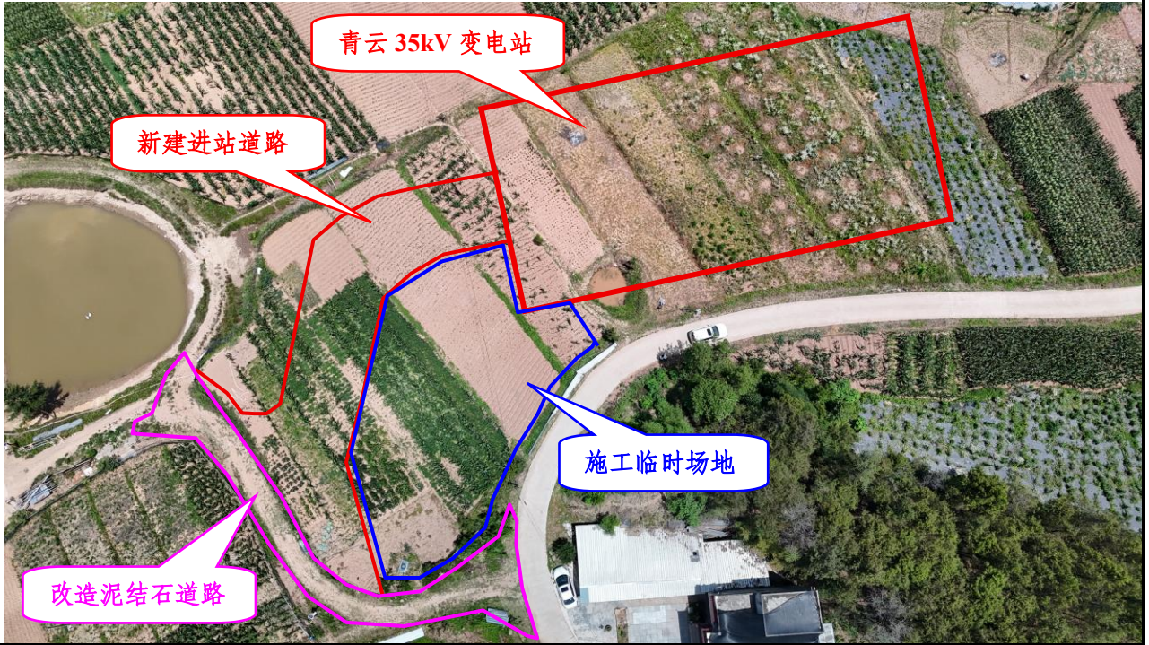
青云 35kV 变电站及施工场地现状
