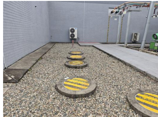
图 16 既有事故油池
