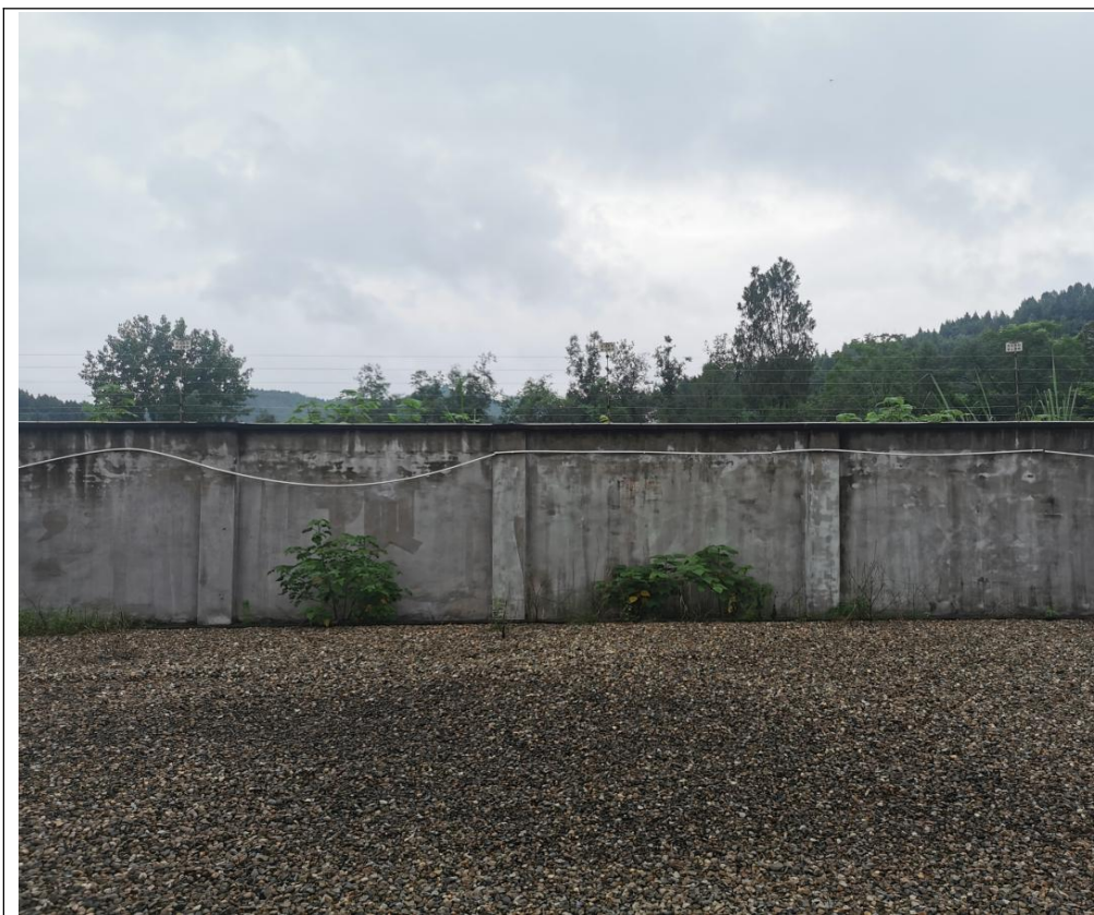
金凤 35 千伏变电站 35 千伏间隔扩建工程扩建场地现状
