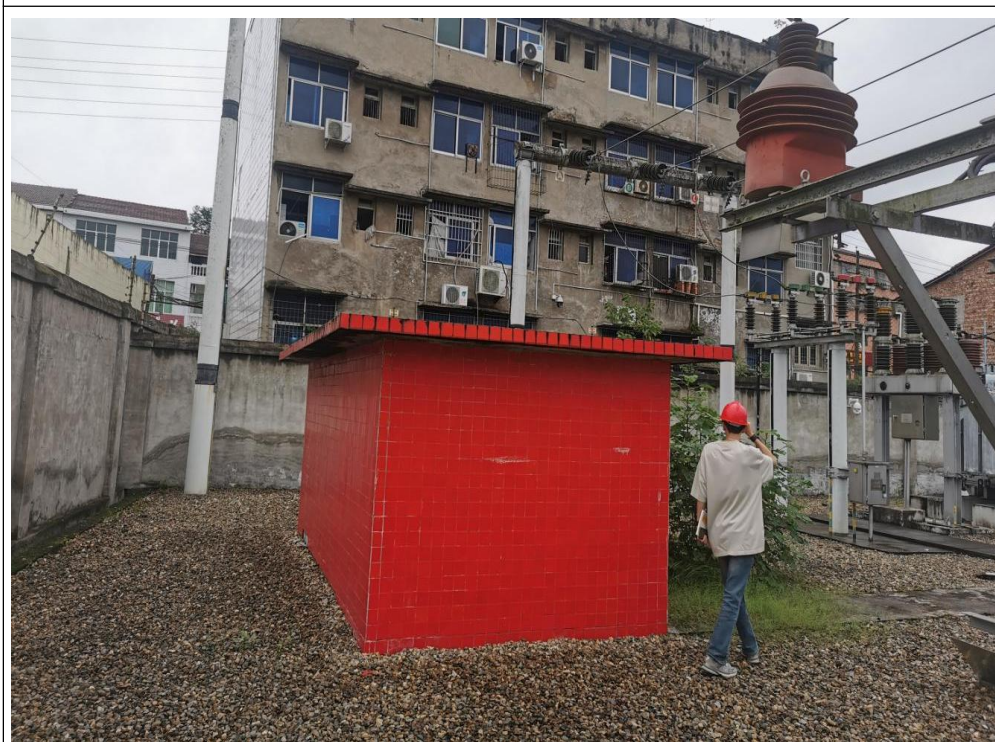
吉安 35 千伏变电站 35 千伏间隔扩建工程扩建场地现状
