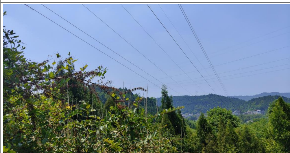
龙岭-金凤 35 千伏线路工程沿线照片
