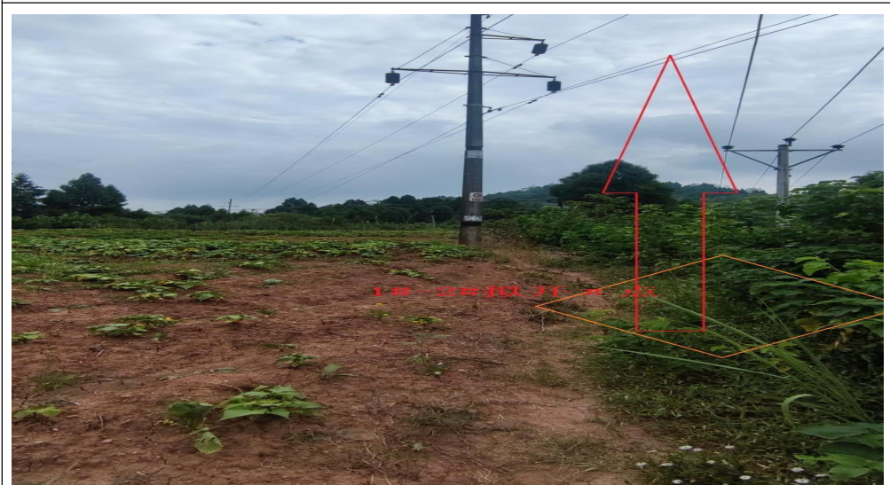
安平-大通 \pi 接入 110 千伏龙岭站 35 千伏线路工程沿线照片
