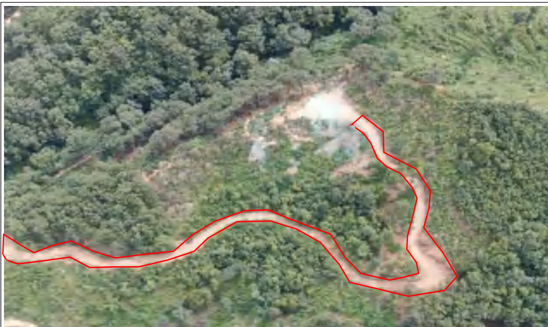
杆塔号: N5172 施工道路无人机正射影像解译 (2024.6), 道路长度 200.3m, 宽度 3.2m。
