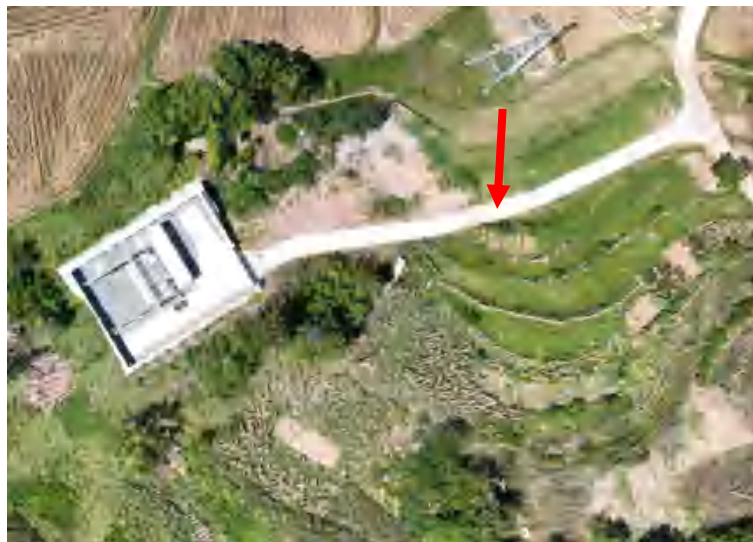
图 3.3-5 受端接地极施工道路影像
