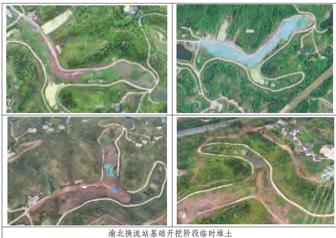
图 3.3-7 渝北换流站工程临时堆土影像
