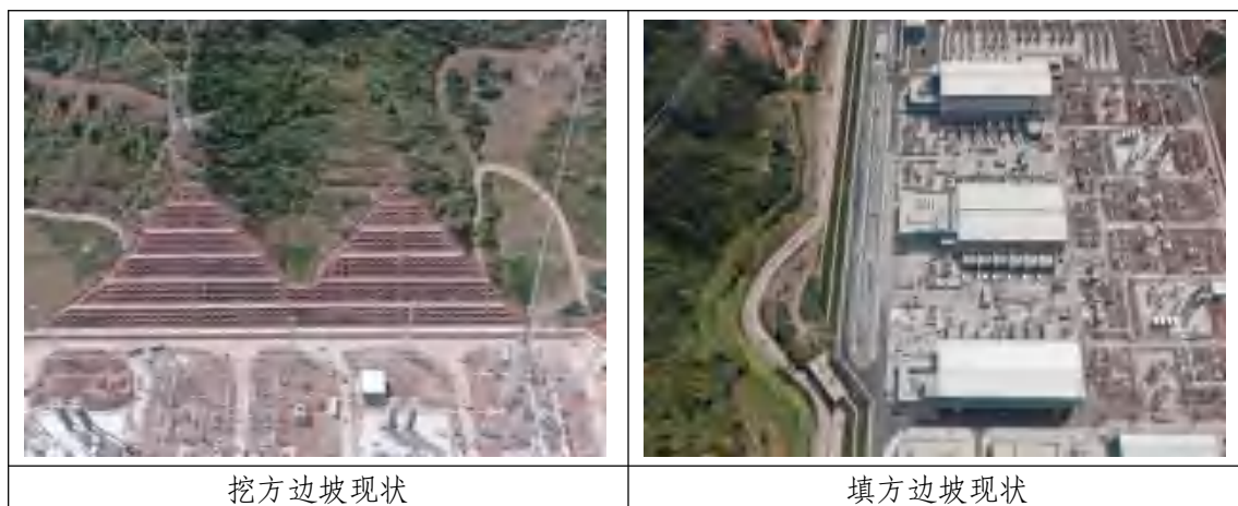
图 3.3-2 渝北换流站挖填边坡影像
