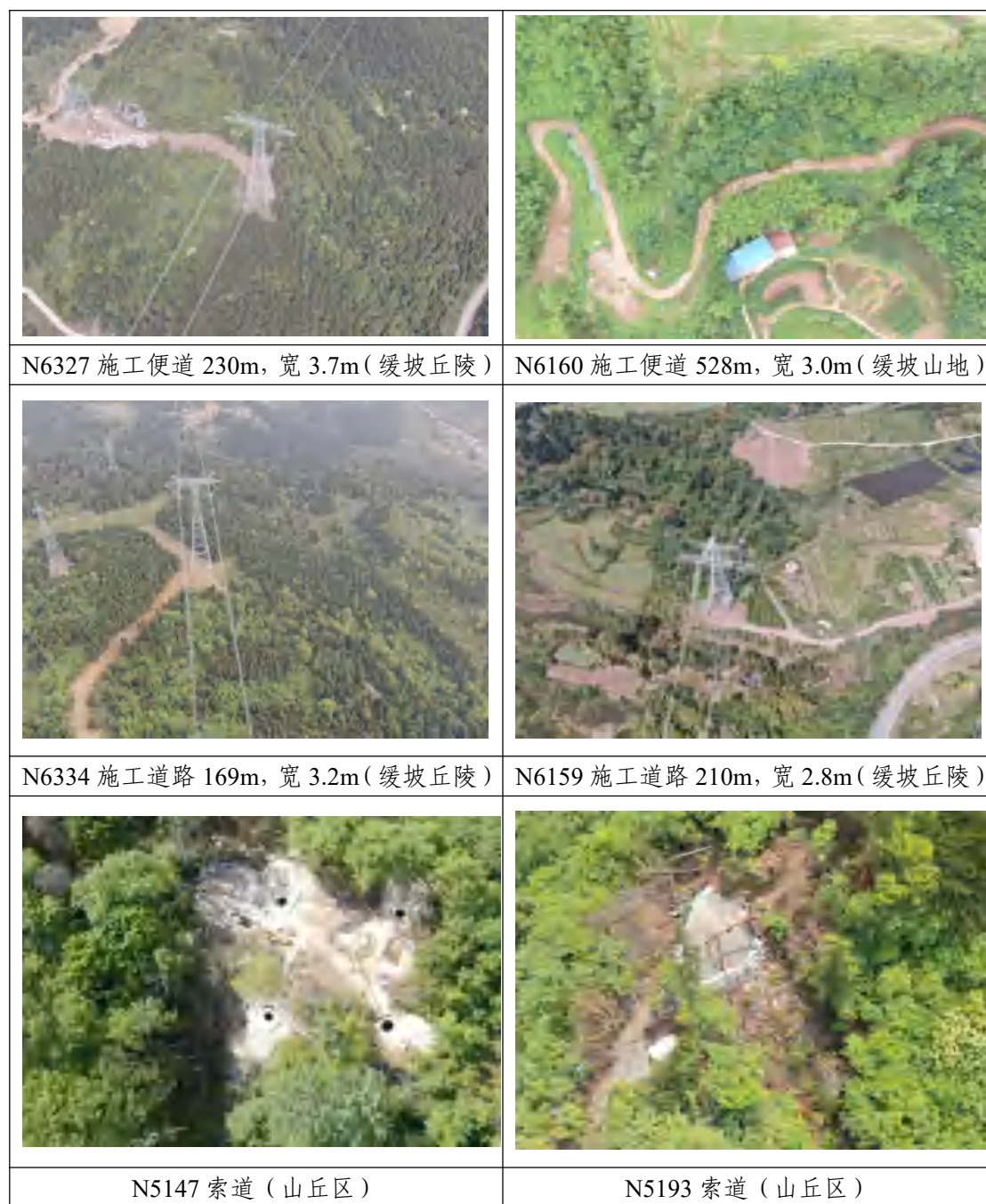
图 3.3-6 输电线路工程施工道路影像
