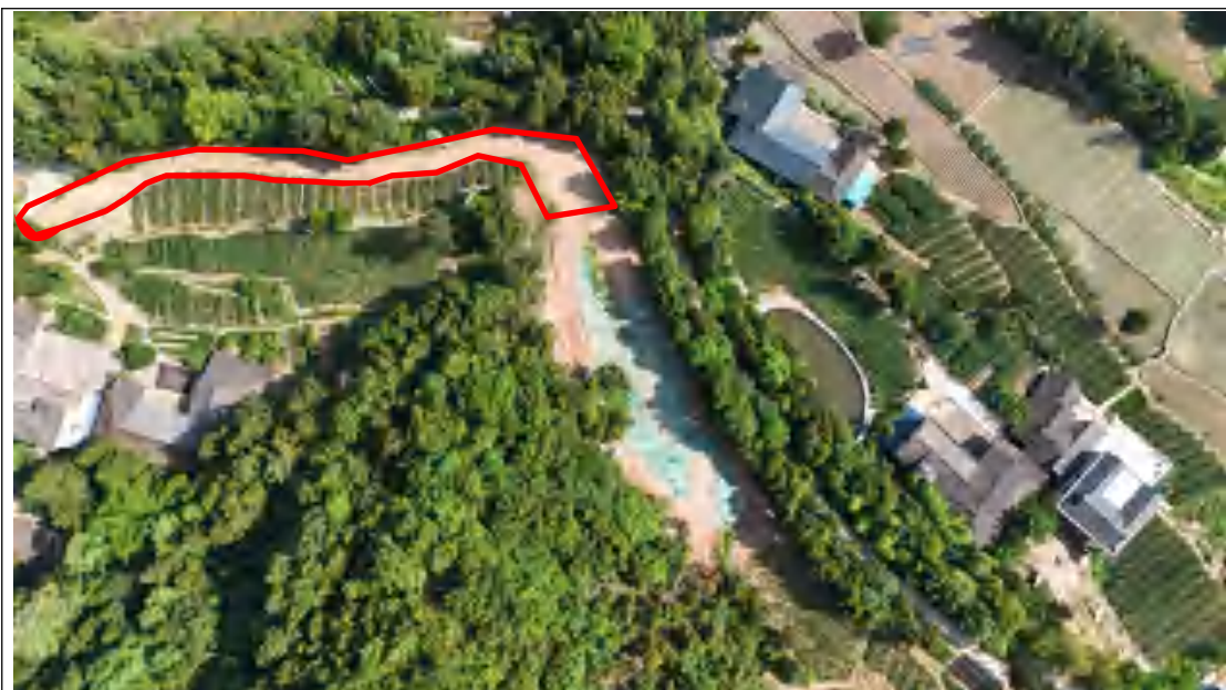
杆塔号：N5737 施工道路无人机正射影像解译（2024.6），道路长度 58m，宽度 2.9m。
