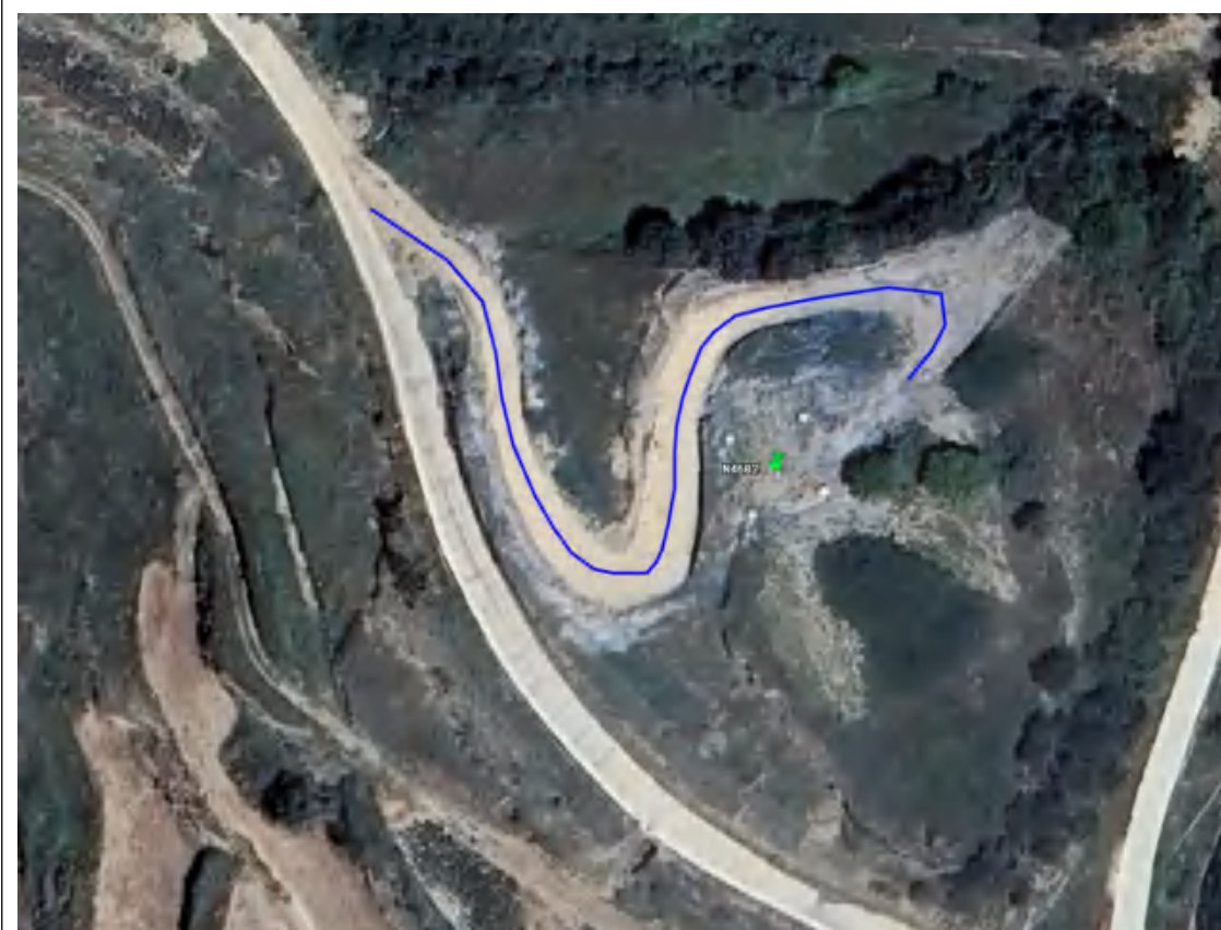
甘肃省武山县，杆塔号：N4602 施工道路遥感正射影像解译，道路长度 132m，宽度 3~5m。
