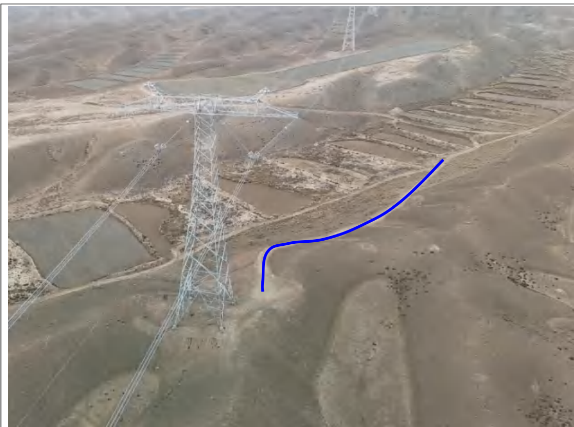
甘肃省景泰县，杆塔号：N3830 施工道路无人机影像解译，道路长度 270m，宽度 3~5m。
