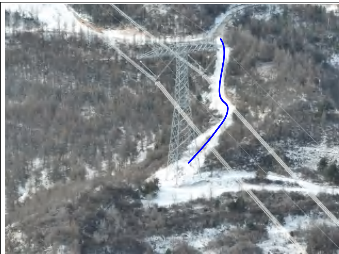
甘肃省武山县，杆塔号：N4809 施工道路无人机影像解译，道路长度 134m，宽度 3~5m。
