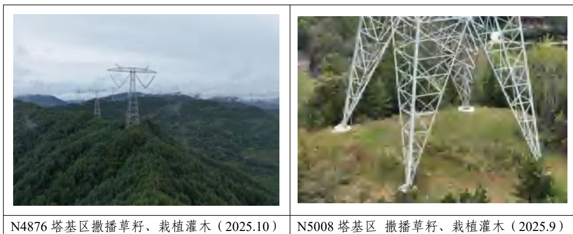
图 3-12 甘肃段直流线路植物措施照片
