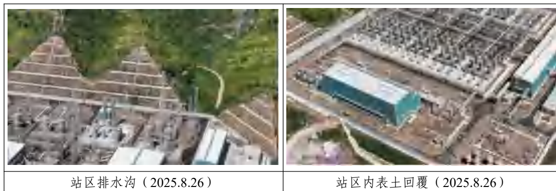
图 3-2 渝北换流站工程措施照片
