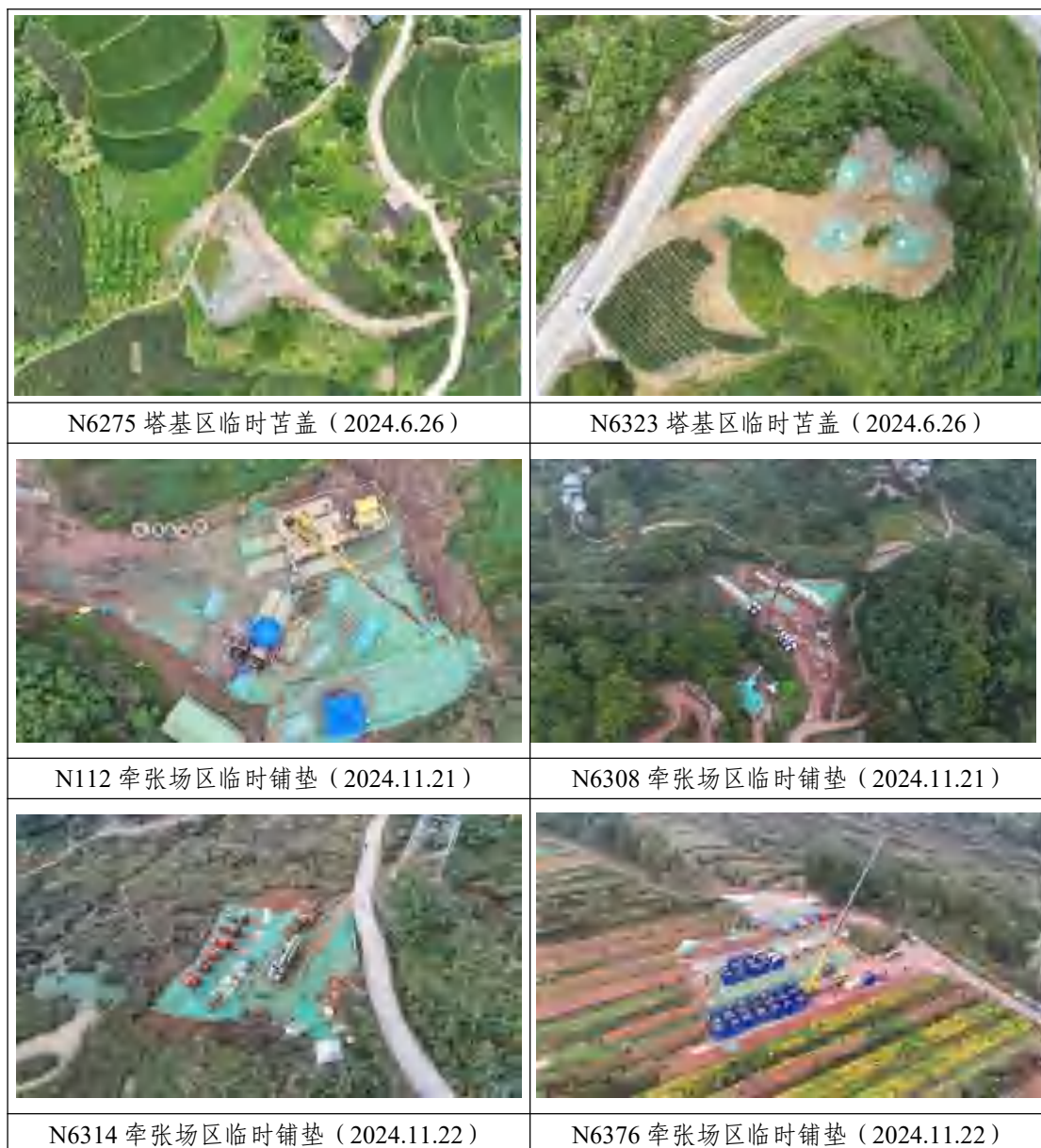
图 3-24 重庆段直流线路临时措施照片
