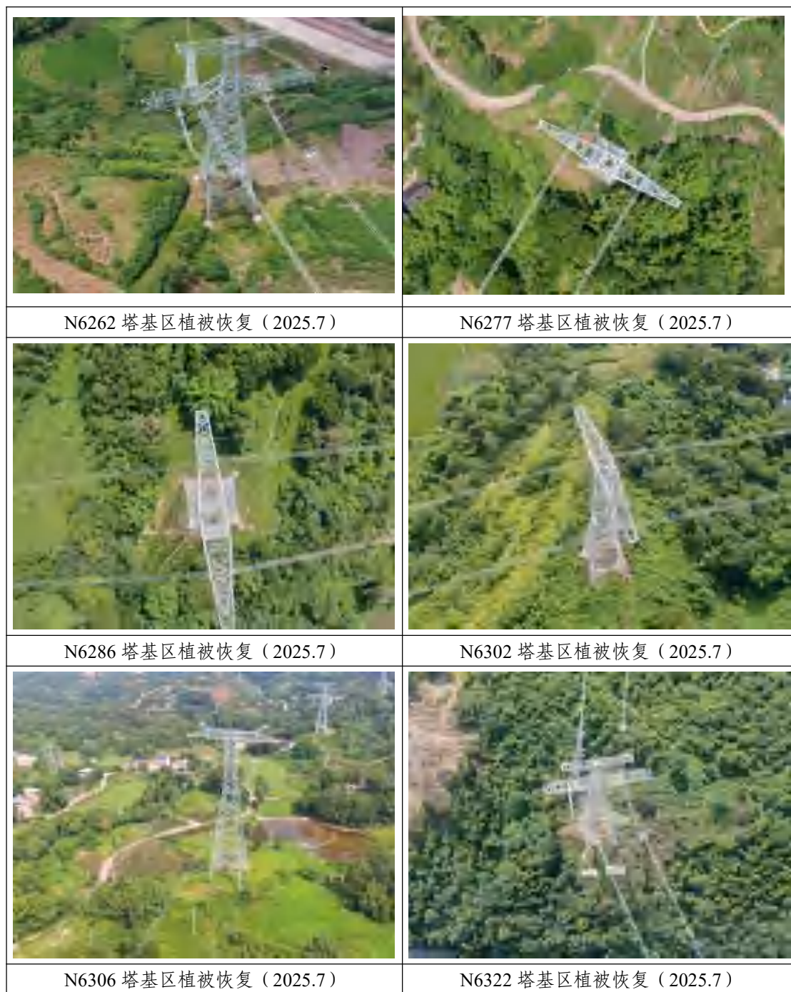
图 3-15 重庆段直流线路植物措施照片
