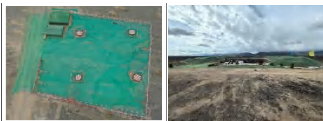
塔基区密目网苫盖、彩条旗围护、彩条布铺垫(2024.03)
