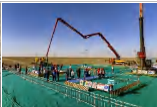
N1968 塔基临时铺垫 (2023.12.20)
