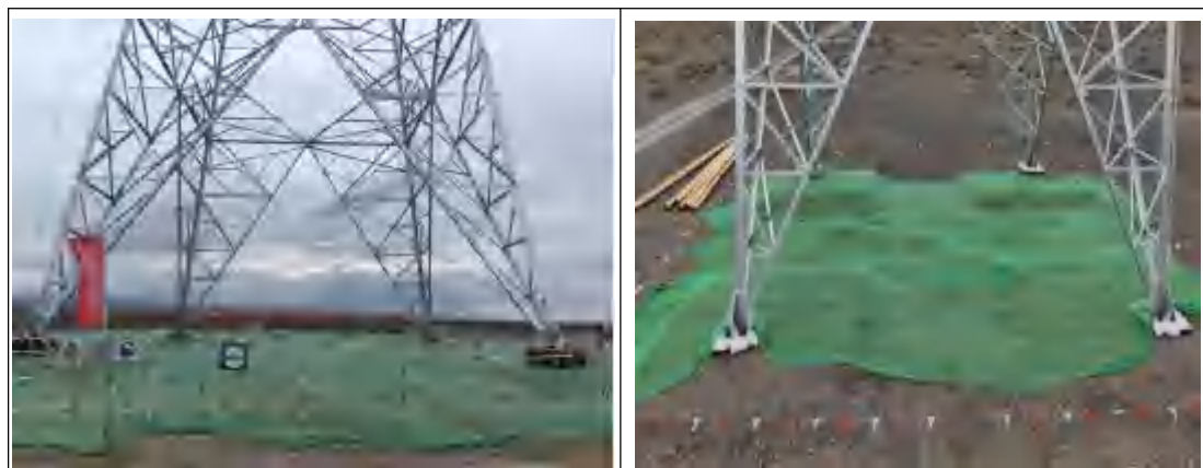
塔基区彩条旗围护、密目网苫盖 (2024.06)
