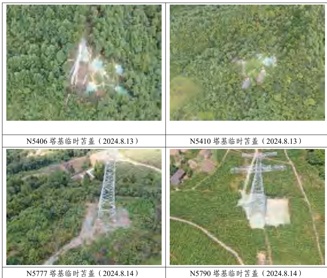
图 3-23 四川段直流线路临时措施照片
