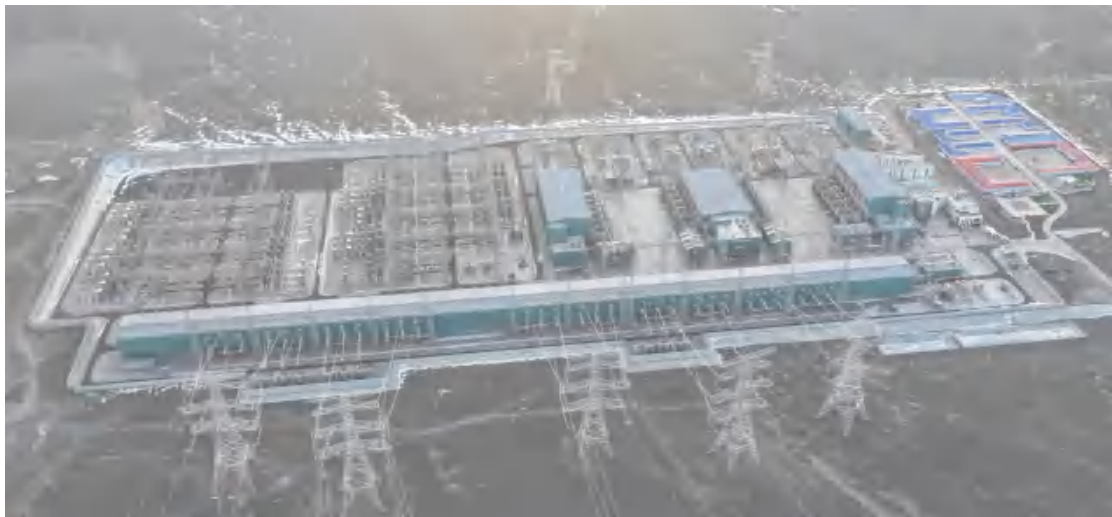
图 1-1 送端换流站全景图
