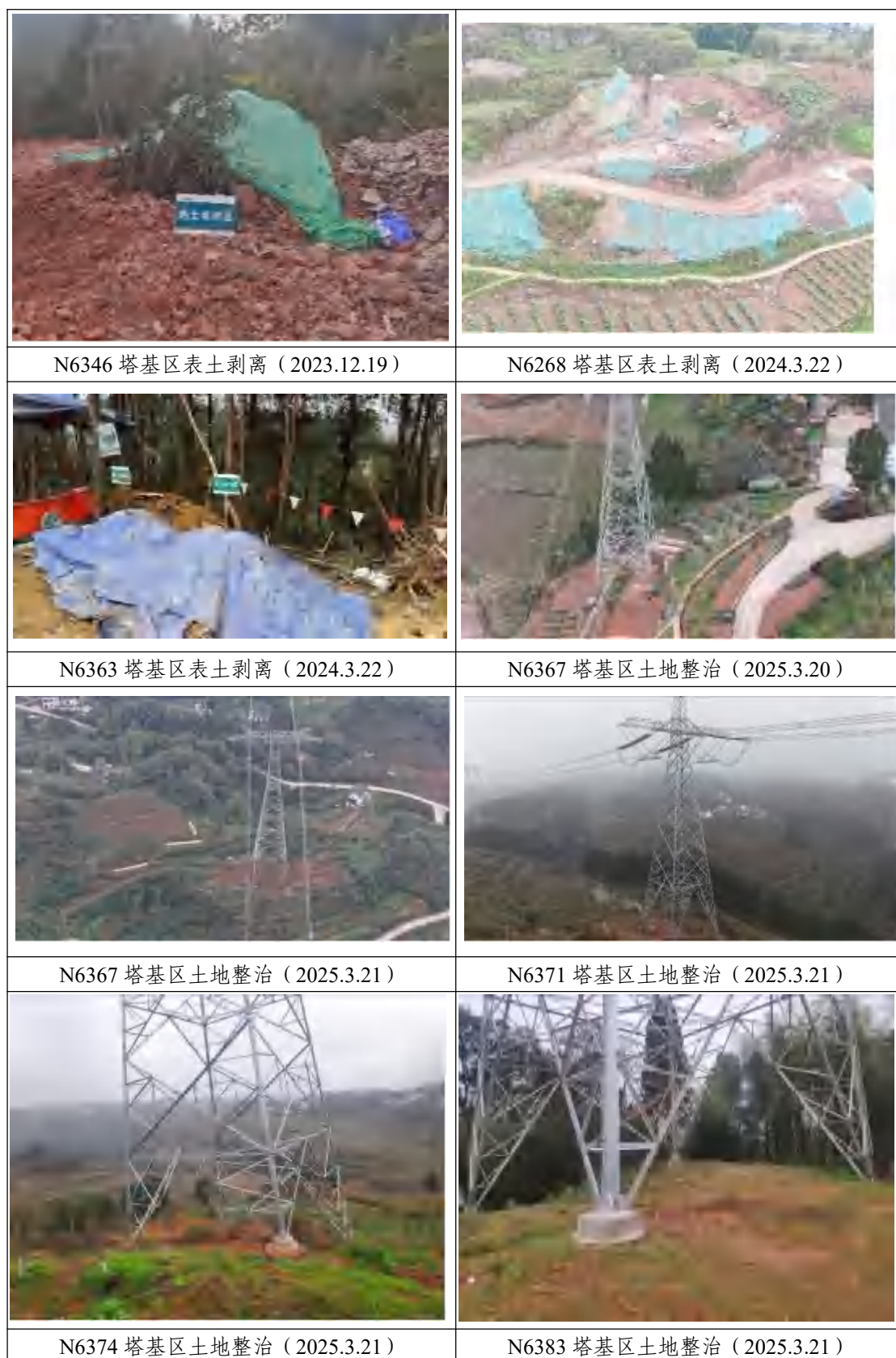
图 3-9 四川段直流线路工程措施照片
