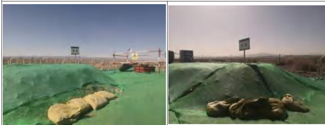
塔基区填土袋拦挡、密目网苫盖(2024.06)
