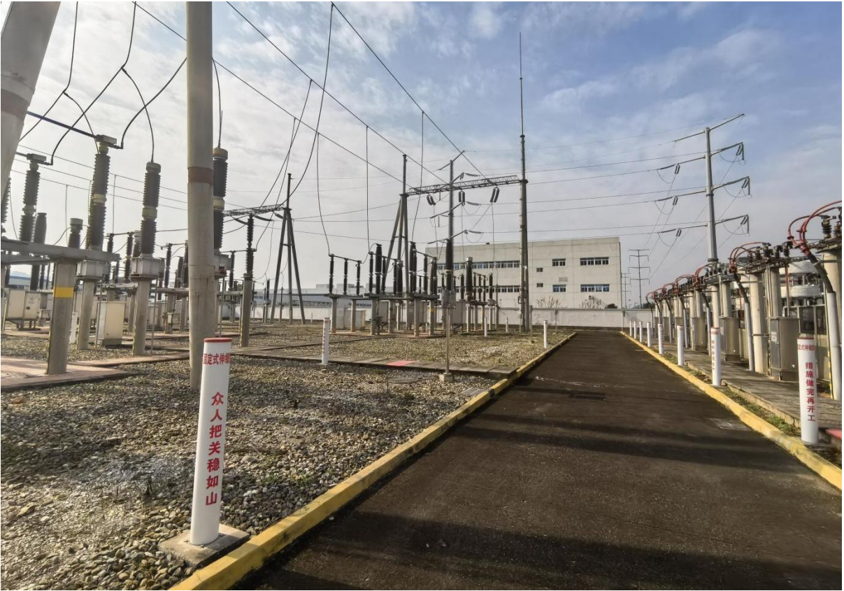
绵阳群文 220kV 变电站现状照片
