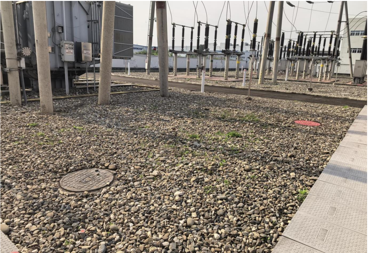
绵阳群文 220kV 变电站现状照片
