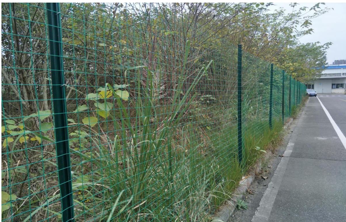
群文 220kV 变电站增容扩建工程现状照片
