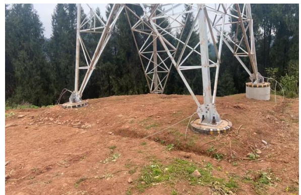
41#塔基及其施工临时占地
