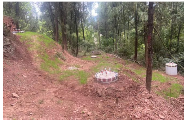
37#塔基及其施工临时占地
