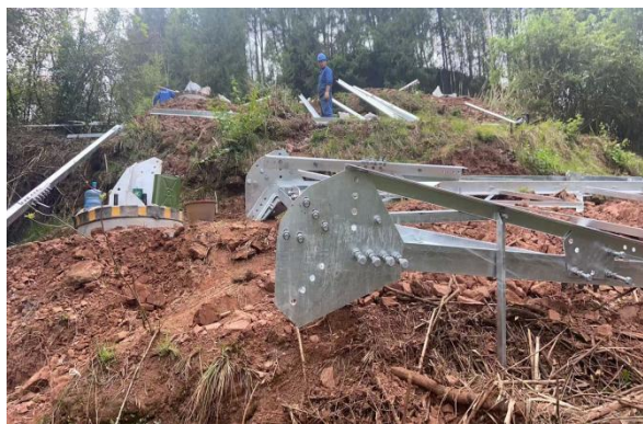
40#塔基及其施工临时占地
