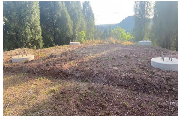
30#塔基及其施工临时占地
