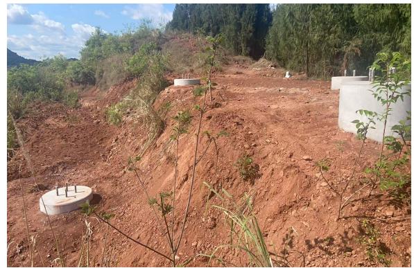
20#塔基及其施工临时占地
