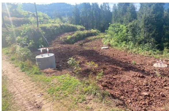
23#塔基及其施工临时占地
