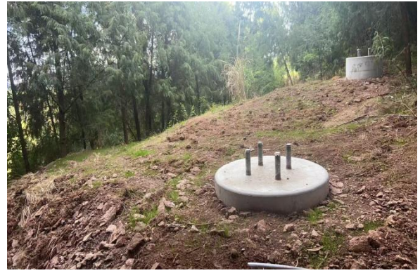
26#塔基及其施工临时占地
