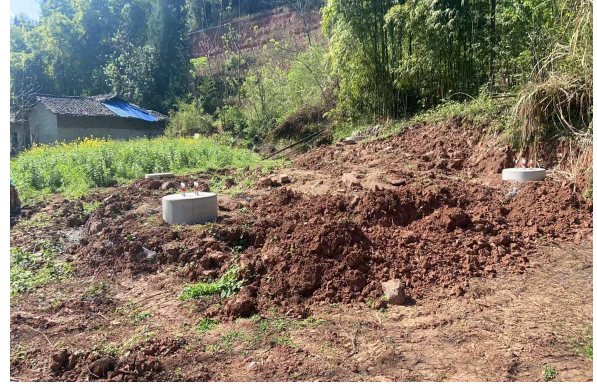
18#塔基及其施工临时占地
