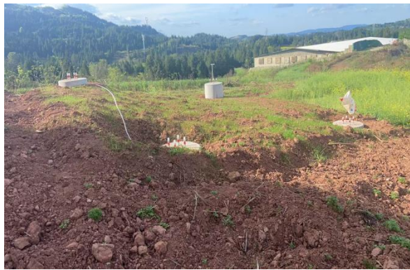
27#塔基及其施工临时占地
