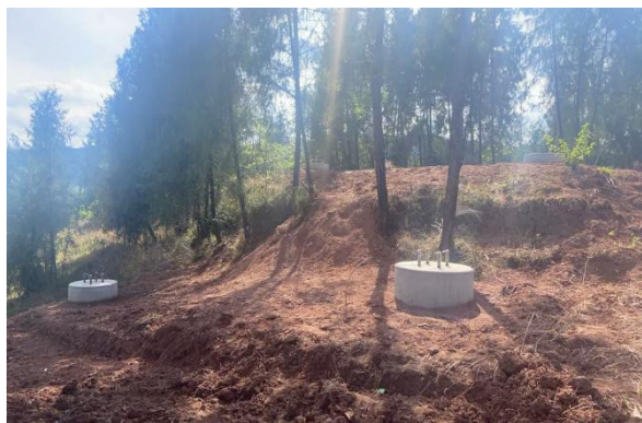
21#塔基及其施工临时占地
