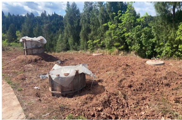
19#塔基及其施工临时占地
