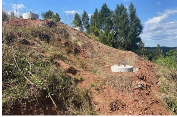
17#塔基及其施工临时占地
