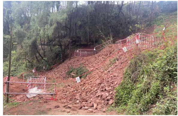
55#塔基及其施工临时占地
