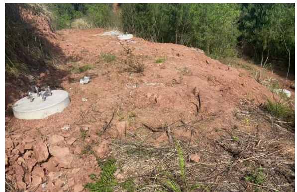
22#塔基及其施工临时占地
