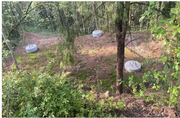
29#塔基及其施工临时占地
