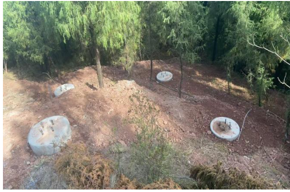
25#塔基及其施工临时占地
