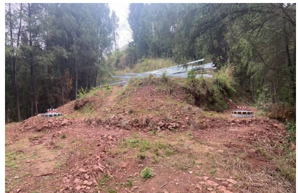
39#塔基及其施工临时占地
