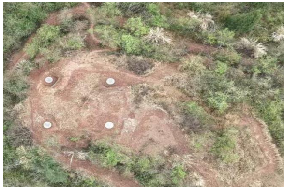
31#塔基及其施工临时占地
