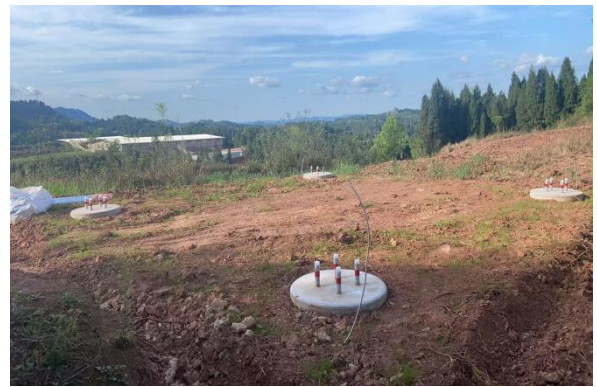
28#塔基及其施工临时占地
