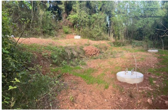
33#塔基及其施工临时占地
