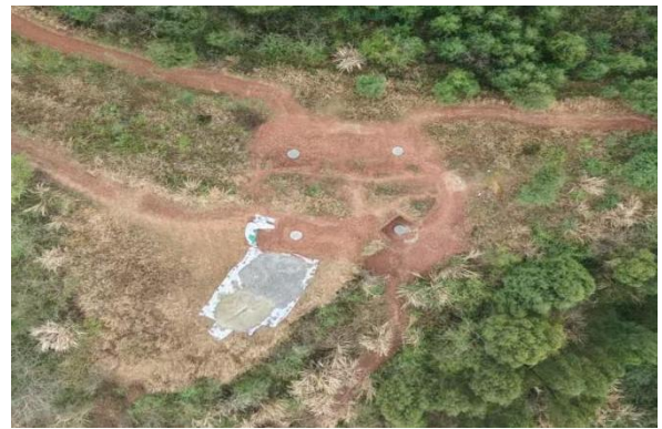
32#塔基及其施工临时占地
