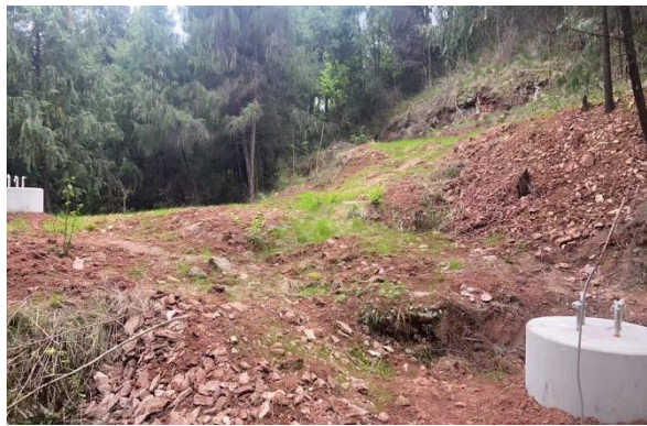
35#塔基及其施工临时占地
