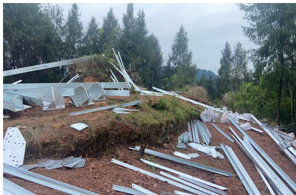
38#塔基及其施工临时占地
