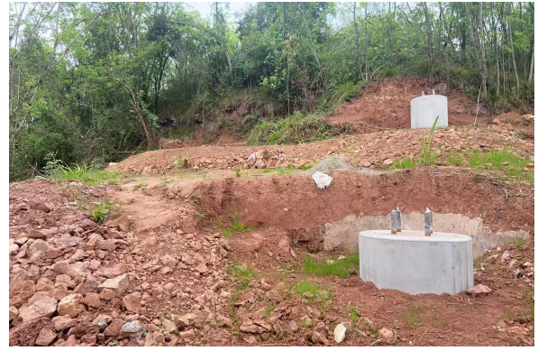
34#塔基及其施工临时占地
