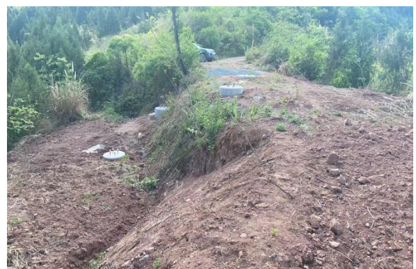
24#塔基及其施工临时占地
