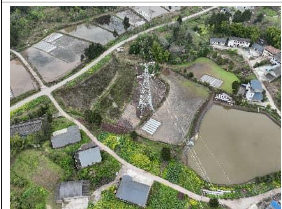
P45 塔基及道路已恢复
