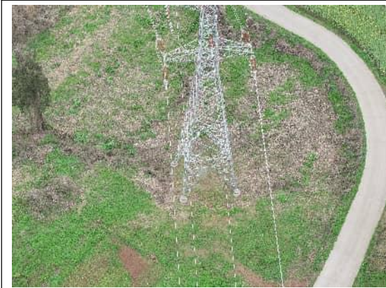
P33 塔基已恢复
