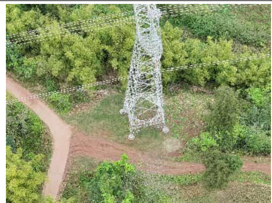
P36 塔基旁存在少量建渣未清理
