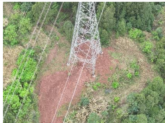
N102 塔基及施工道路恢复（需对道路恢复）
