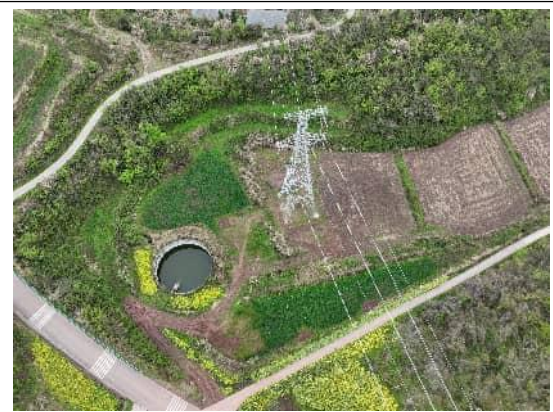
P38 对拓宽道路进行恢复
