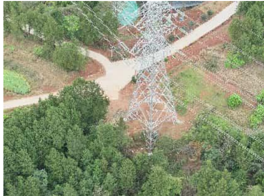
N96 塔基土地整治后撒播草籽
