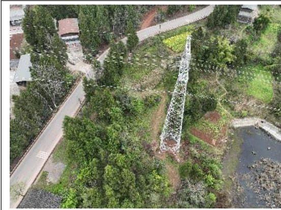
P15 塔基及施工道路需尽快恢复
