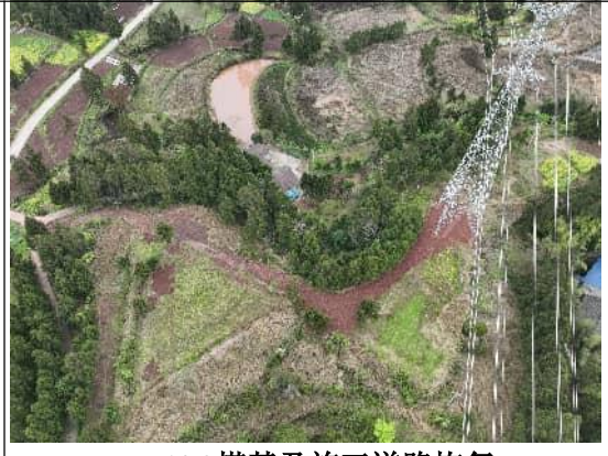
N106 塔基及施工道路恢复
