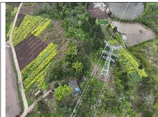
N121 塔基及道路恢复
