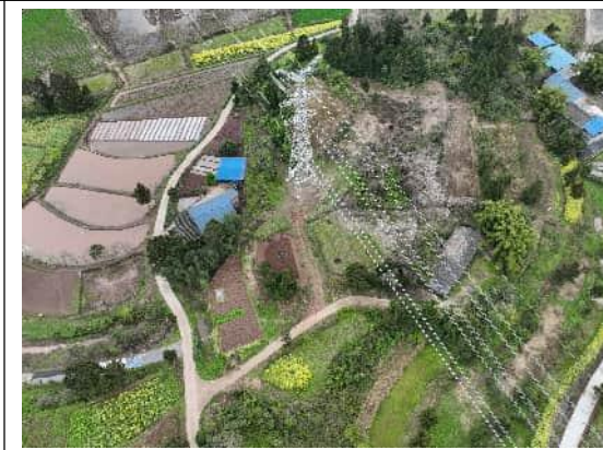
N108 (塔基及道路需尽快恢复)
