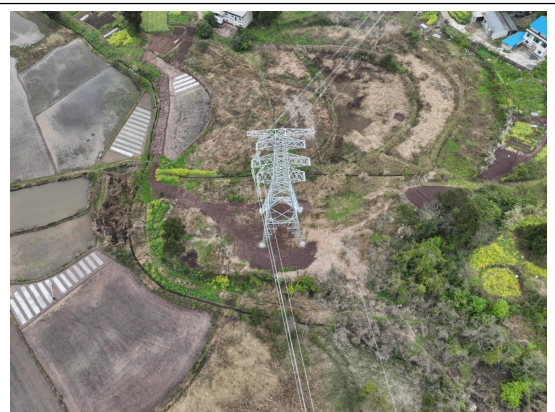
P46 塔基及道路已恢复
