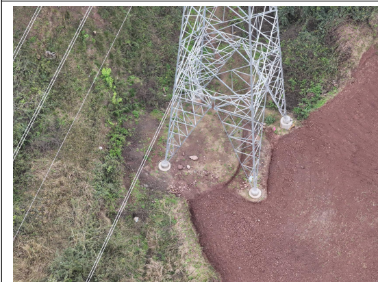
P21 塔基需清理塔基内石块
