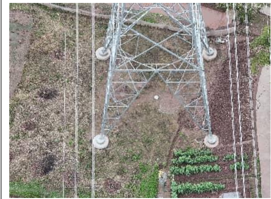
N115 塔基及道路恢复
