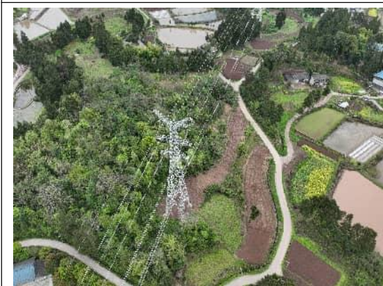
N111 塔基及道路恢复
