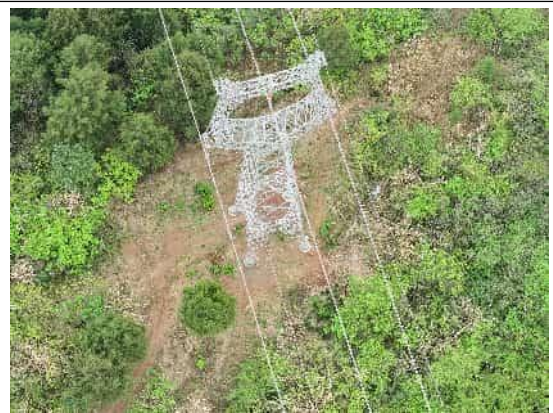
P20 塔基需补撒草籽
