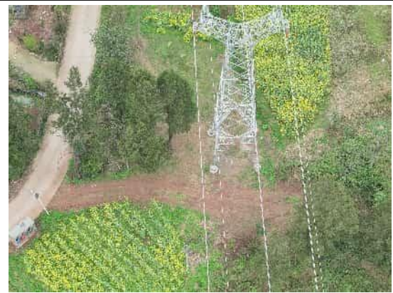
P34 施工道路需尽快恢复
