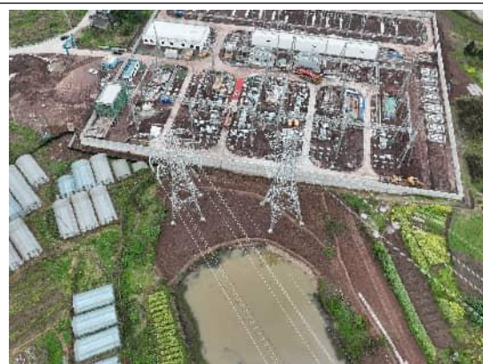
N128 和 P51 塔基及施工道路恢复
