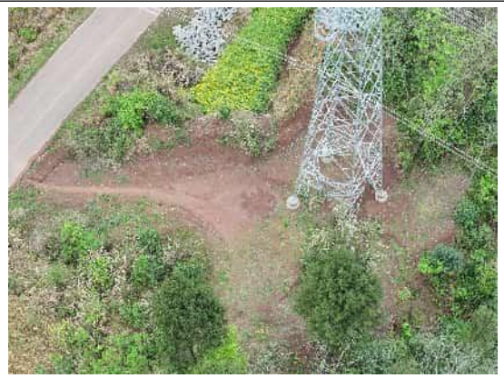
P40 需对塔基及道路进行恢复
