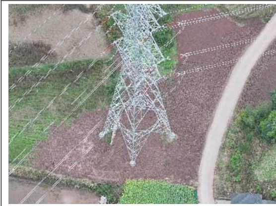
N113 塔基及道路恢复
