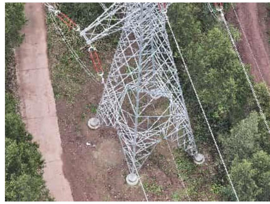
P24 塔基需补撒草籽
