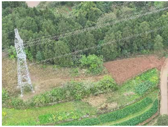
P23 塔基及未恢复道路需补撒草籽
