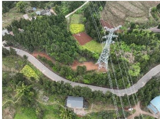
N95 塔基及道路需尽快恢复
