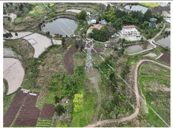
P42 需对塔基及道路进行恢复
