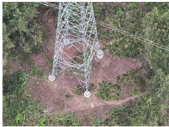
P25 塔基需补撒草籽
