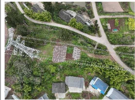
N117 塔基及道路恢复
