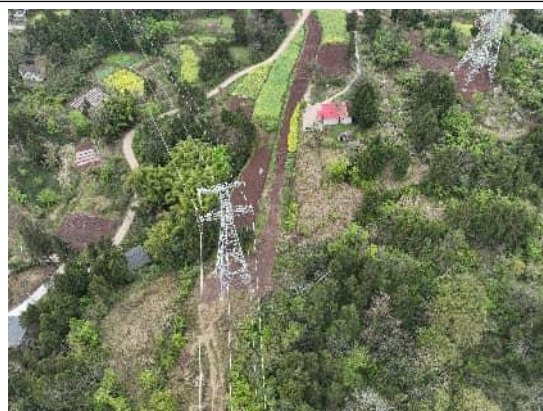
P27 塔基及道路已恢复
