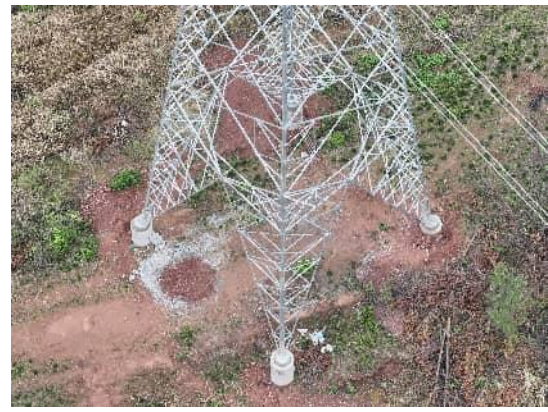
N98 塔基土地整治后撒播草籽
