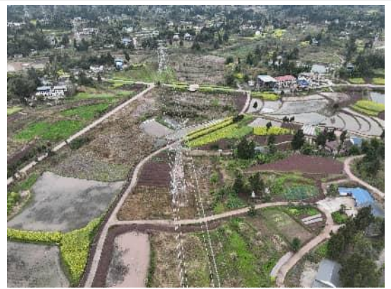
N118 塔基及道路恢复
