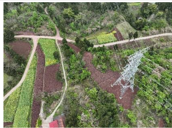
N104 塔基及施工道路恢复
