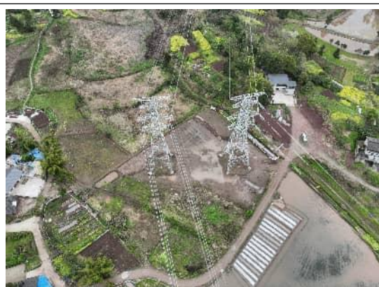
N125 和 P48 塔基恢复
