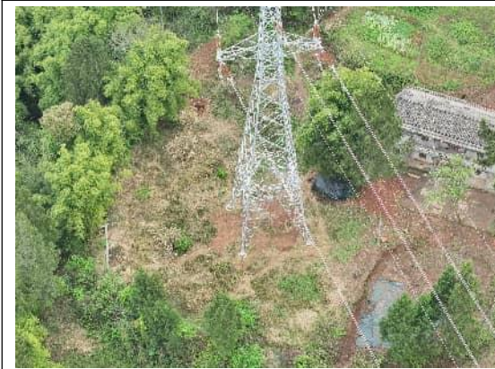
P17 塔基已恢复
