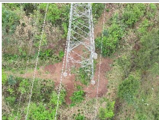
P29 塔基需补撒草籽
