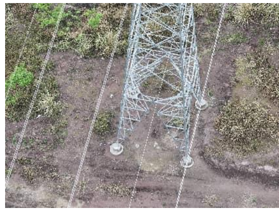
P26 塔基及道路需补撒草籽
