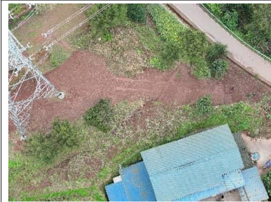
N107 塔基及施工道路恢复
