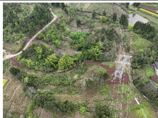
P28 塔基及道路已恢复
