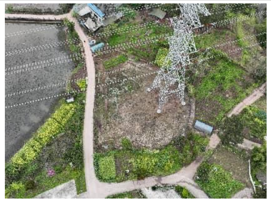
N120 塔基及道路恢复
