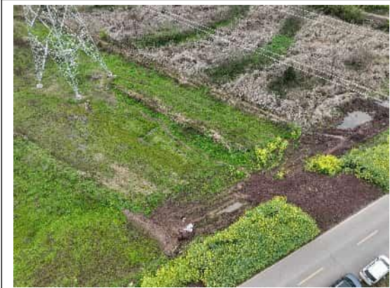
N119 塔基及道路恢复
