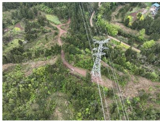
N101 塔基（需对塔基及道路尽快恢复）
