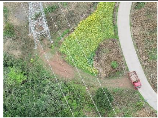
P32 塔基及施工道路需尽快恢复
