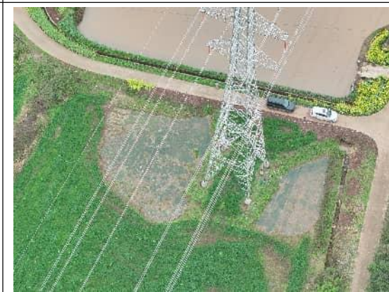
N110 塔基及道路恢复
