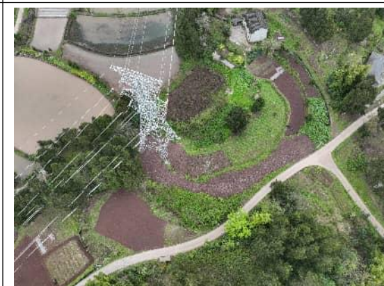
N112 塔基及道路恢复
