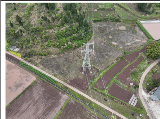
P37 塔基已恢复
