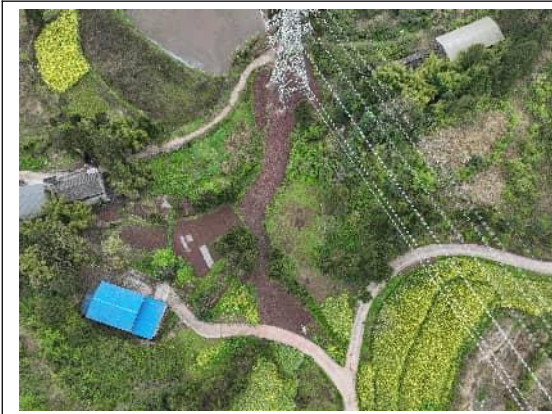
N105 塔基及施工道路恢复
