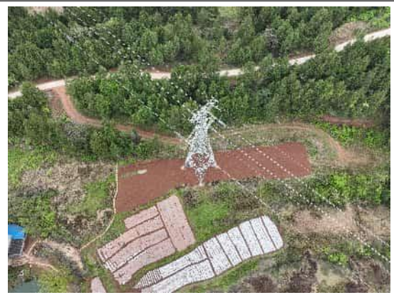
P16 塔基及施工道路已恢复
