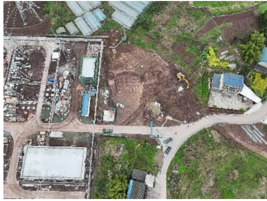
站外施工临时场地恢复中，需尽快复耕
