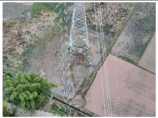
N114 塔基及道路恢复
