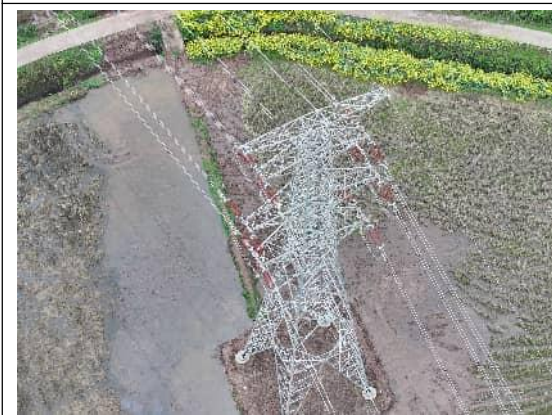
N109 塔基及道路恢复
