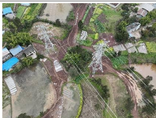
N127 和 P50 塔基恢复
