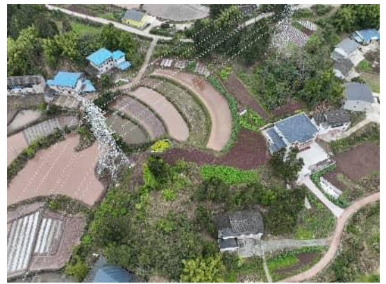
N116 塔基及道路恢复
