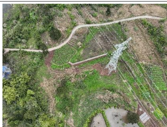
N123 塔基及道路恢复
