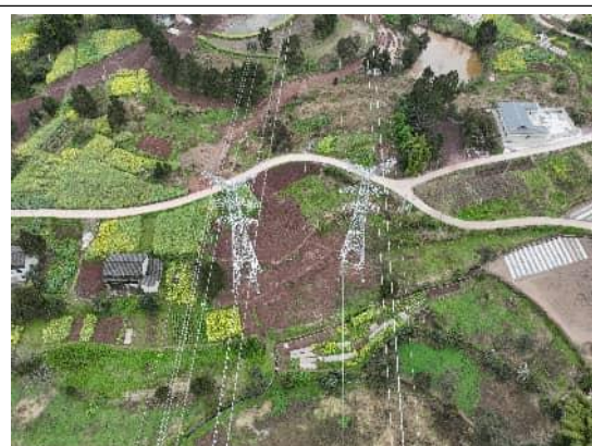
N126 和 P49 塔基恢复
