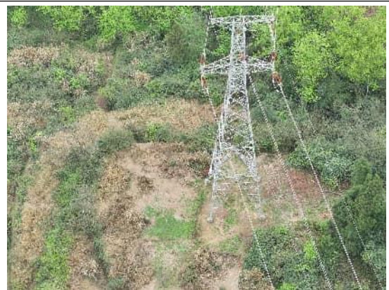
P22 塔基已恢复
