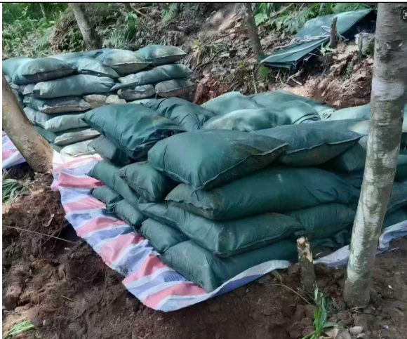
塑料布铺垫、土袋拦挡 (2025.8)
