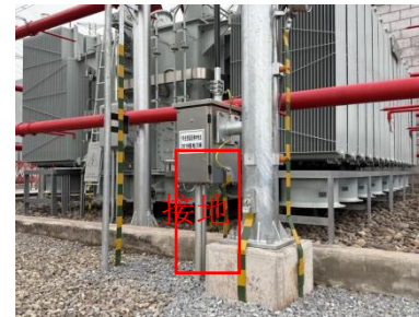
电气设备接地 (1#主变)
