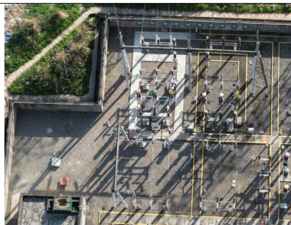
永安变电站间隔铺设碎石
