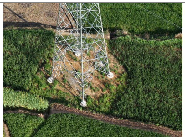
草池~岭上 N4 塔土地整治、植被恢复
