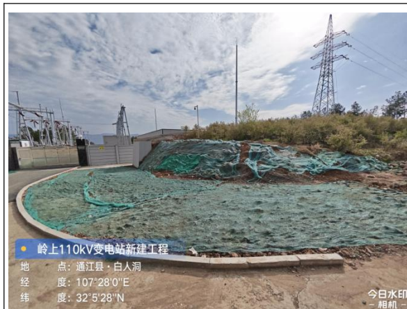
进站道路外侧空地覆土、土地整治、撒播草籽、临时遮盖
