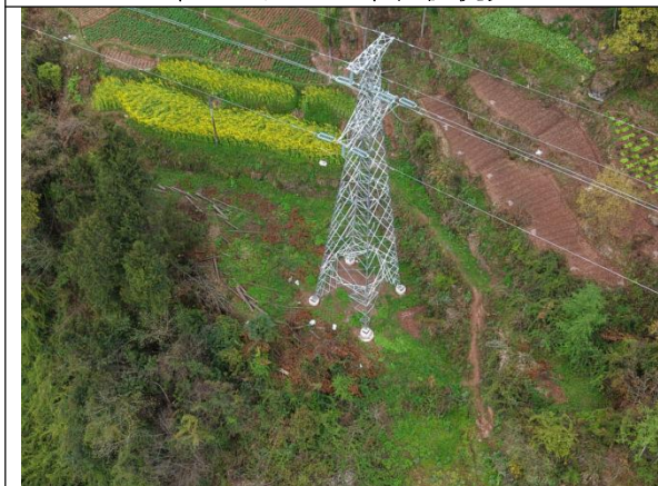
草池~岭上 N26 塔土地整治、植被恢复
