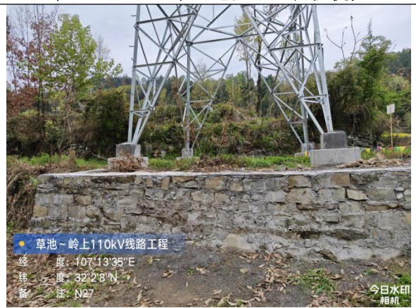
草池~岭上 N27 塔挡土墙、植被恢复
