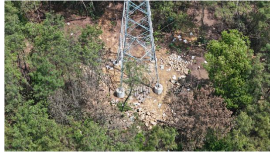
AN02 已组建塔基地表裸露,施工结束后及时清理建筑垃圾,定点堆放,并复绿(2026.3)
