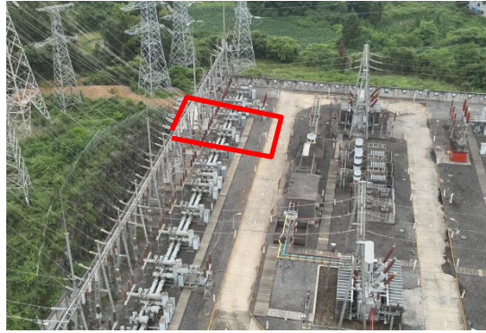
冯冲湾站扩建区域现状
