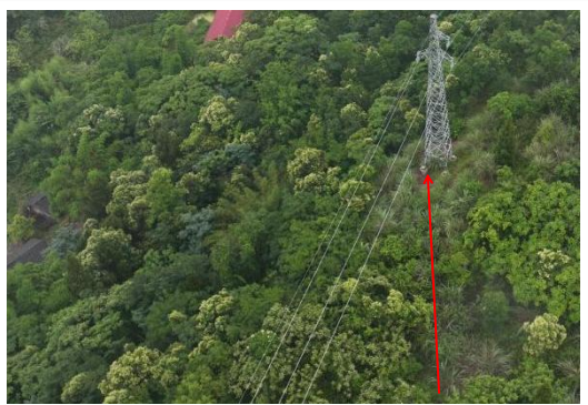
N31#塔位施工道路现状
