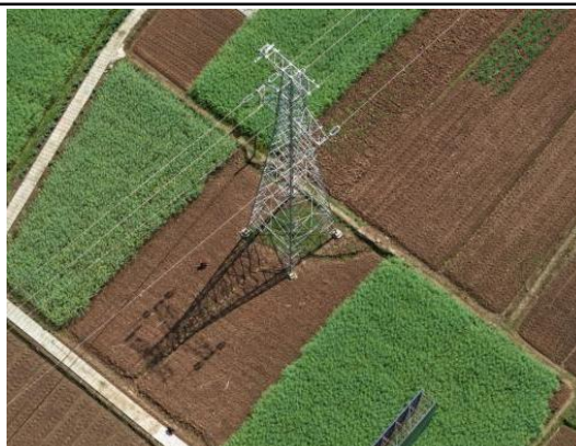
N26#新建铁塔
