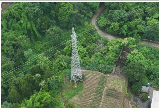
N33#新建铁塔
