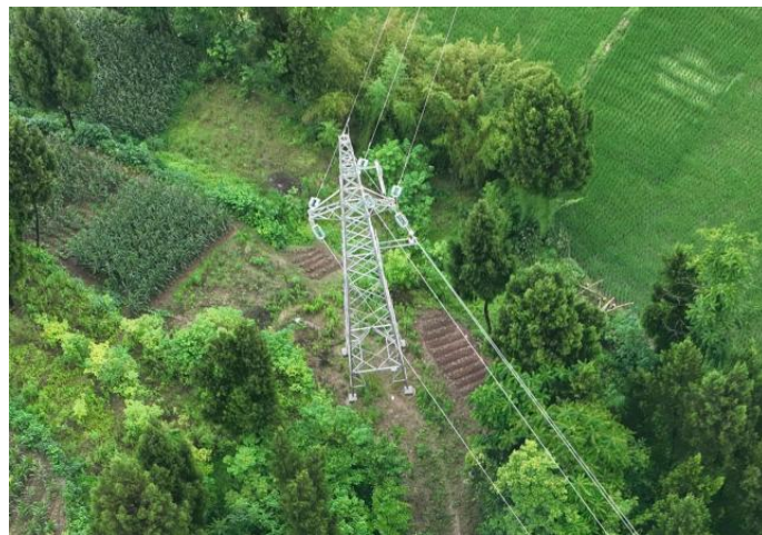
B3#新建铁塔
