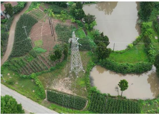
B1#新建铁塔
