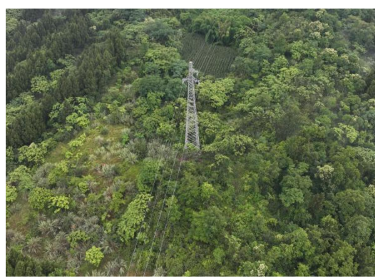
N20#新建铁塔
