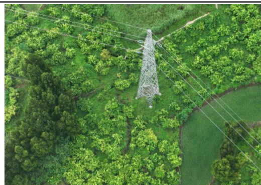
N4#新建铁塔
