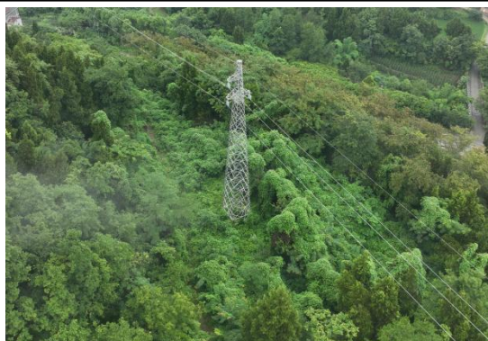
N27#新建铁塔
