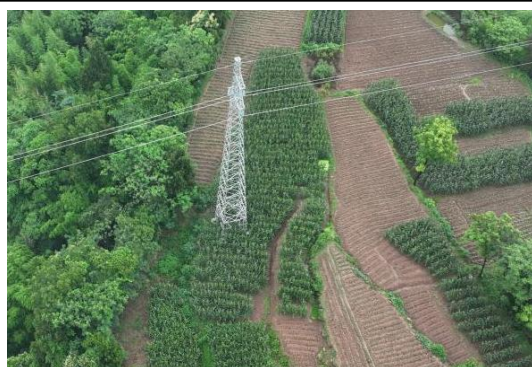
N12#新建铁塔
