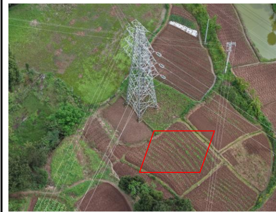
N1#塔位牵张场现状
