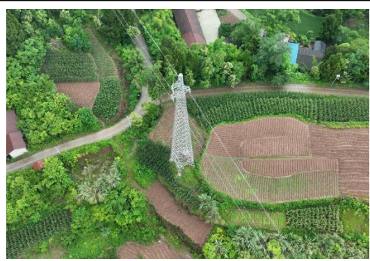
N17#新建铁塔
