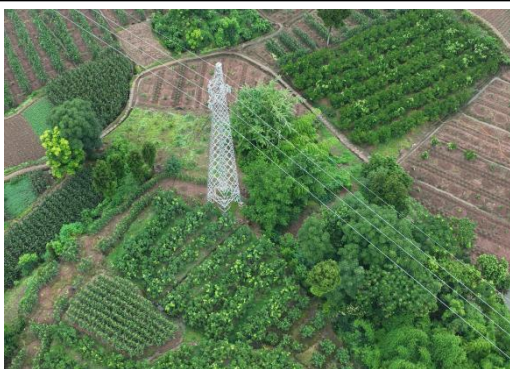
N34#新建铁塔
