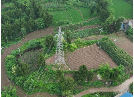
B2#新建铁塔
