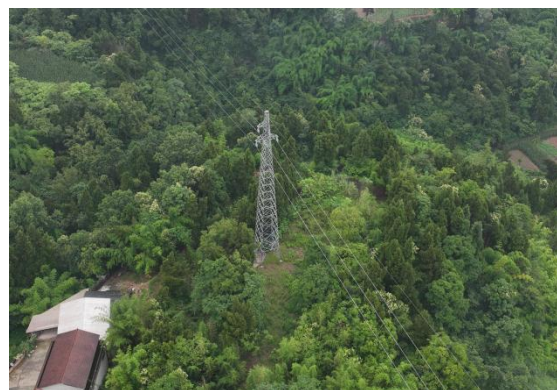
N18#新建铁塔
