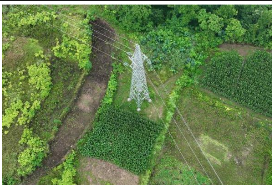
N14#新建铁塔
