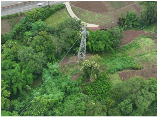
N35#新建铁塔
