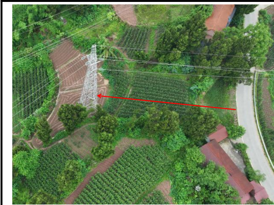
N2#塔位施工道路现状
