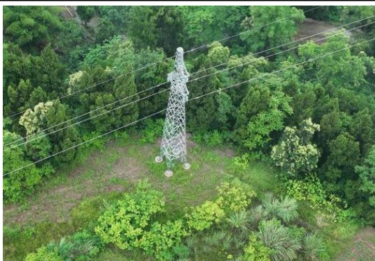
N16#新建铁塔
