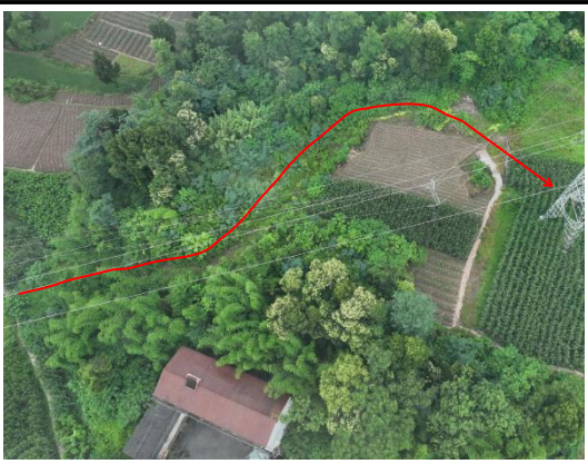
N6#塔位施工道路现状
