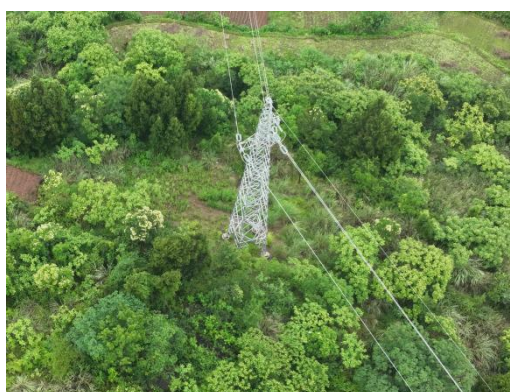
N30#新建铁塔
