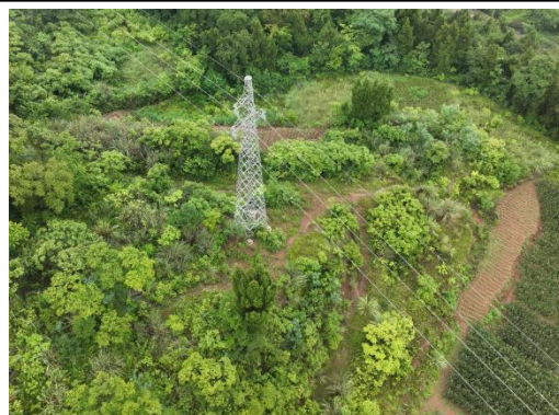
N28#新建铁塔
