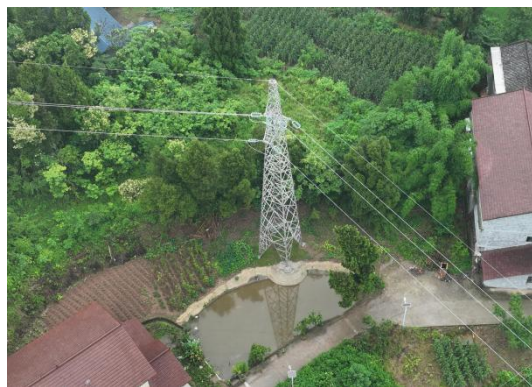
N10#新建铁塔
