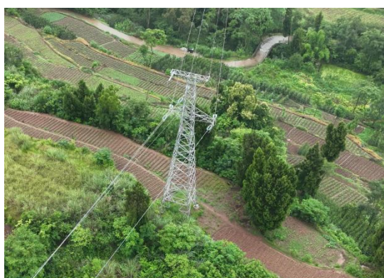
N29#新建铁塔
