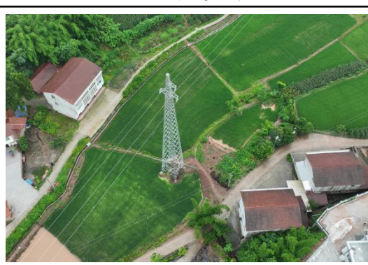
N22#新建铁塔
