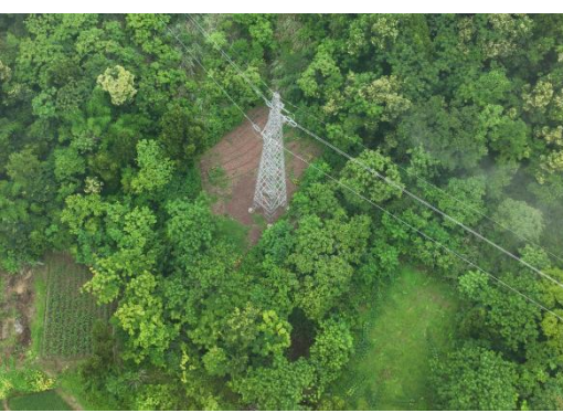
N32#新建铁塔
