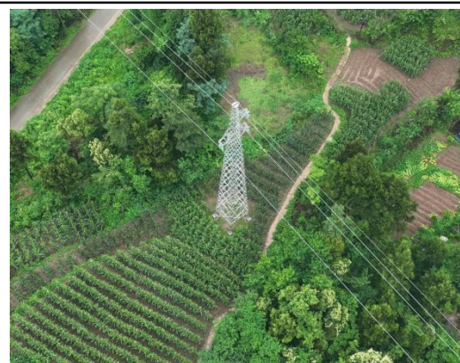
N8#新建铁塔
