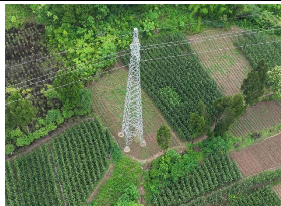
N23#新建铁塔
