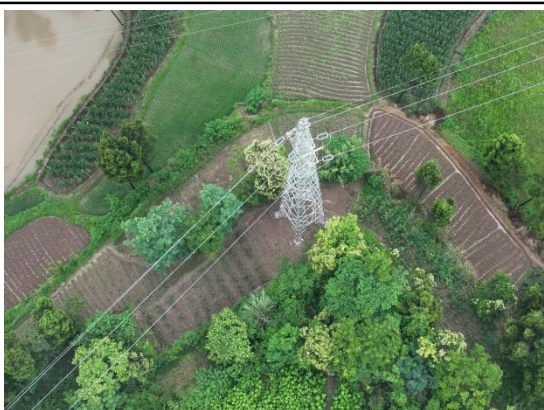
N7#新建铁塔
