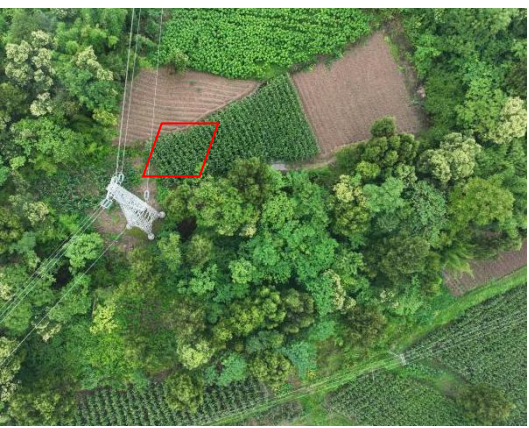
N9#塔位牵张场现状
