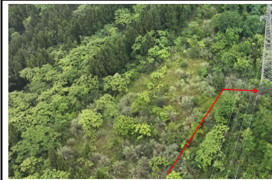
N20#塔位施工道路现状
