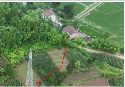
N23#塔位施工道路现状
