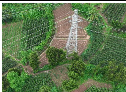
N2#新建铁塔
