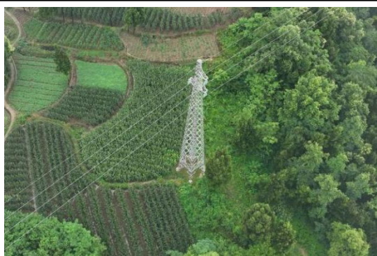
N11#新建铁塔
