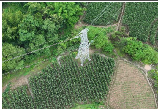
N15#新建铁塔
