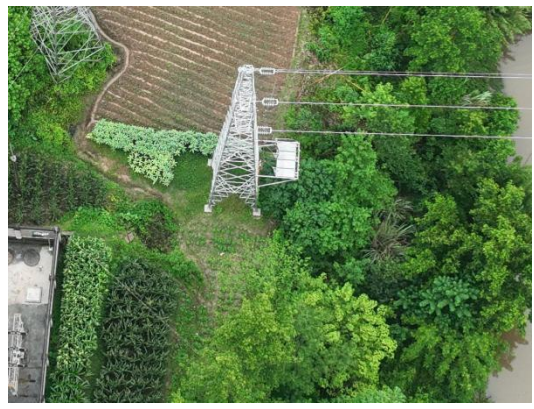
N36#新建铁塔
