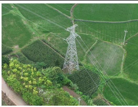
N24#新建铁塔
