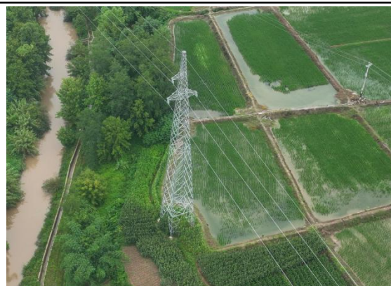
N25#新建铁塔
