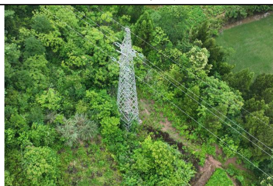
N21#新建铁塔
