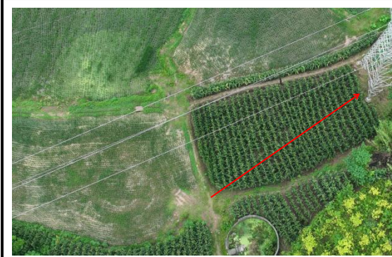
N24#塔位施工道路现状
