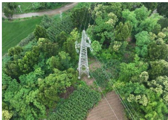
N9#新建铁塔
