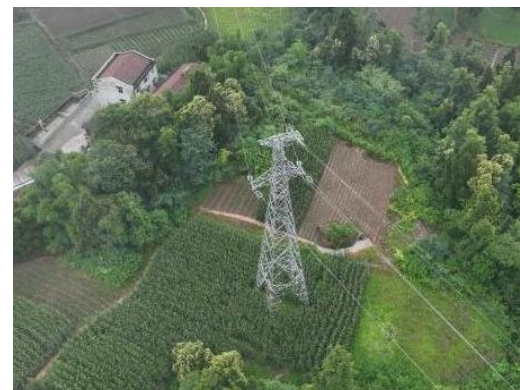
N6#新建铁塔
