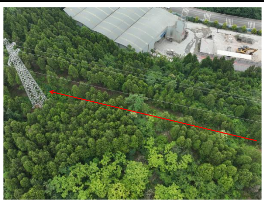
N27#塔位施工道路现状
