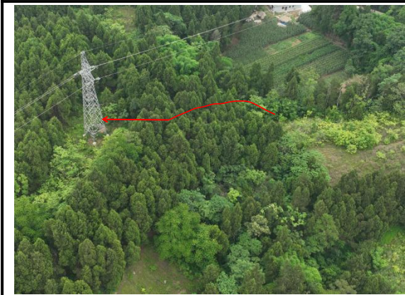
N16#塔位施工道路现状
