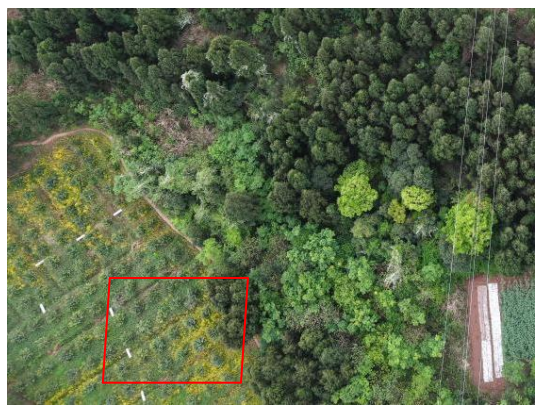
N18#塔位牵张场现状
