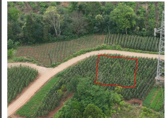
N7#塔位牵张场现状
