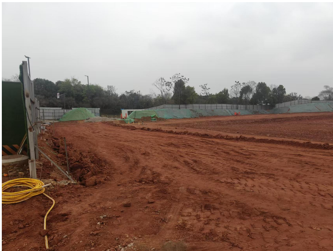
图5-1 施工现场照片
