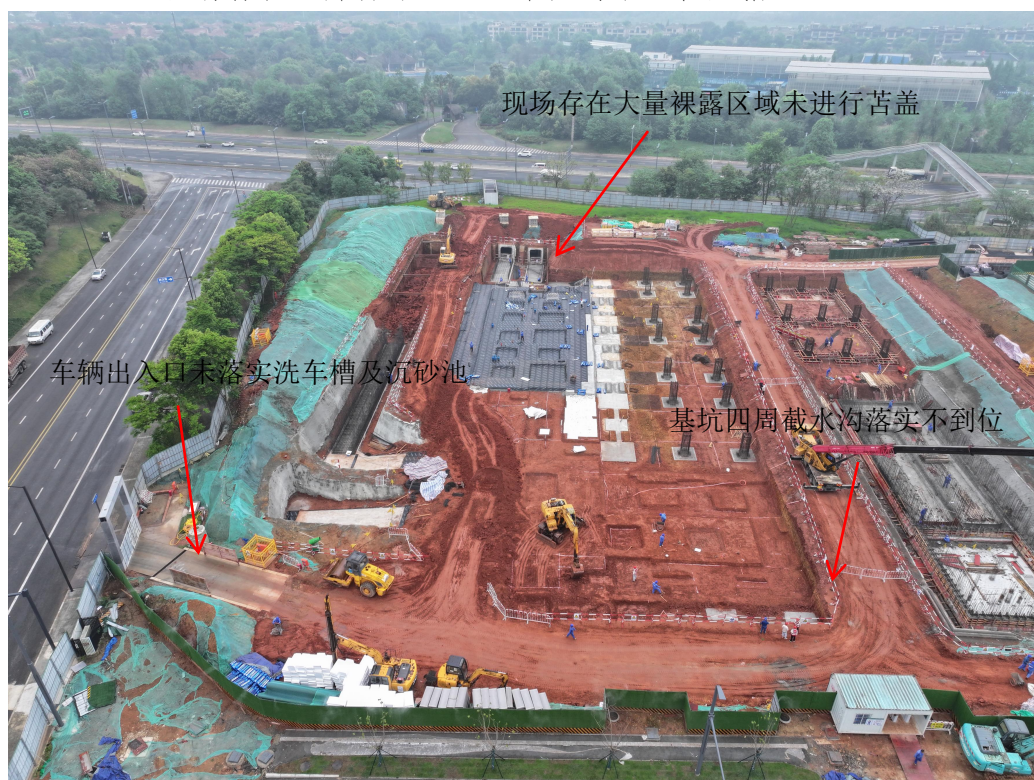
图5-1 施工现场航拍图
