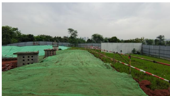
图8-3表土及回填土堆场苫盖
