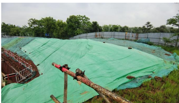
图8-3表土及回填土堆场苫盖
