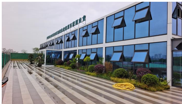
图 8-2 临建设施区植物措施
