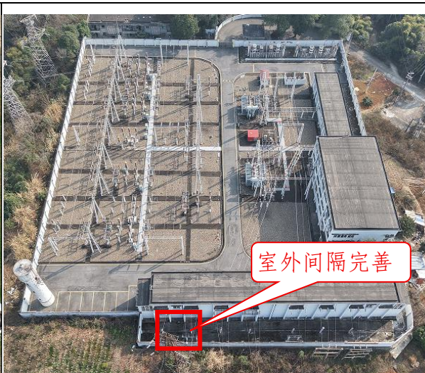
淮口 110kV 变电站
