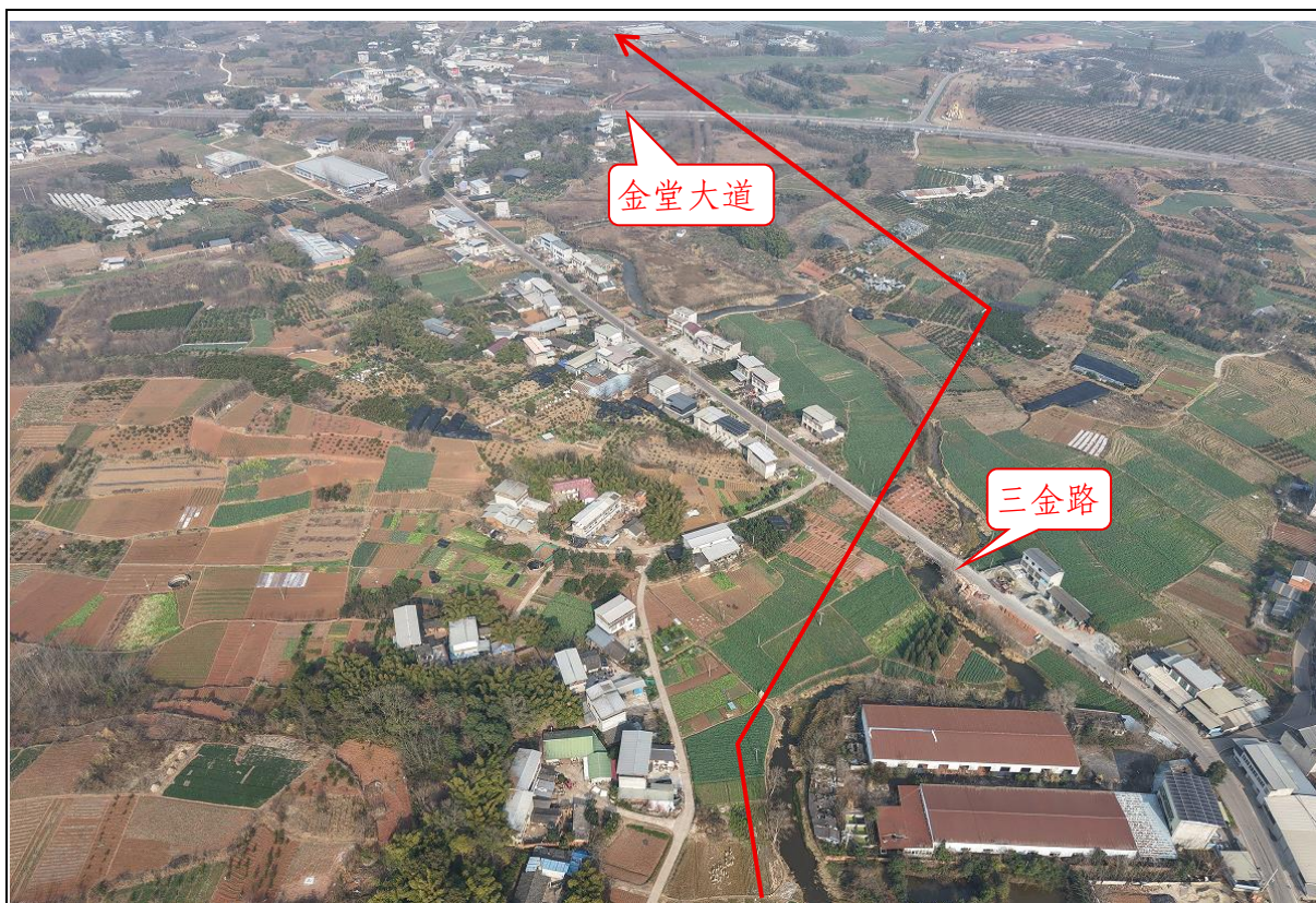
N14~N20 段、跨越三金路、金堂大道沿线情况
