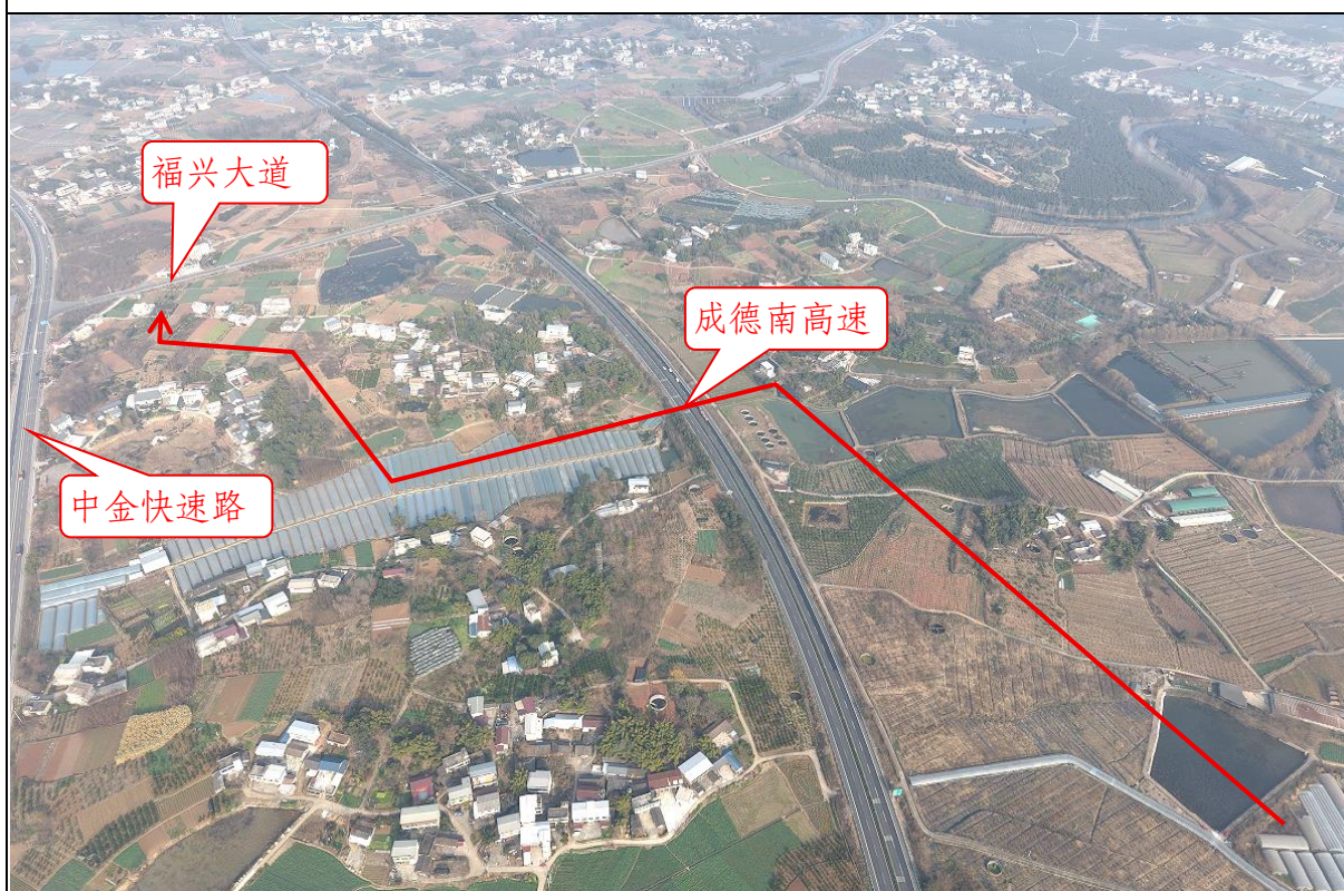
N36~N43 段、跨越成德南高速沿线情况
