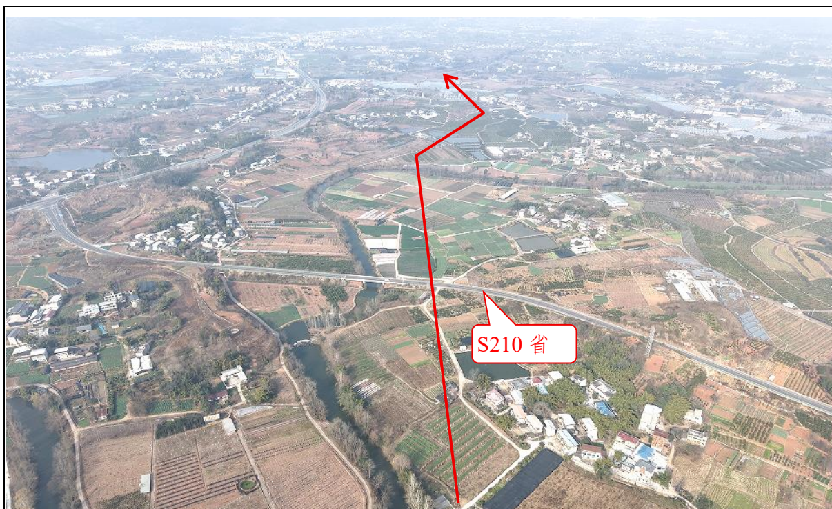
N30~N36 段、跨越 S210 省道沿线情况
