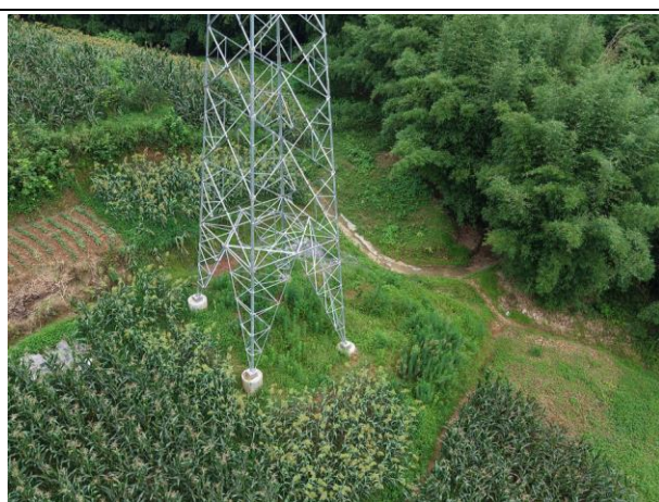
N4 塔基及其施工临时占地恢复情况
