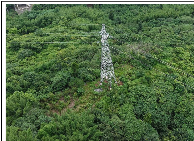
N21 塔基及其施工临时占地恢复情况
