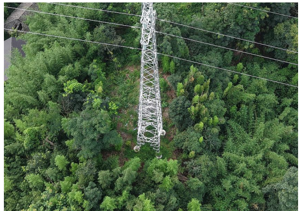
N10 塔基及其施工临时占地恢复情况
