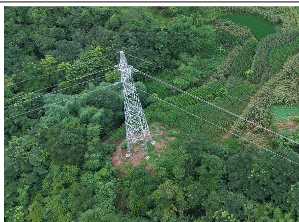
N22 塔基及其施工临时占地恢复情况
