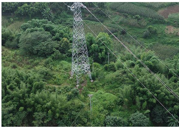
N9 塔基及其施工临时占地恢复情况
