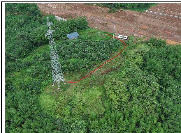
N8 施工道路区恢复情况
