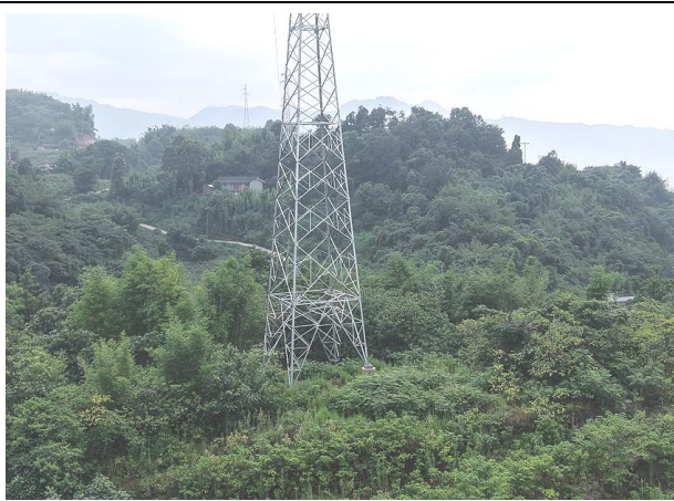
N11 塔基及其施工临时占地恢复情况
