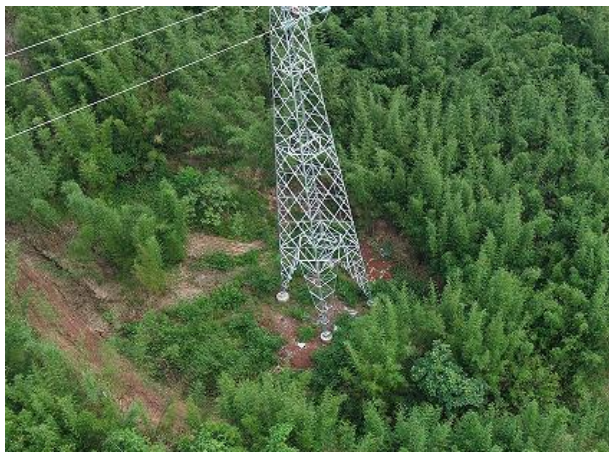
N7 塔基及其施工临时占地恢复情况
