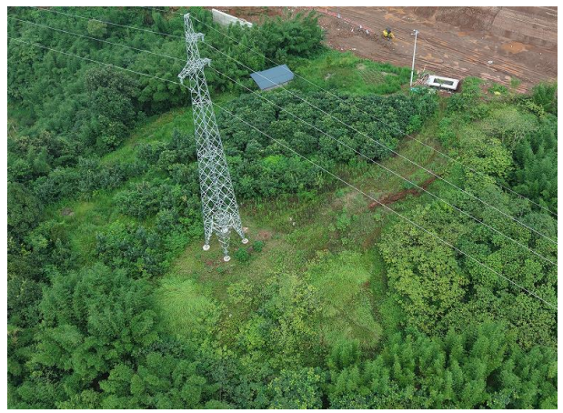
N8 塔基及其施工临时占地恢复情况
