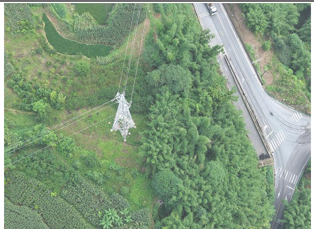
N12 塔基及其施工临时占地恢复情况
