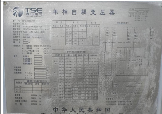
图 3-11 站内既有#1 主变铭牌（绝缘油油量为 59.62t，折合体积约 66.6m 3 ）
