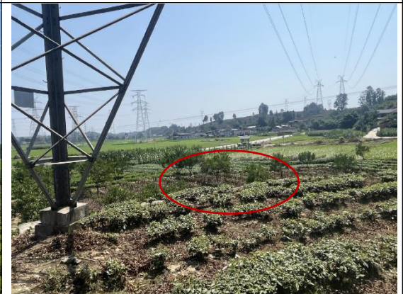
南天—圣达二线拟建 N2 塔基现状
