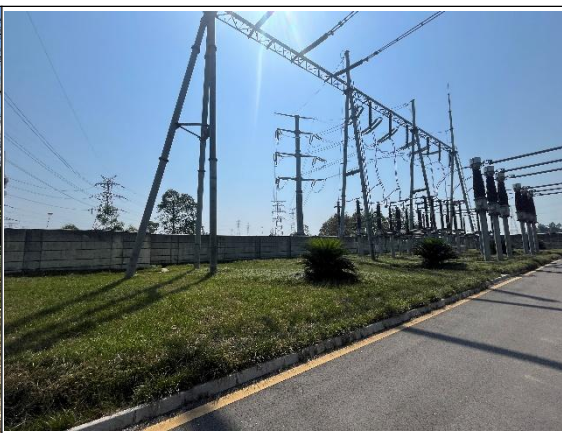
站内 220kV 间隔扩建区域
