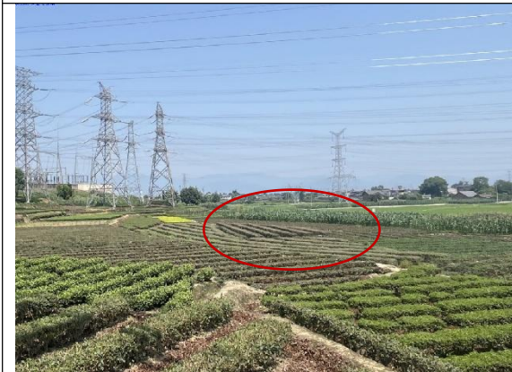
南天—圣达二线拟建 N1 塔基现状
