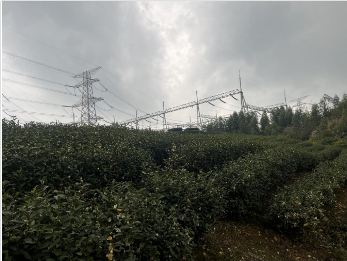
站外主变扩建区域现状
