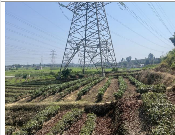
拟拆除铁塔现状
