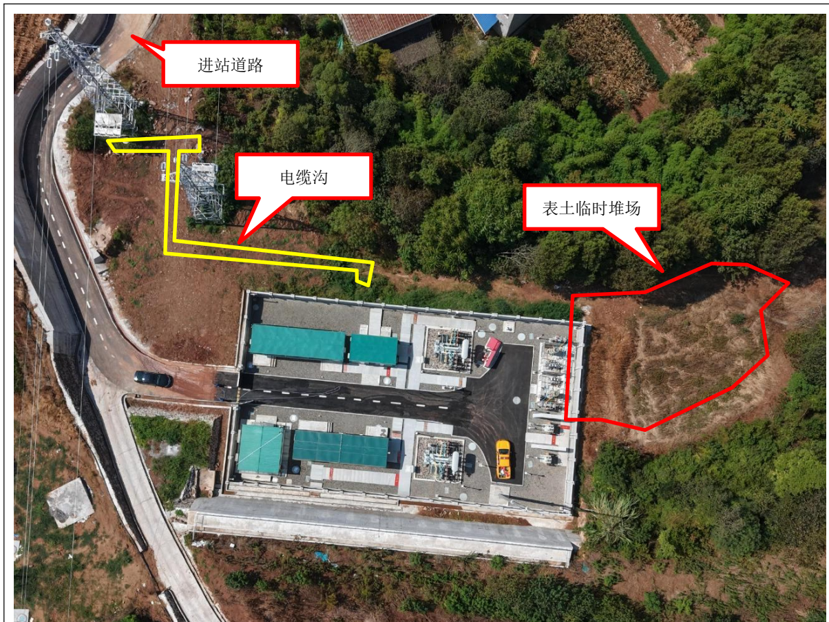
新建悦来 35kV 变电站
