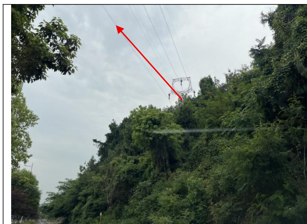
磨家梁-花菱 110kV 线路增容工程起点塔
