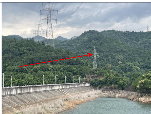
安县-花菱 110kV 线路增容工程沿线地形地貌
