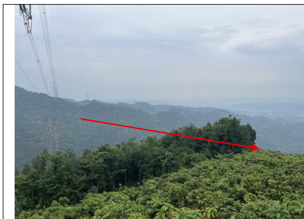
安县-花菱 110kV 线路增容工程沿线地形地貌
