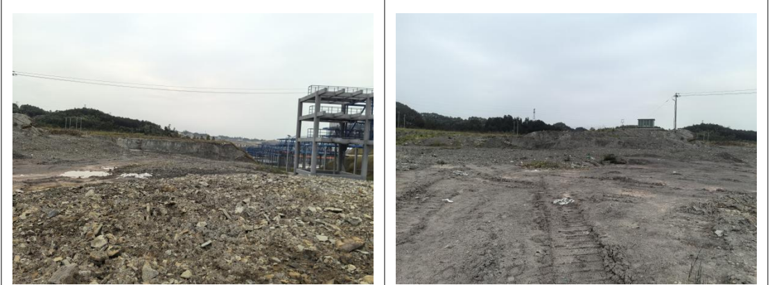
拟建先锋变电站场地现状
