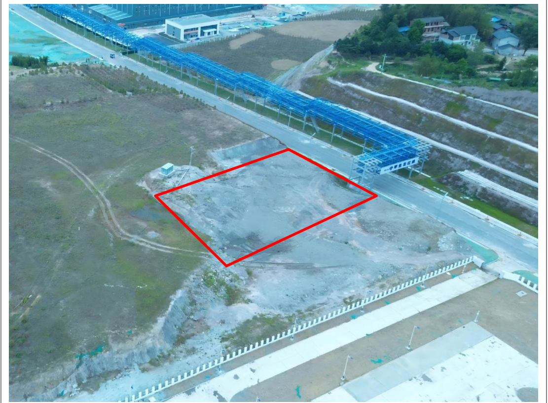
拟建先锋变电站场地现状
