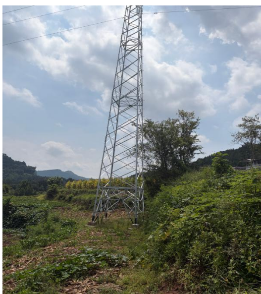
塔基区及塔基施工场地区（2026.8）
