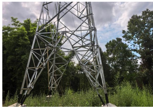
塔基区及塔基施工场地区（2026.8）
