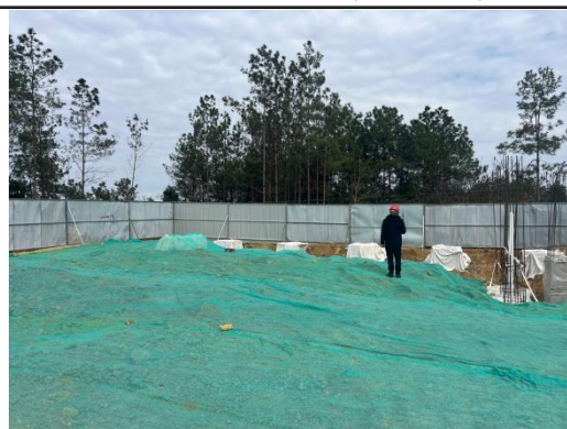
变电站工程施工过程密目网苫盖（2026.3）
