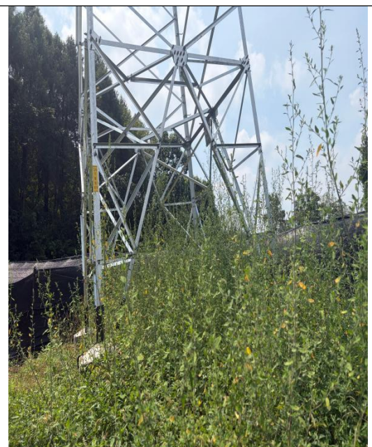
塔基区及塔基施工场地区（2026.8）
