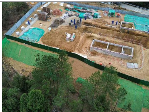
变电站工程施工过程密目网苫盖（2026.3）
