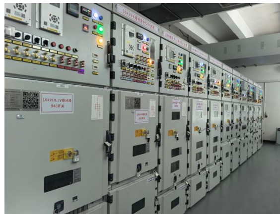
新增 10kV 出线
