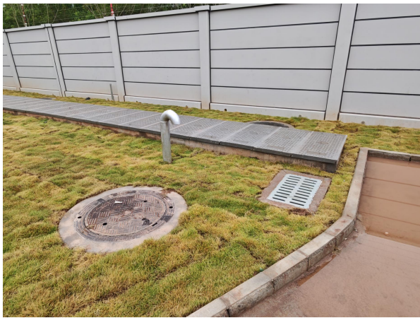
变电站雨水口现状
