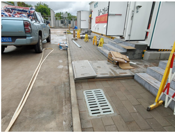
变电站雨水口现状
