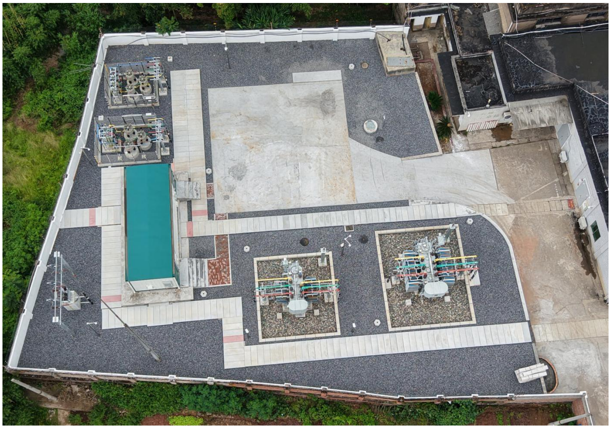
马岭 35kV 变电站碎石地坪
