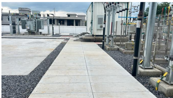
站内北侧现状
