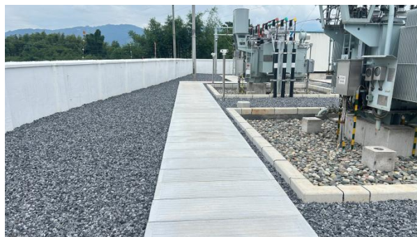
站内西侧主变场地碎石地坪
