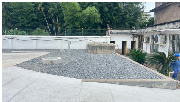
站内南侧现状
