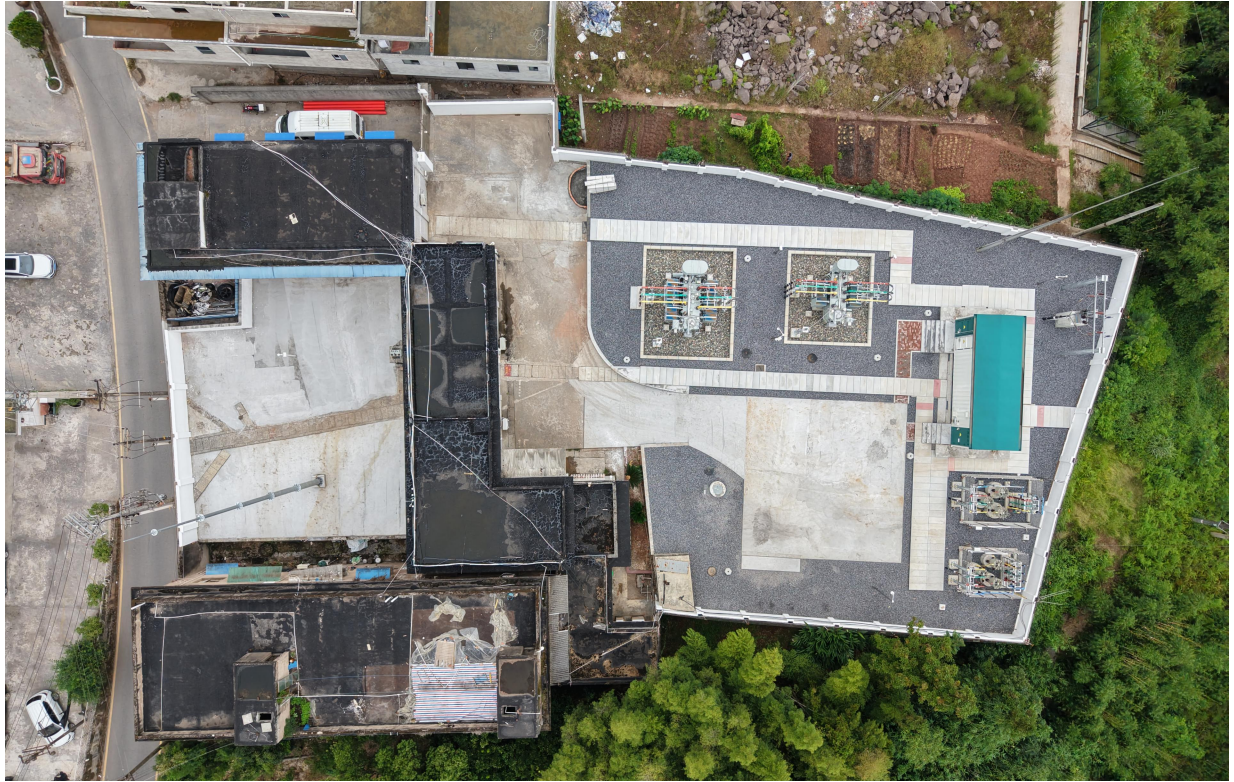
马岭 35kV 变电站现状
