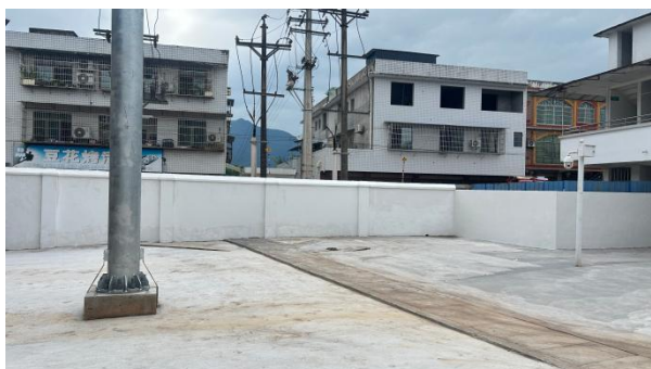
站内南侧现状
