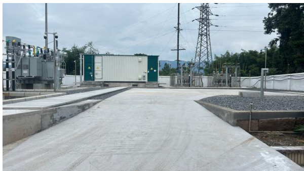
站内北侧现状
