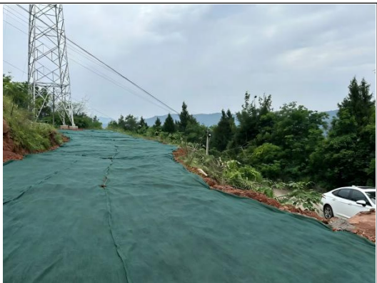
塔基进场道路施工过程密目苫盖（2026.4）
