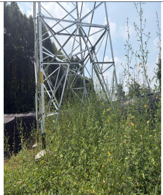
塔基区及塔基施工场地区（2026.8）
