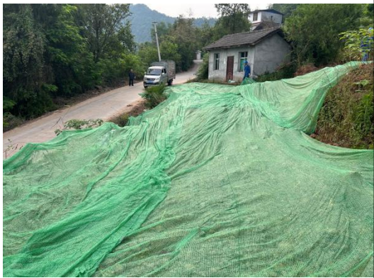
塔基进场道路施工过程密目苫盖（2026.4）
