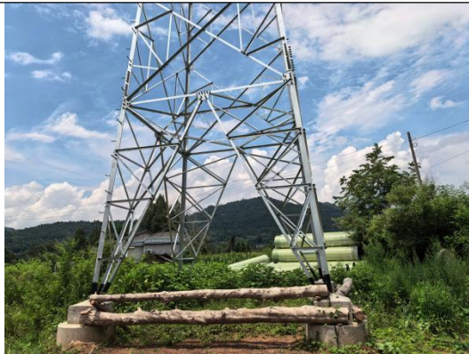
塔基区及塔基施工场地区（2026.8）
