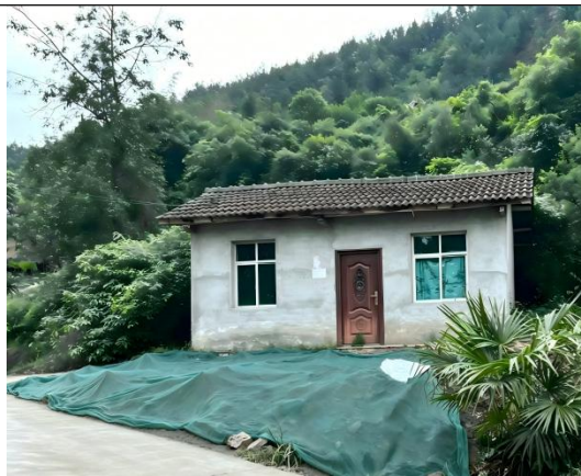
塔基进场道路施工过程密目苫盖（2026.4）
