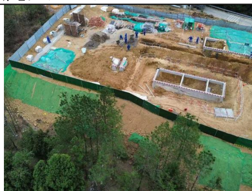
变电站工程施工过程密目网苫盖（2026.3）
