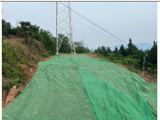
塔基进场道路施工过程密目苫盖（2026.4）
