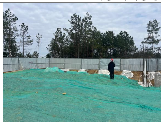
变电站工程施工过程密目网苫盖（2026.3）
