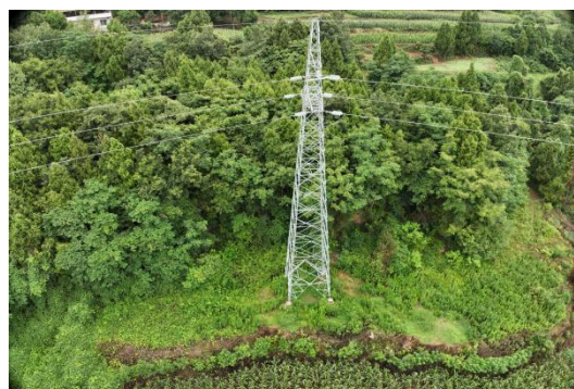
N29#新建铁塔
