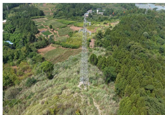
N24#新建铁塔
