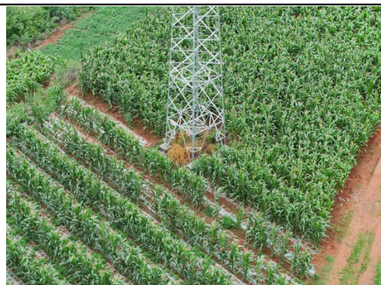
N31#新建铁塔
