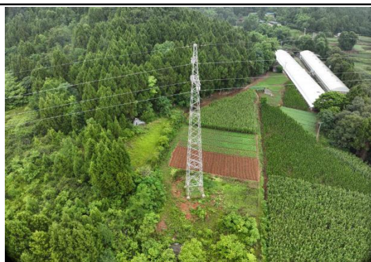
N63#新建铁塔
