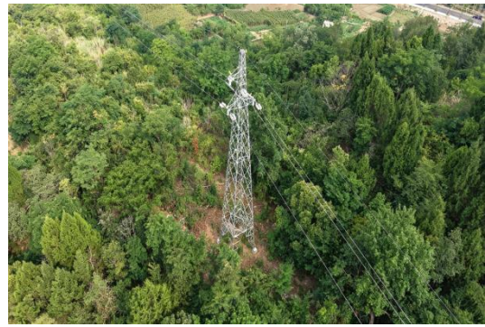
N2#新建铁塔
