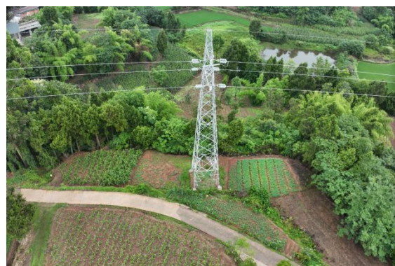
N66#新建铁塔
