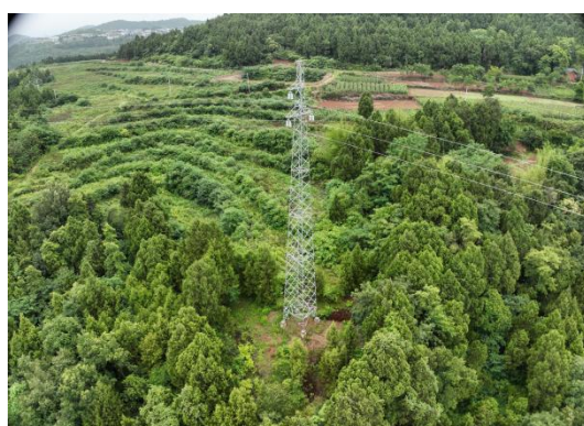
N27#新建铁塔
