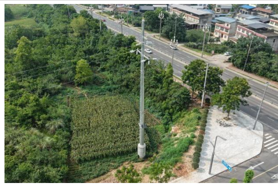
N5#新建铁塔
