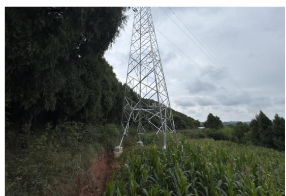
N17#新建铁塔
