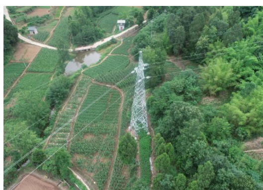
N5#新建铁塔
