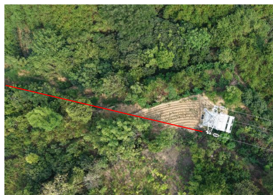
N13#新建铁塔及新建电缆通道
