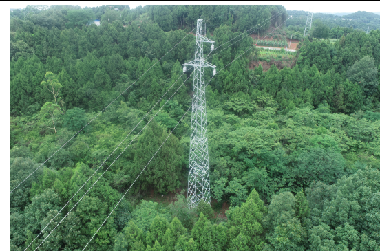
N6#新建铁塔
