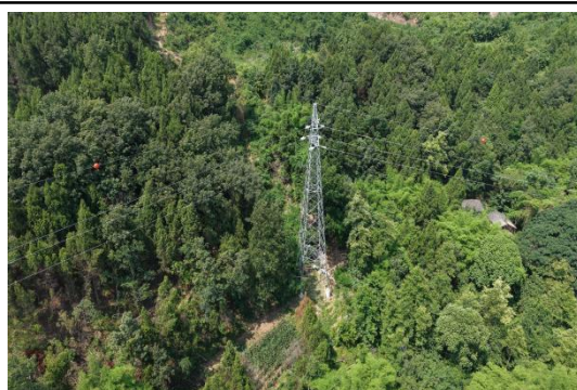
N30#新建铁塔
