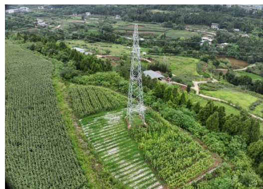
N68#新建铁塔
