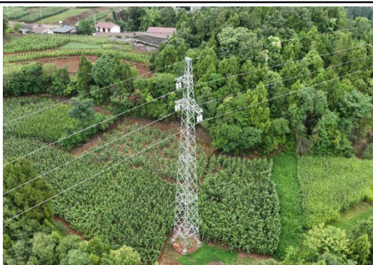
N58#新建铁塔
