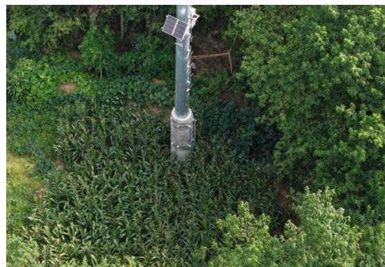
N7#新建铁塔
