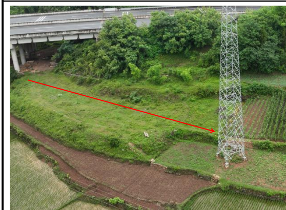
集凤-富兴 N22#塔位施工道路现状
