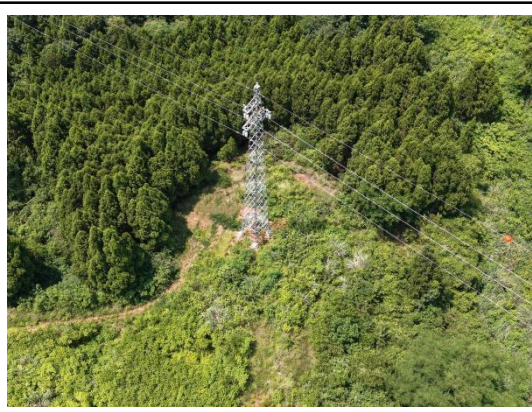
N35#新建铁塔
