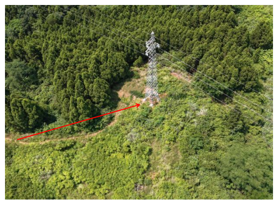
中江-富兴 N35#塔位施工道路现状
