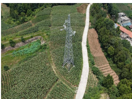
N49#新建铁塔
