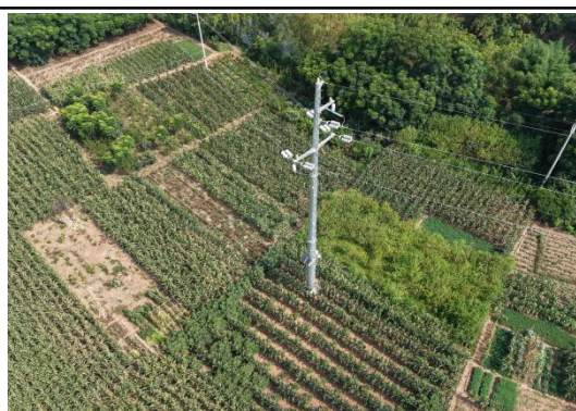
N17#新建铁塔
