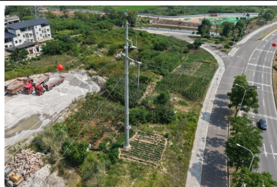
N21#新建铁塔
