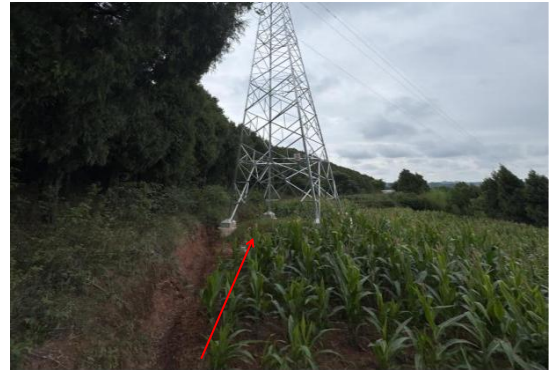
集凤-富兴 N17#塔位施工道路现状
