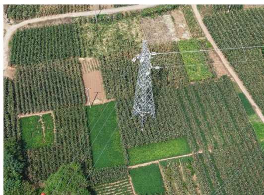
N26#新建铁塔
