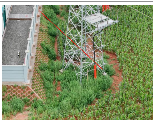
N32#新建铁塔及新建电缆通道
