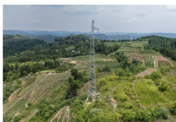
N48#新建铁塔
