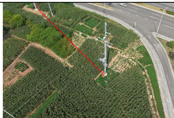
N19#新建铁塔及新建电缆通道
