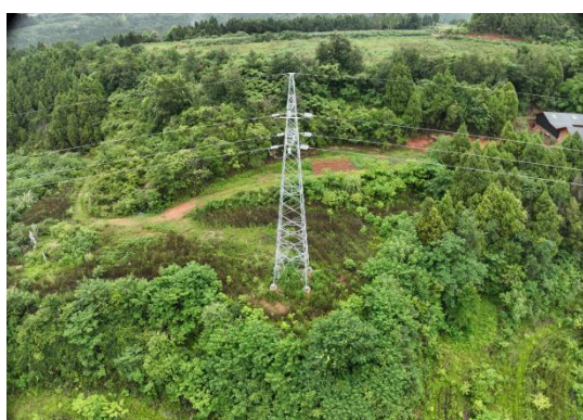
N26#新建铁塔
