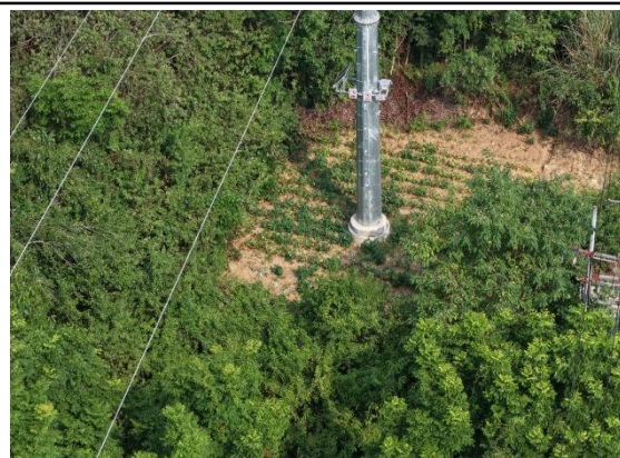
N10#新建铁塔
