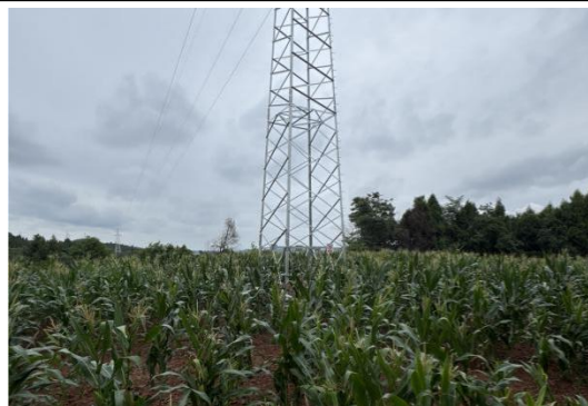
N9#新建铁塔
