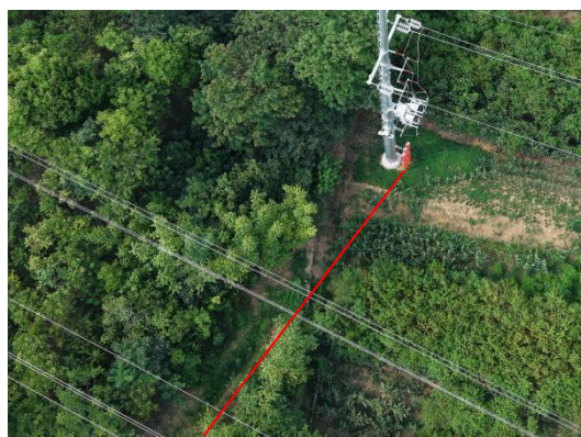
N14#新建铁塔及新建电缆通道
