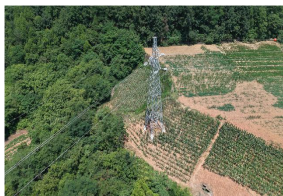
N37#新建铁塔
