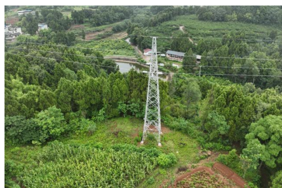
N64#新建铁塔
