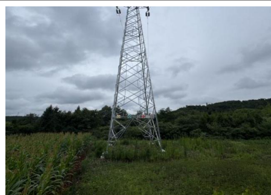
N10#新建铁塔
