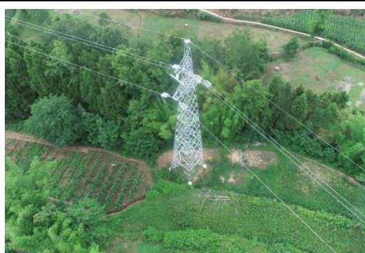
N3#新建铁塔
