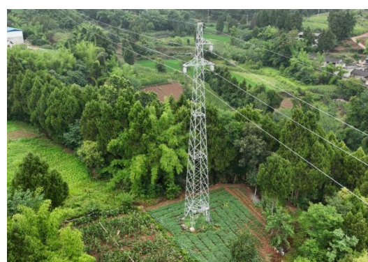
N65#新建铁塔
