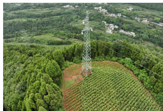
N30#新建铁塔及新建电缆通道
