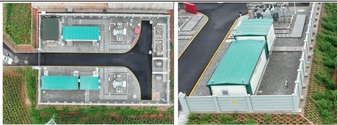
富兴 35kV 变电站现状
