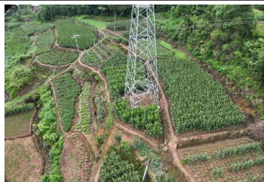
N21#新建铁塔
