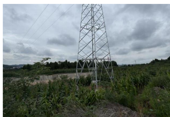
N15#新建铁塔
