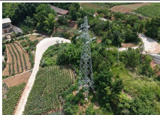
N45#新建铁塔
