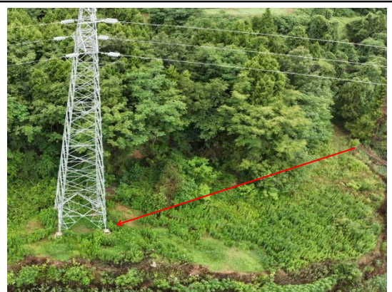
集凤-富兴 N29#塔位施工道路现状
