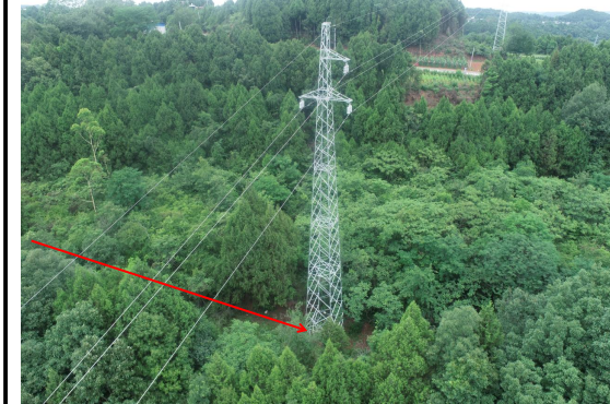
集凤-富兴 N6#塔位施工道路现状
