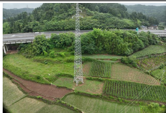
N22#新建铁塔
