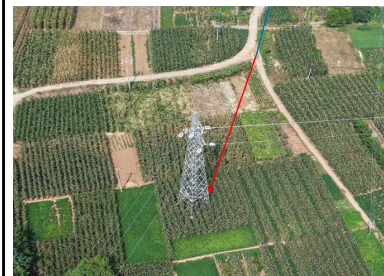
中江-富兴 N26#塔位施工道路现状
