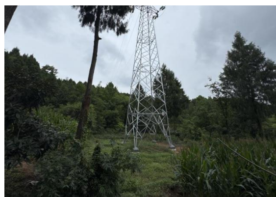
N12#新建铁塔
