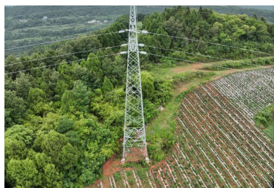
N70#新建铁塔
