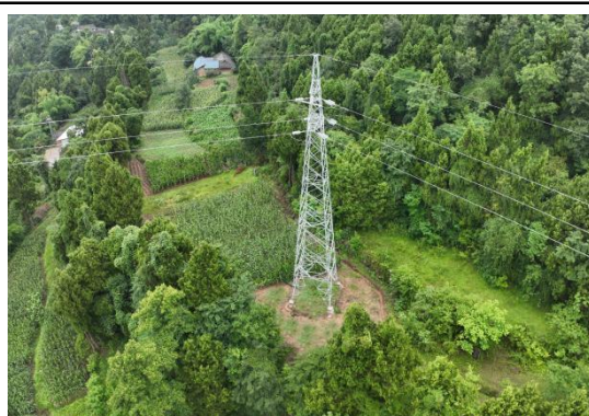
N23#新建铁塔
