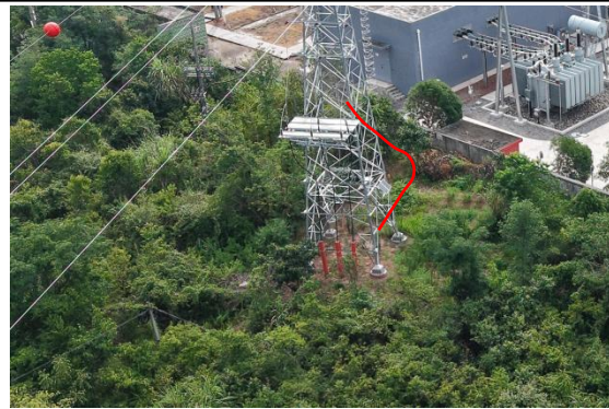
N1#新建铁塔及新建电缆通道
