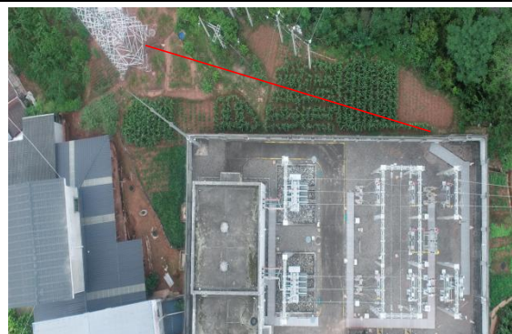
N1#新建铁塔及新建电缆通道
