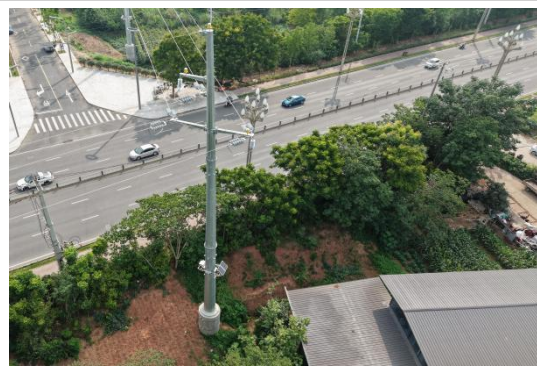
N6#新建铁塔
