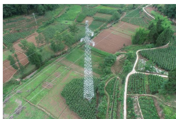
N4#新建铁塔
