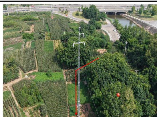
中江-富兴 N18#塔位施工道路现状
