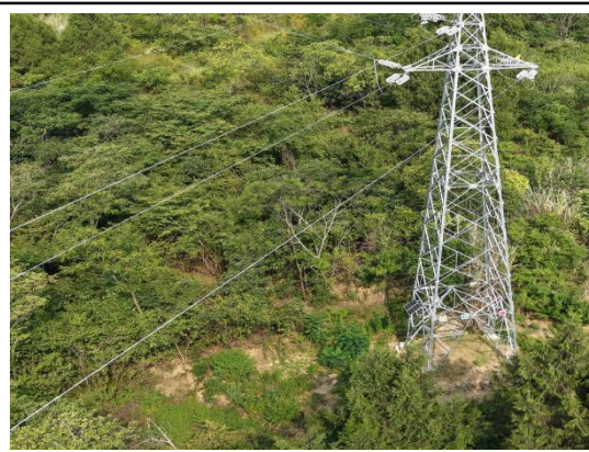
N11#新建铁塔
