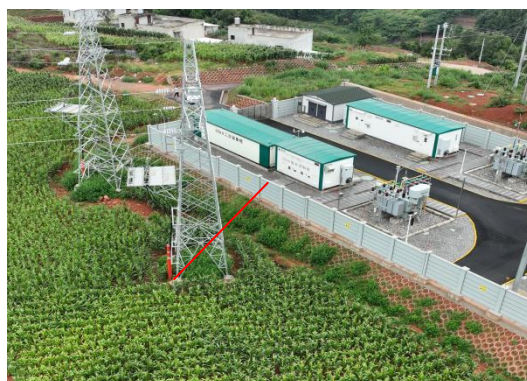
N71#新建铁塔及新建电缆通道
