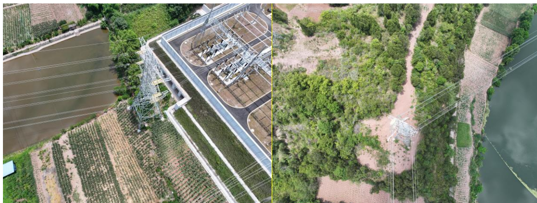
图 1.3-7 无人机航拍监测塔基区各阶段扰动情况
