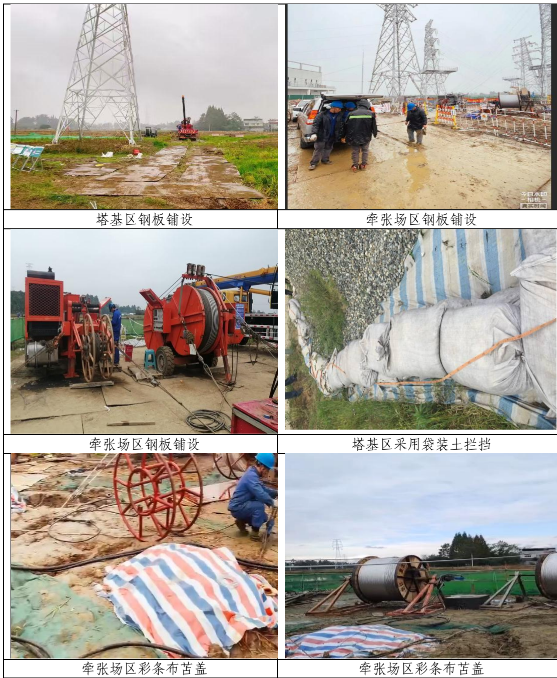
图 4.3-1 临时措施实施照片
