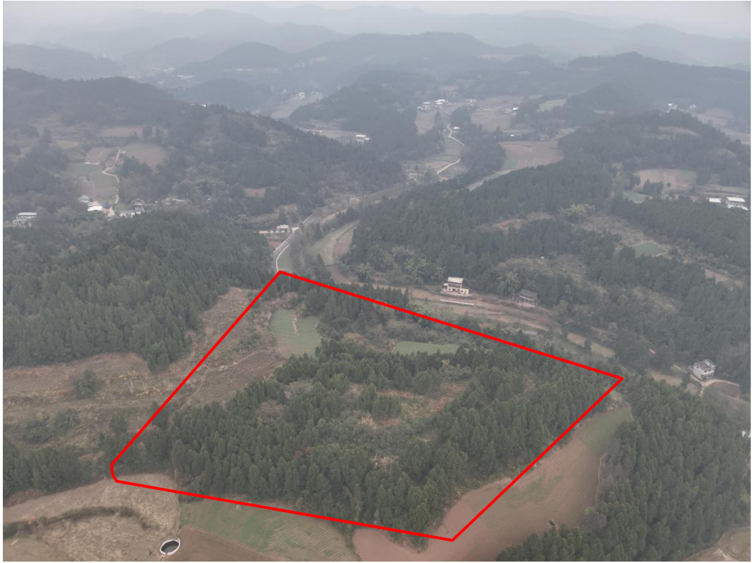
(1) 通仙变电站现状
